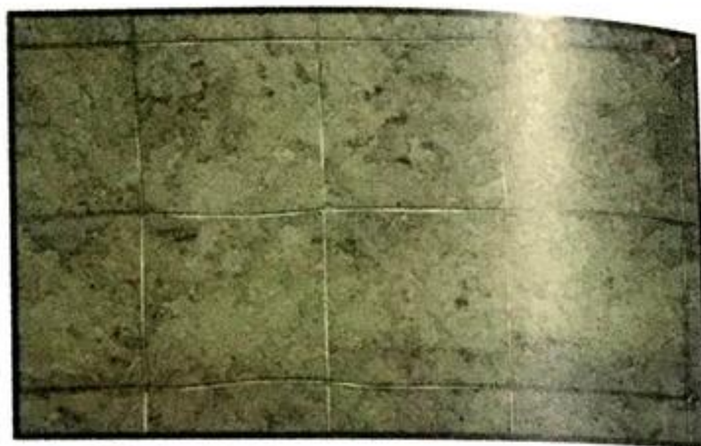
a) Rehabilitación de estructuras de adobe con malla de alambre soldado, anclada con grapas metálicas. Primero se aplicó una capa de mortero y sobre ella se colocó la malla para ser recubierta por otra capa de mortero.
