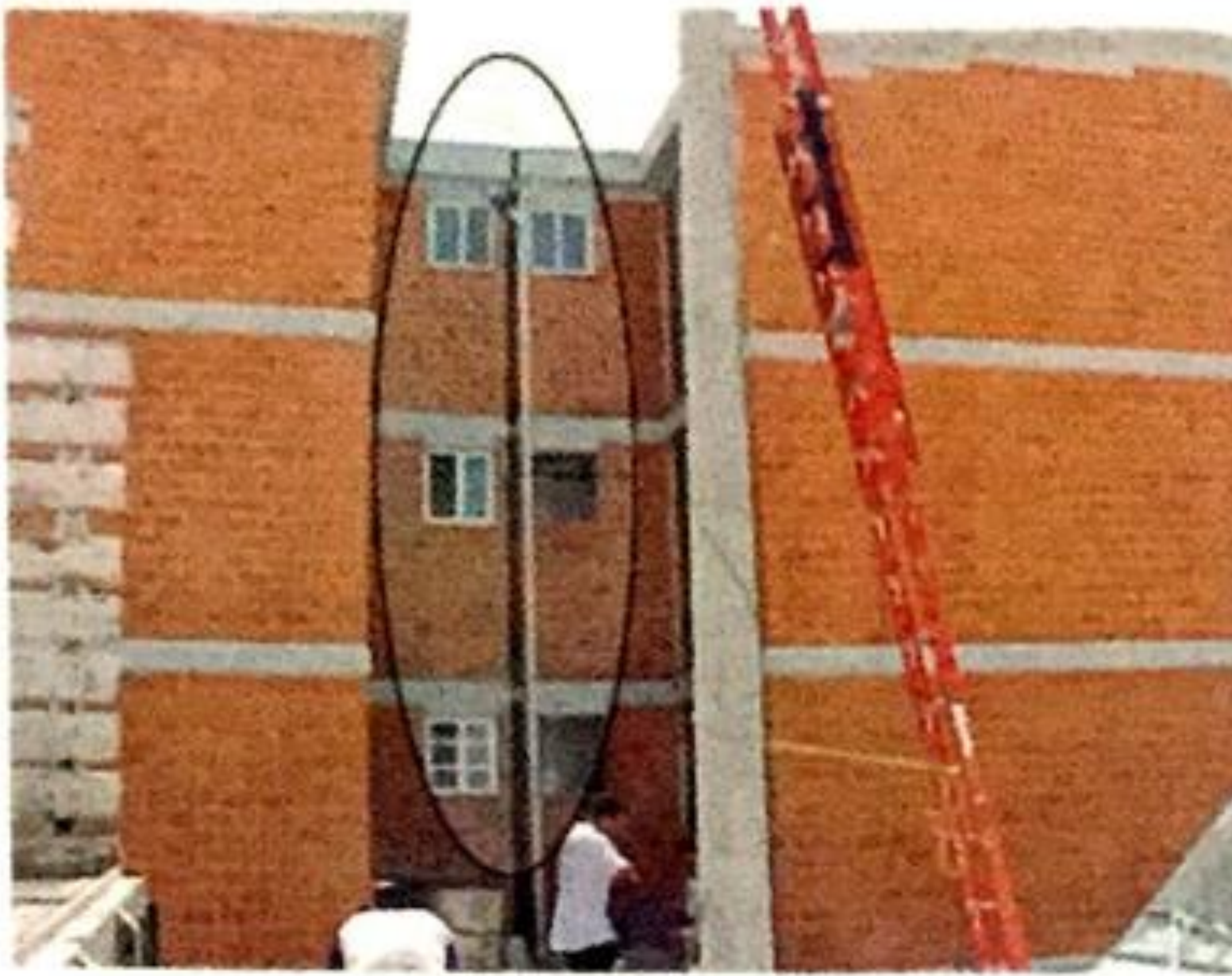
Figura 9.15 Hundimiento diferencial en un conjunto habitacional en suelo altamente compresible.
