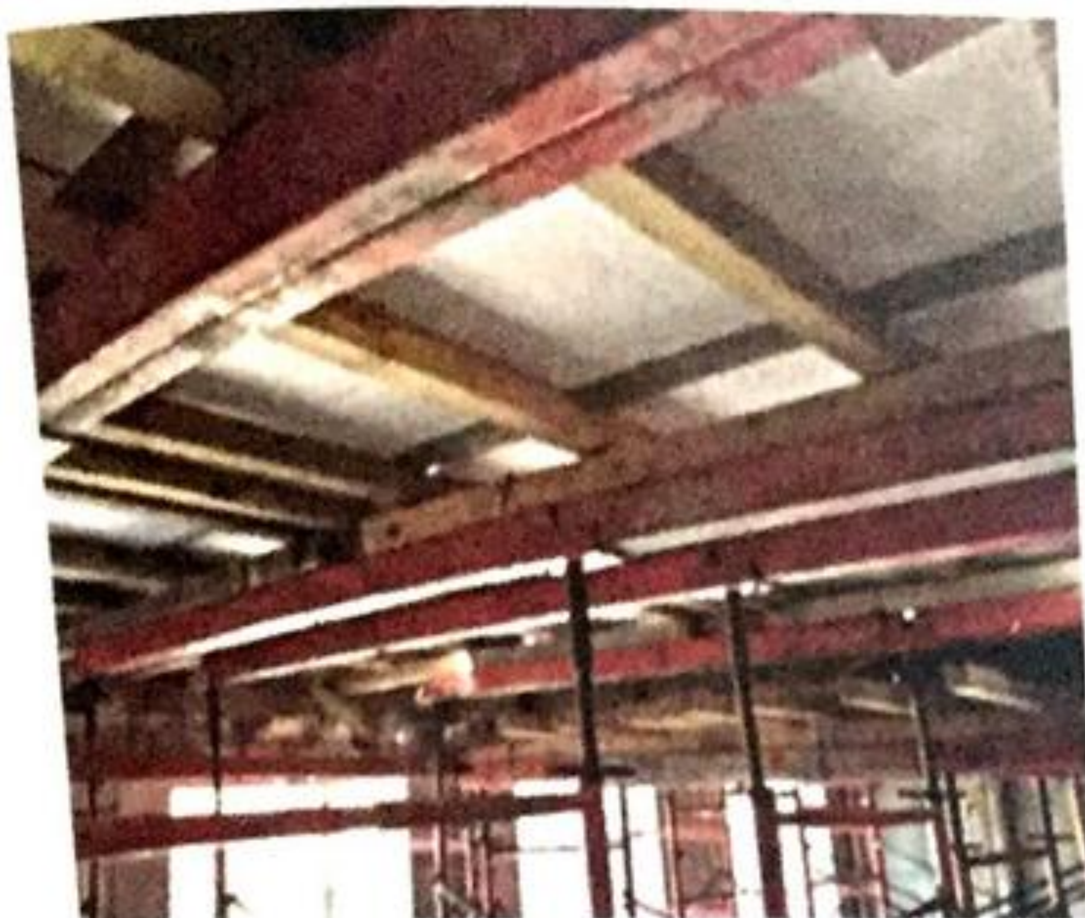
Figura 9.47 Apuntalamiento del sistema de vigueta.
