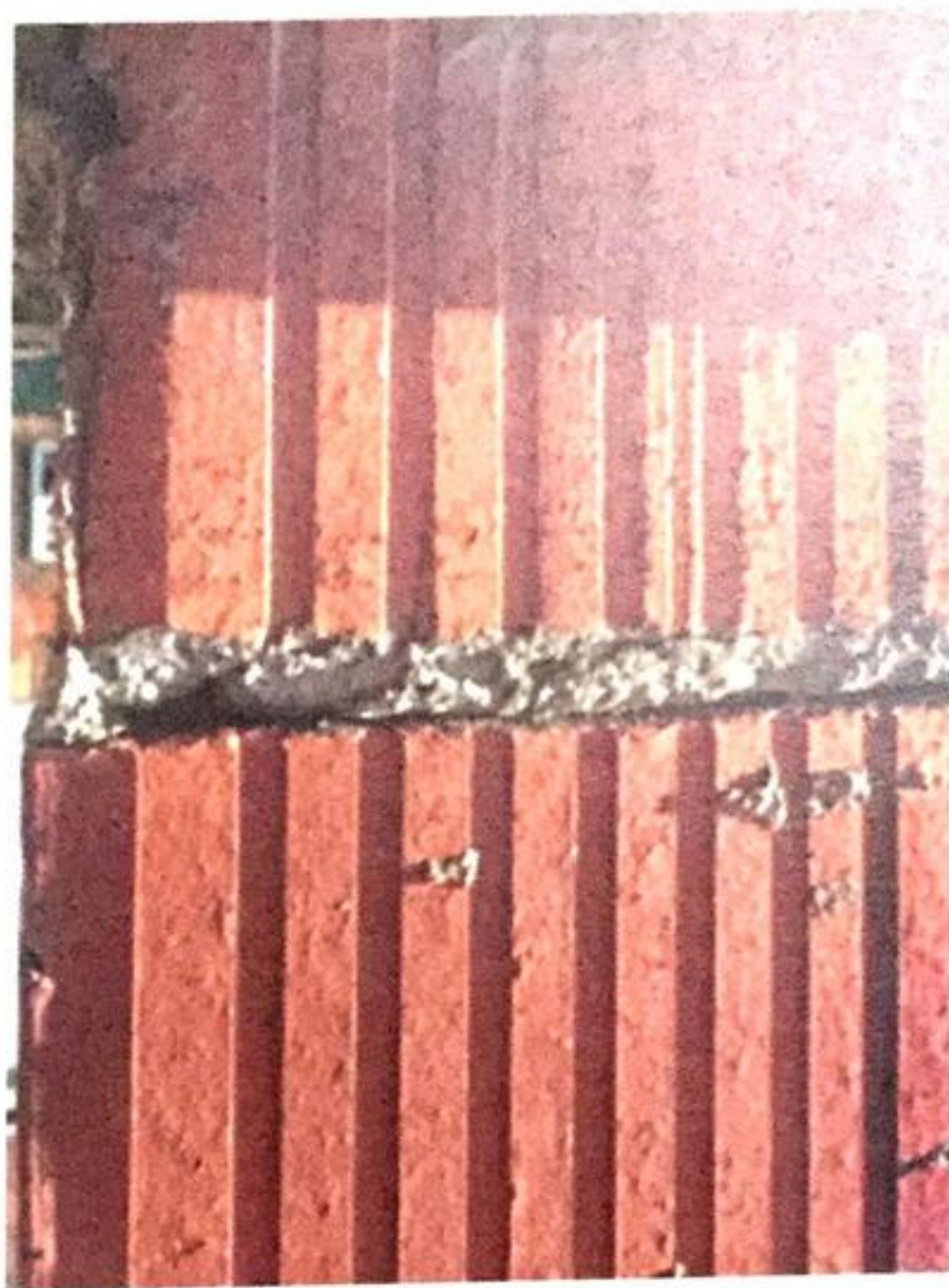
Figura 2.4 Efecto de absorción excesiva en piezas de barro.
