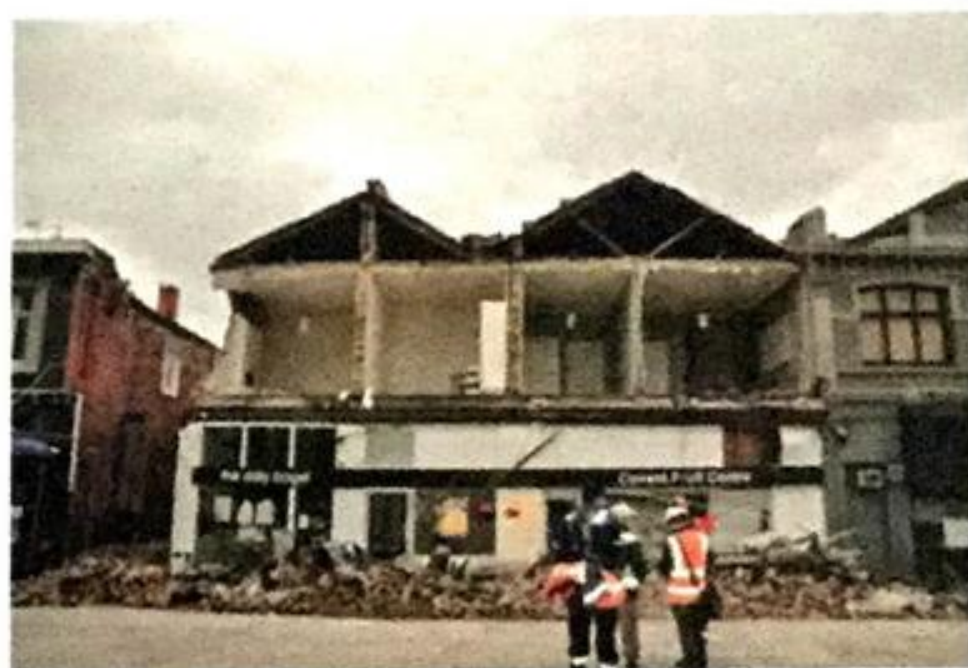
Figura 3.17 Falla fuera del plano en mampostería no reforzada (Griffith e Ingham, 2011).
