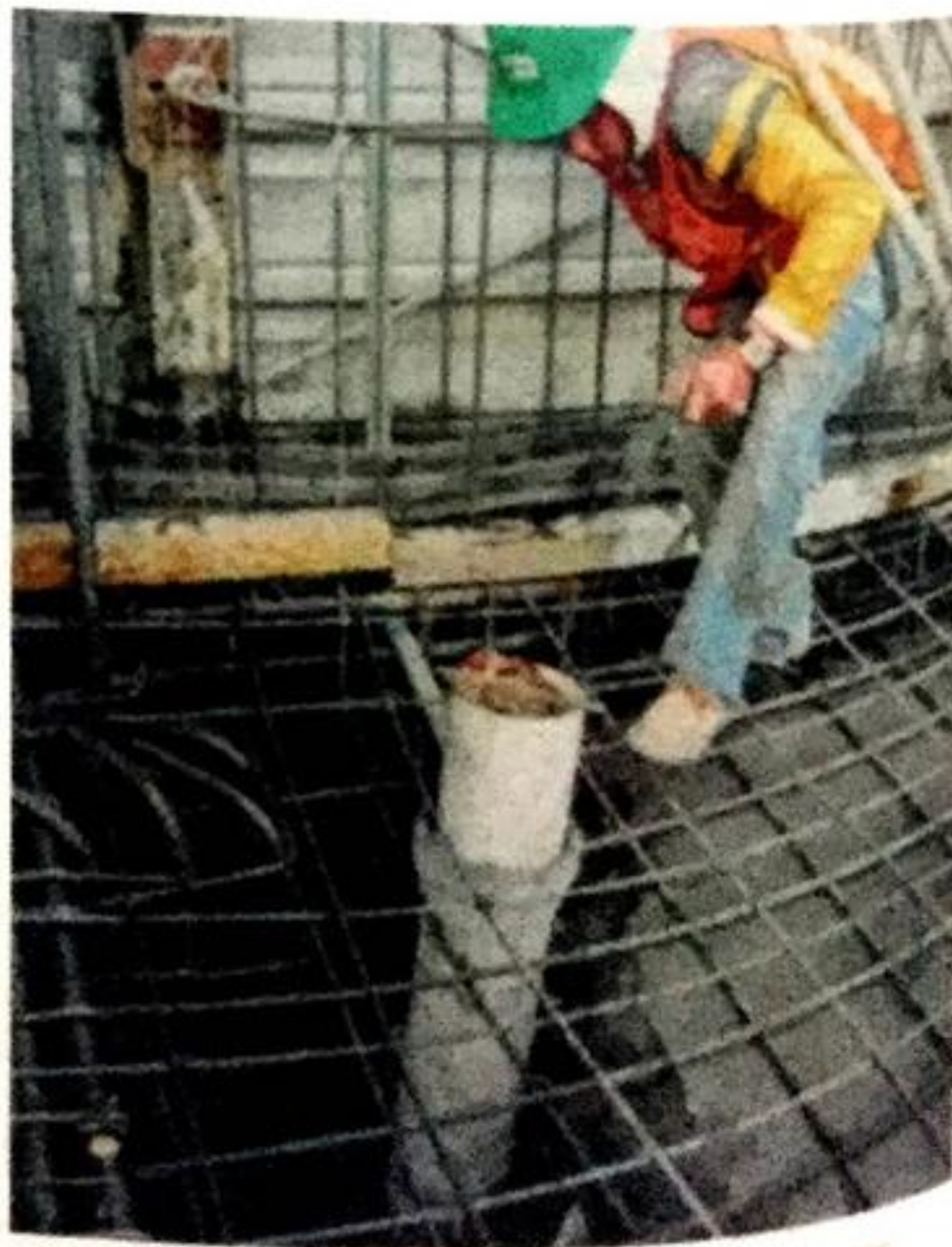
Figura 9.25 Detallado del paso de instalaciones
