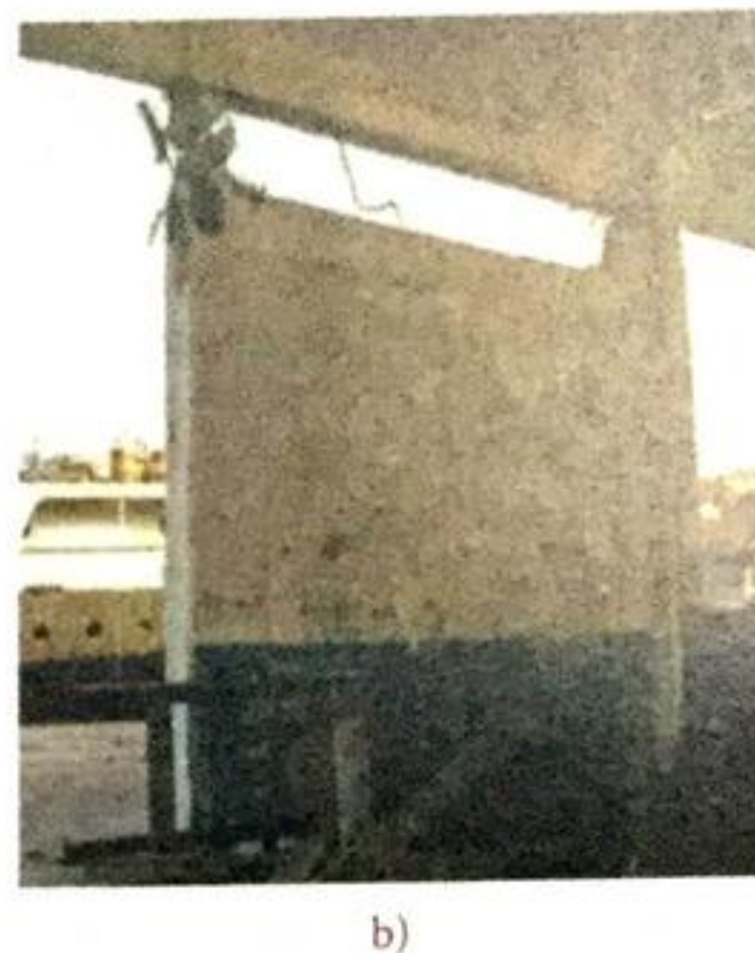
Figura 3.32 a) Efecto de columna corta en muro diafragma de altura incompleta (Meli, 1992); b) falla de columna corta en marco con muro (Alcocer, Flores & Reyes, 2003).
