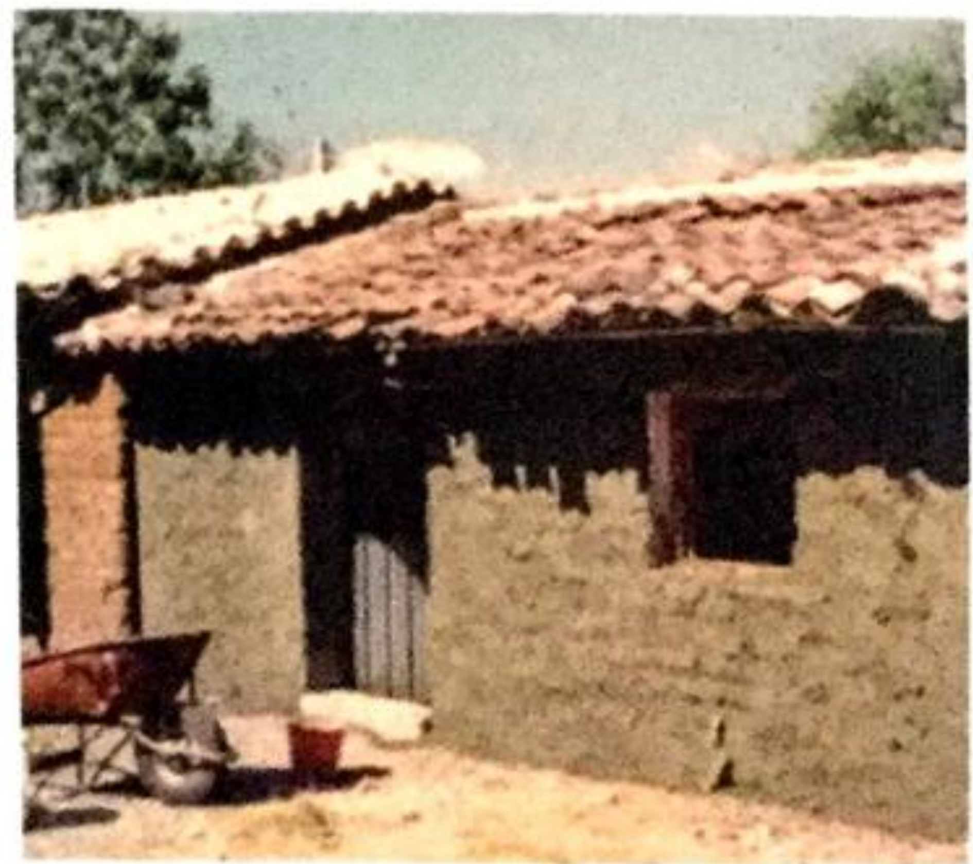
Figura 10.55 Ejemplo 2. Colocación de mortero a base de cemento sobre malla de gallinero.
