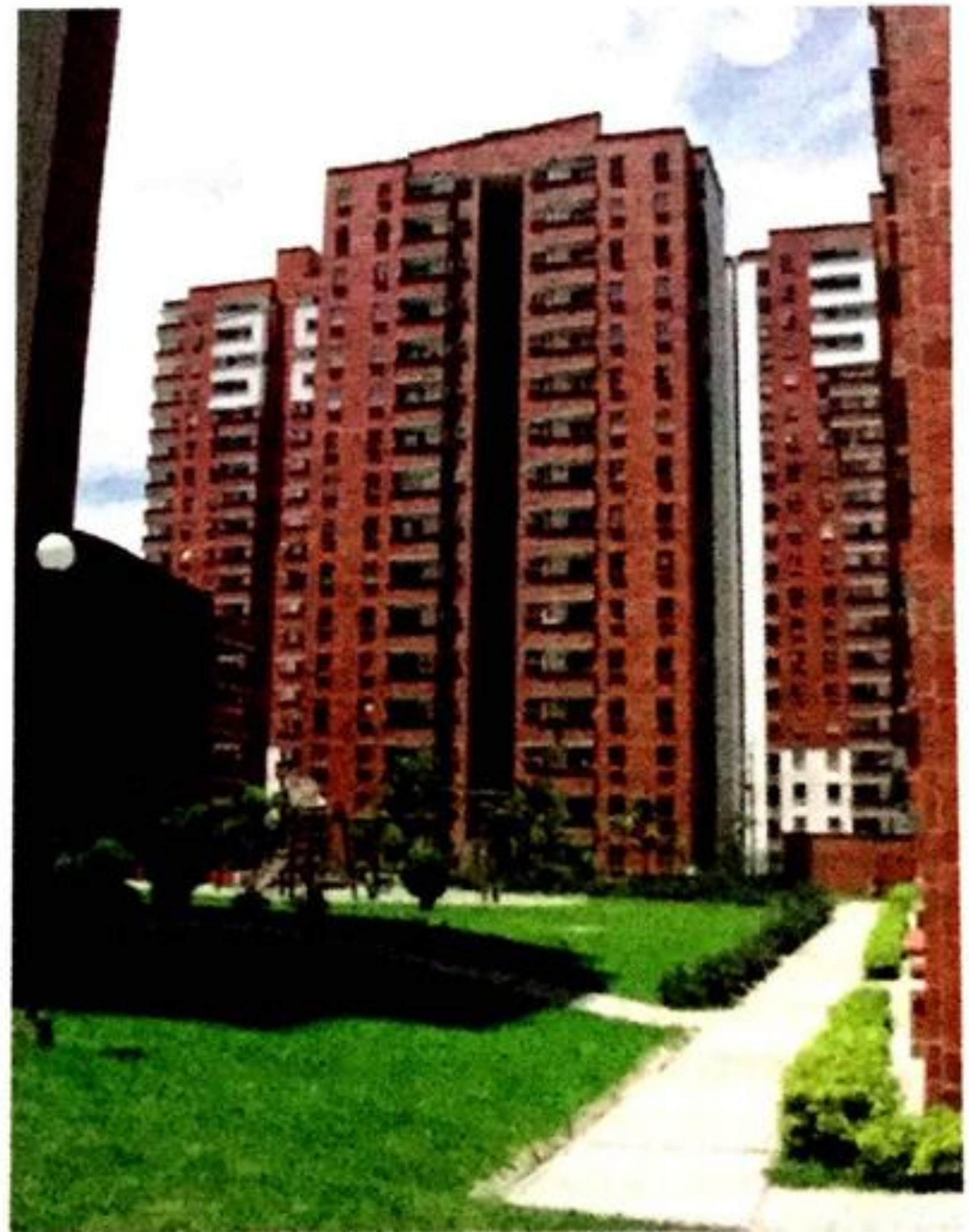
Figura 1.14 Edificios altos en Colombia, estructurados con muros de mampostería y muros de concreto reforzado. (Fuente: Ing. Jesús Arango Tobón.)
