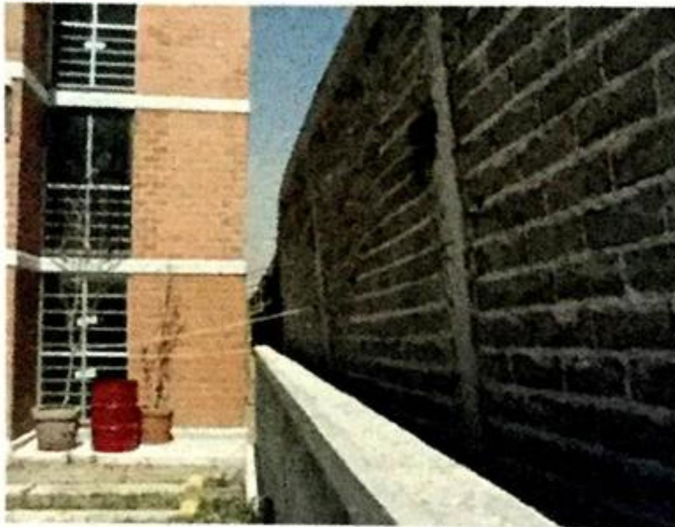
Figura 9.16 Colindancia con muro con construcción somera.
