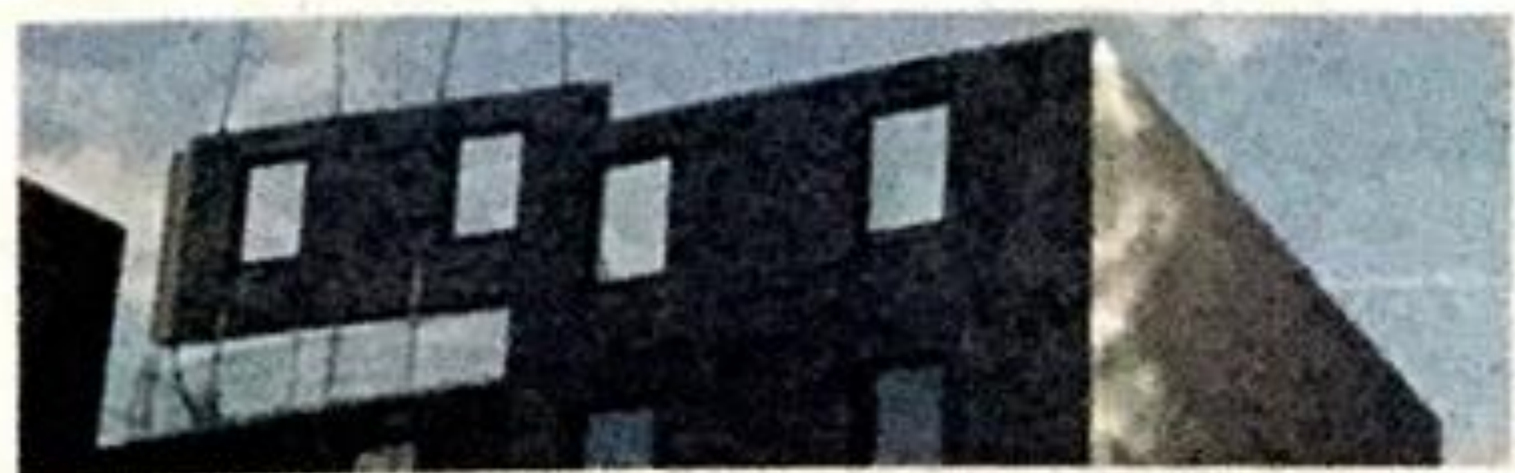
Figura 12.18 Maniobras para el montaje de muros de mampostería prefabricada. FP McCann Homes [fotografía]. Obtenida de http://fpmccann.co.uk .
