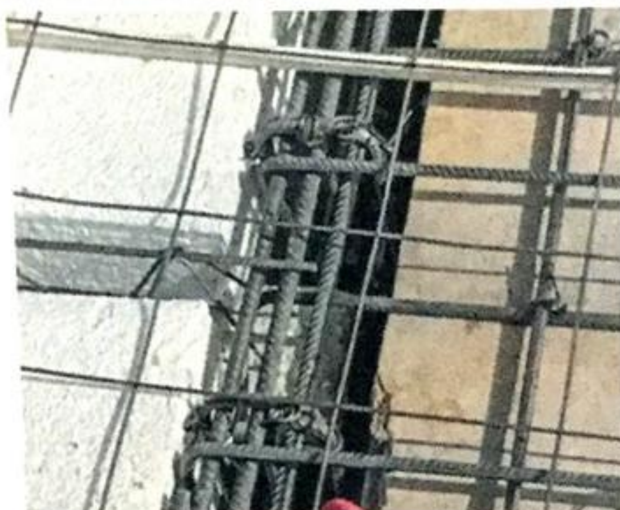
Figura 9.48 Apoyo de viguetas.
