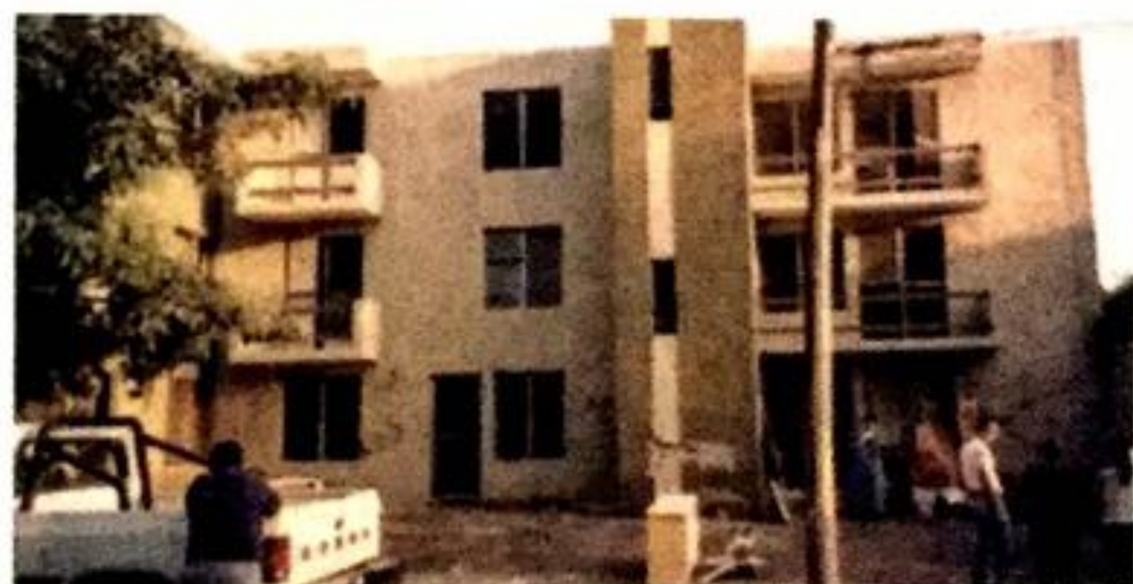
Figura 3.23 Formación de piso blando en planta baja debido a una baja densidad de muros (SMIS y EERI, 2006).
