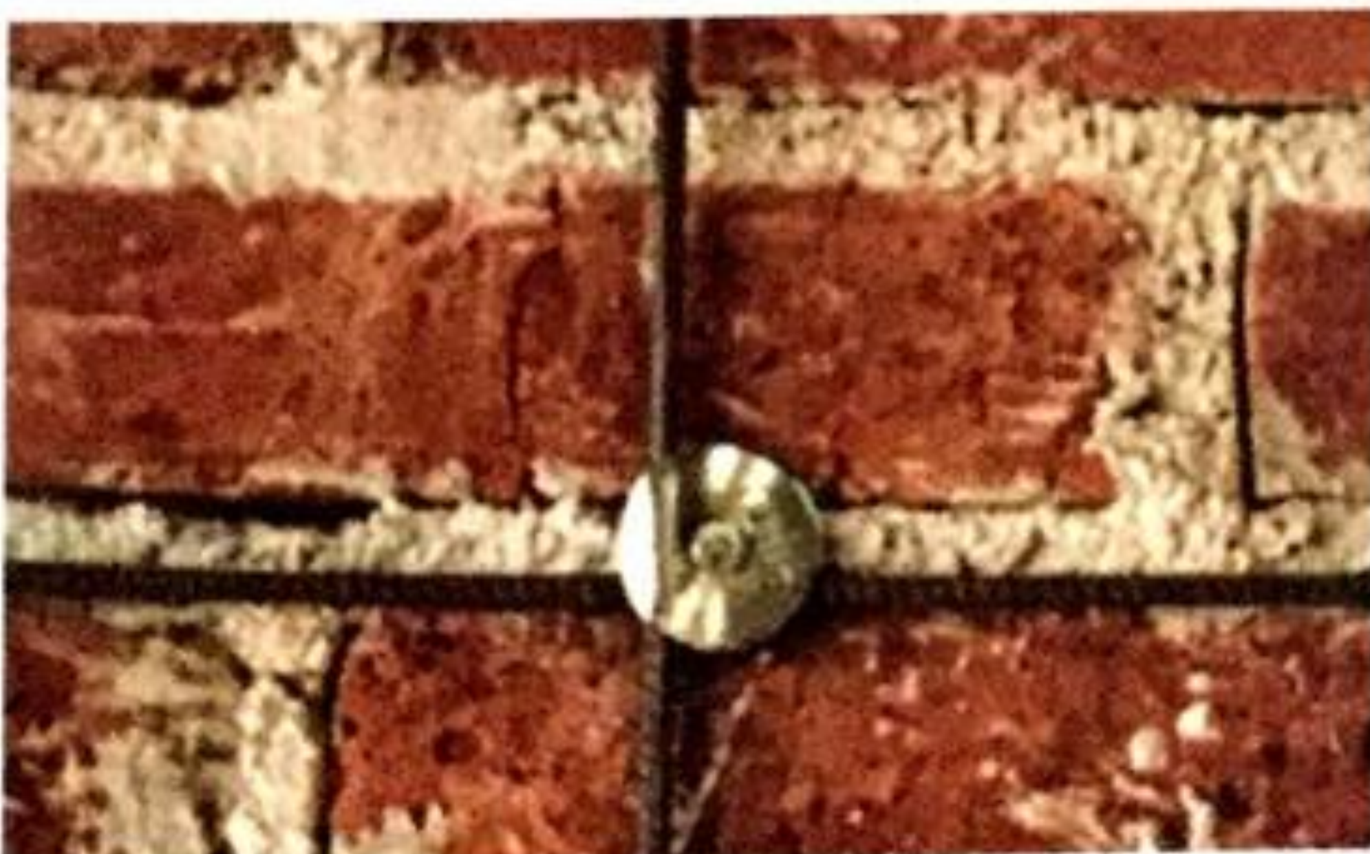
Figura 10.49 Ejemplo 1. Fijación con clavos de percusión o de impacto de malla de alambre soldado.
