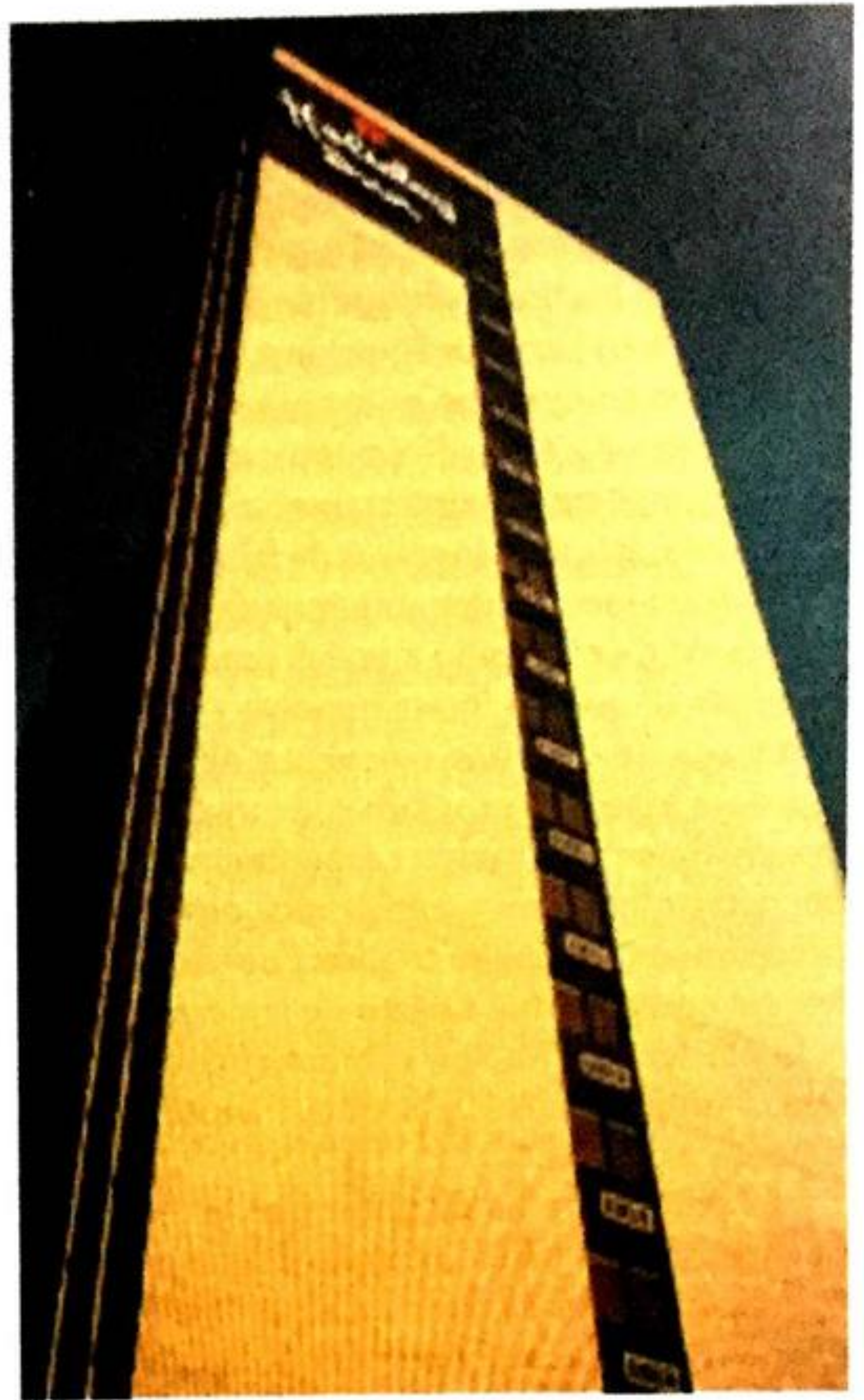
Figura 1.16 Edificio de 17 niveles de mampostería reforzada interiormente en Northridge, Estados Unidos, sin reporte de daños estructurales después del sismo de 1994 (Klingner R., 2004).
