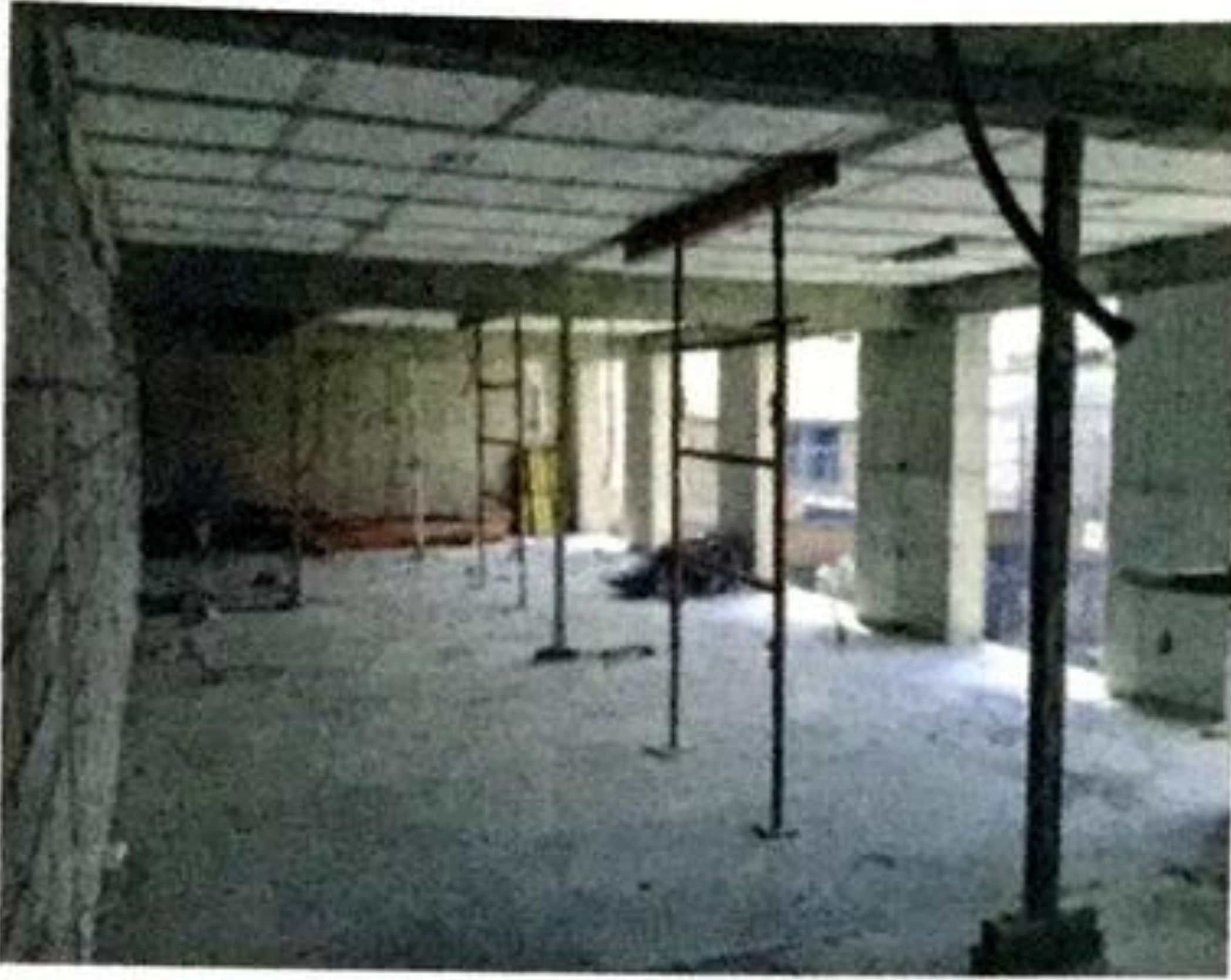
Figura 9.39 Apuntalamiento de losa después del descimbrado.
