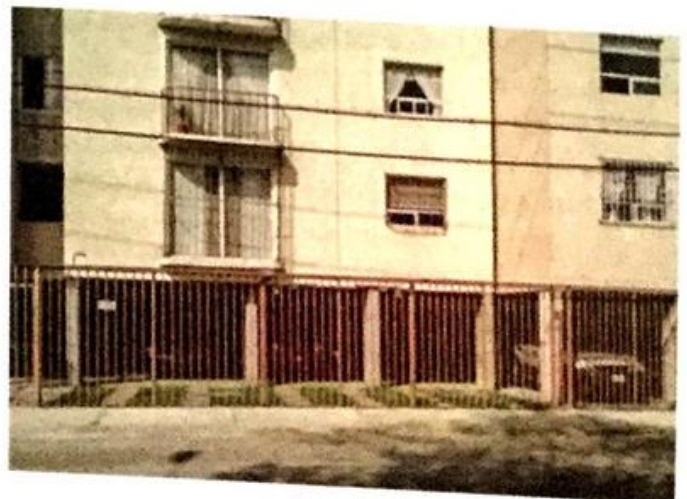
Figura 4.7 Ejemplos de construcciones con entrepisos blandos. (Continúa).
