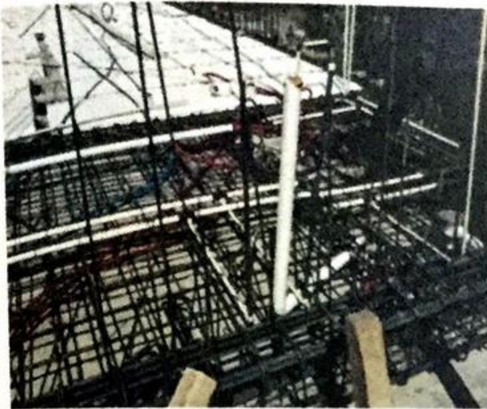
Figura 9.38 Losa maciza con instalaciones.
