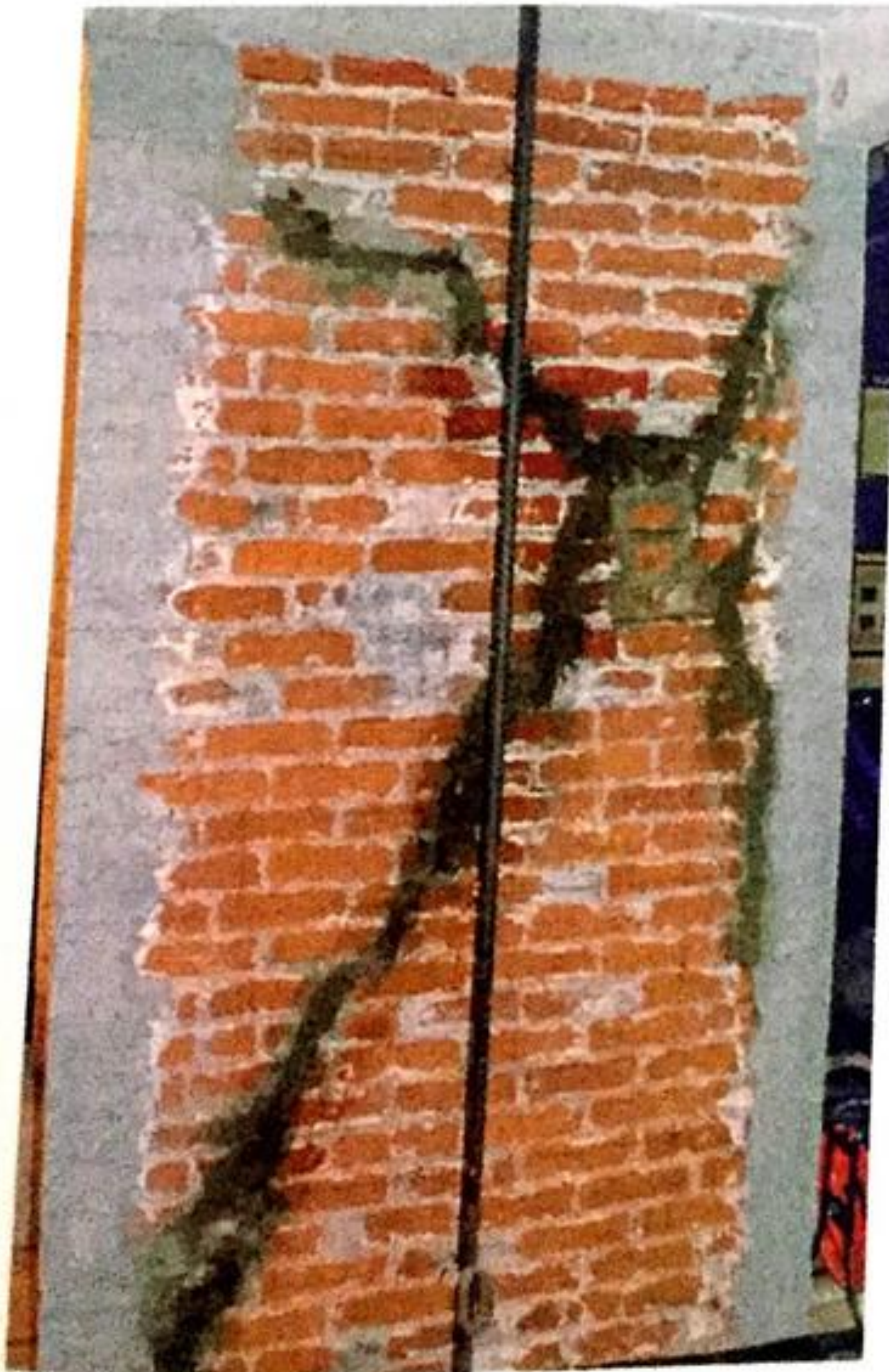
Figura 10.19 Muro de la figura 10.15 reparado mediante rajuelas y reemplazo de piezas y concreto.
