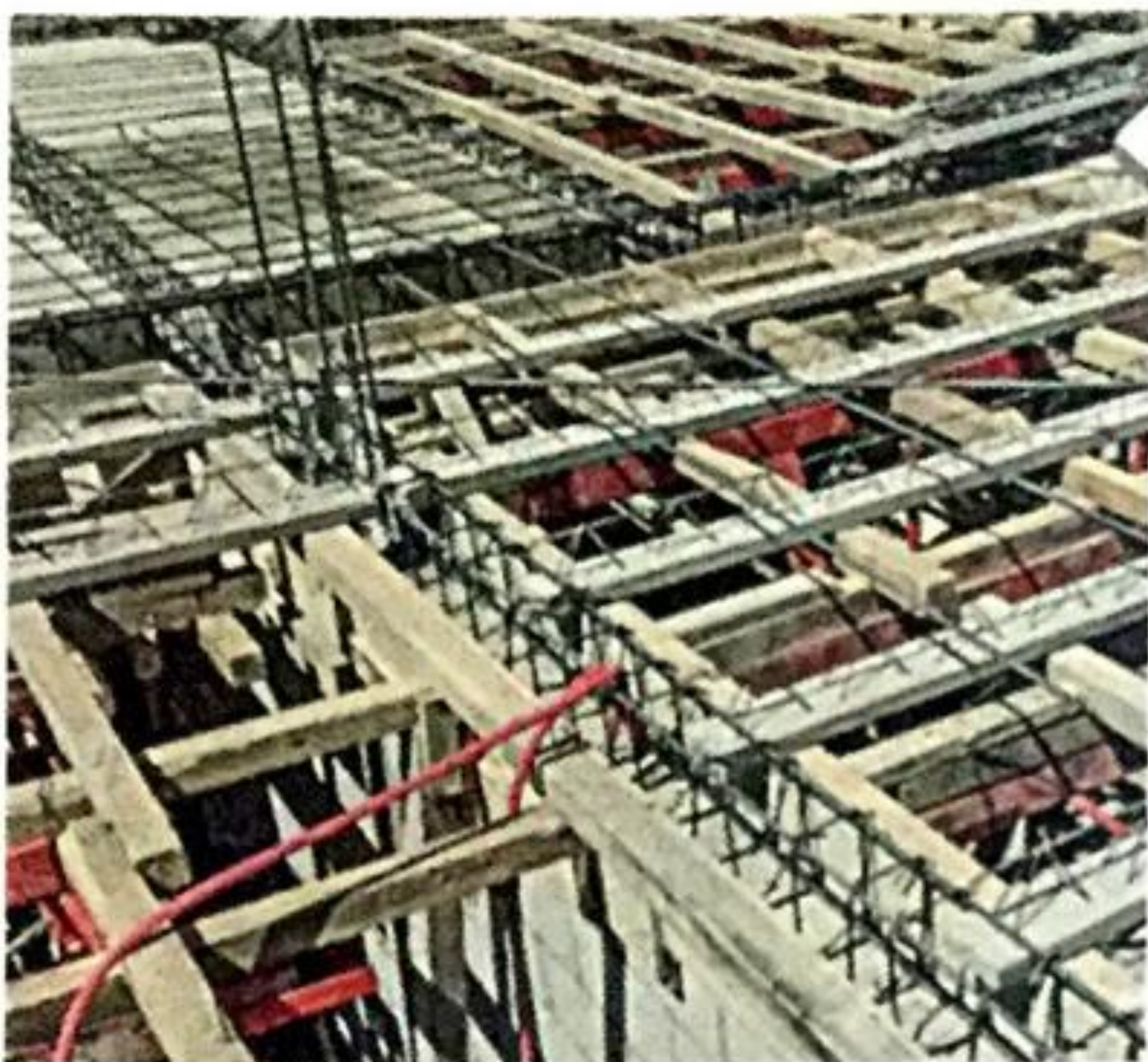
Figura 9.44 Viguetas de alma abierta correctas.
