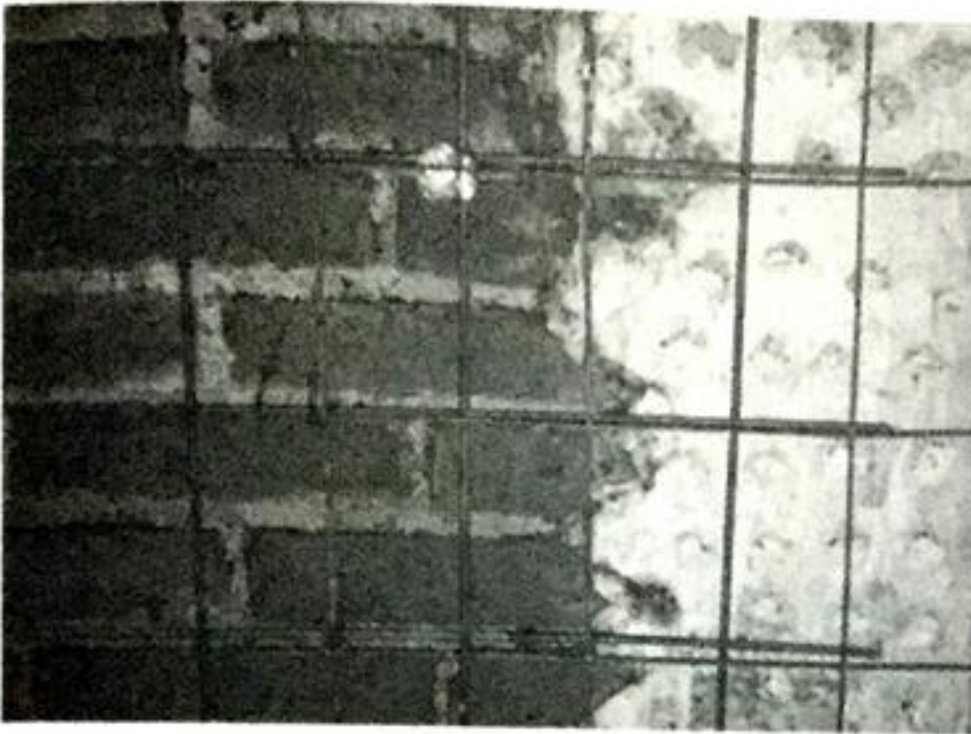
Figura 10.30 Confinamiento de un castillo con mallas metálicas que han sido traslapadas.
