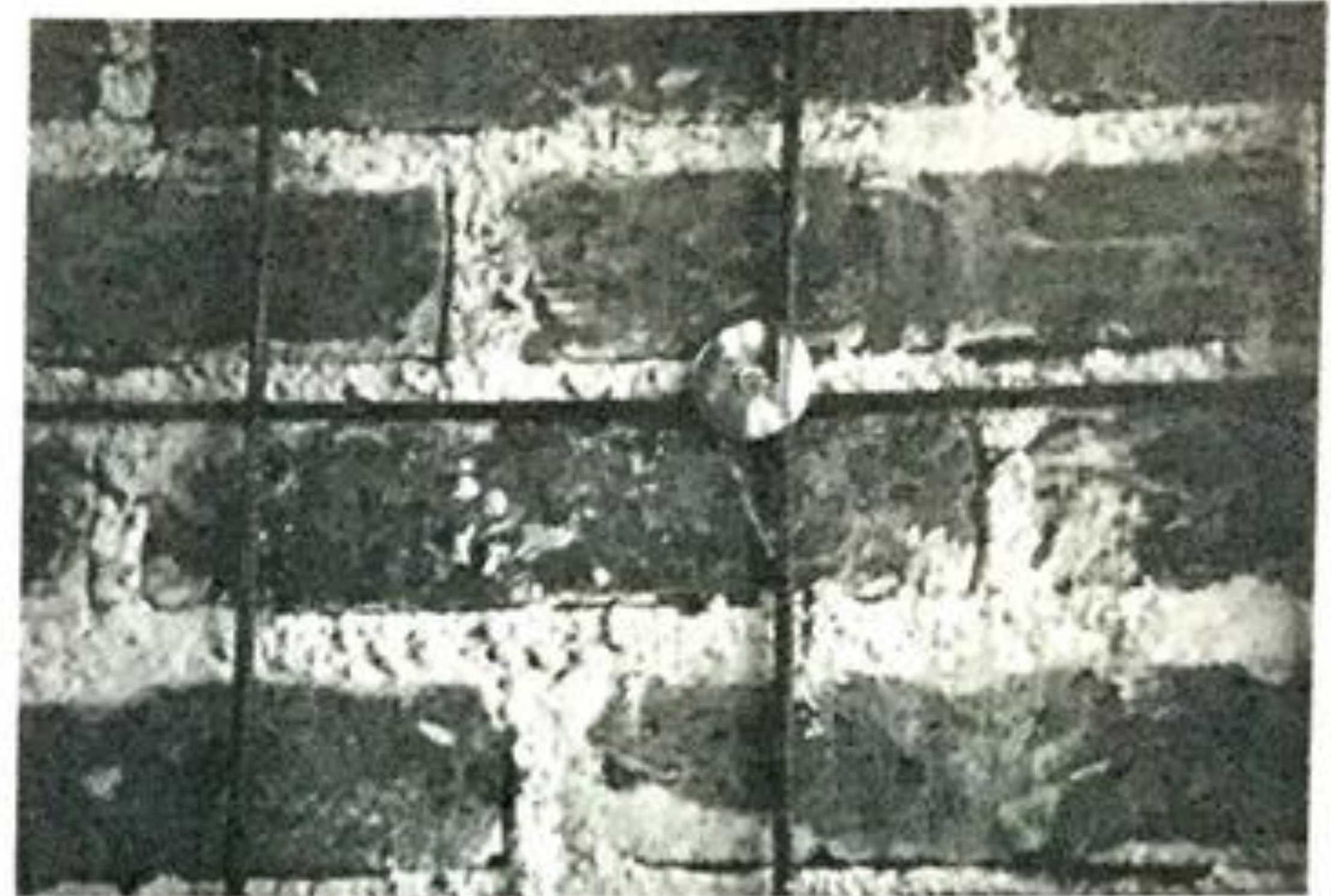
Figura 10.26 Malla metálica anclada con conectores Hilti a un muro de mampostería.
