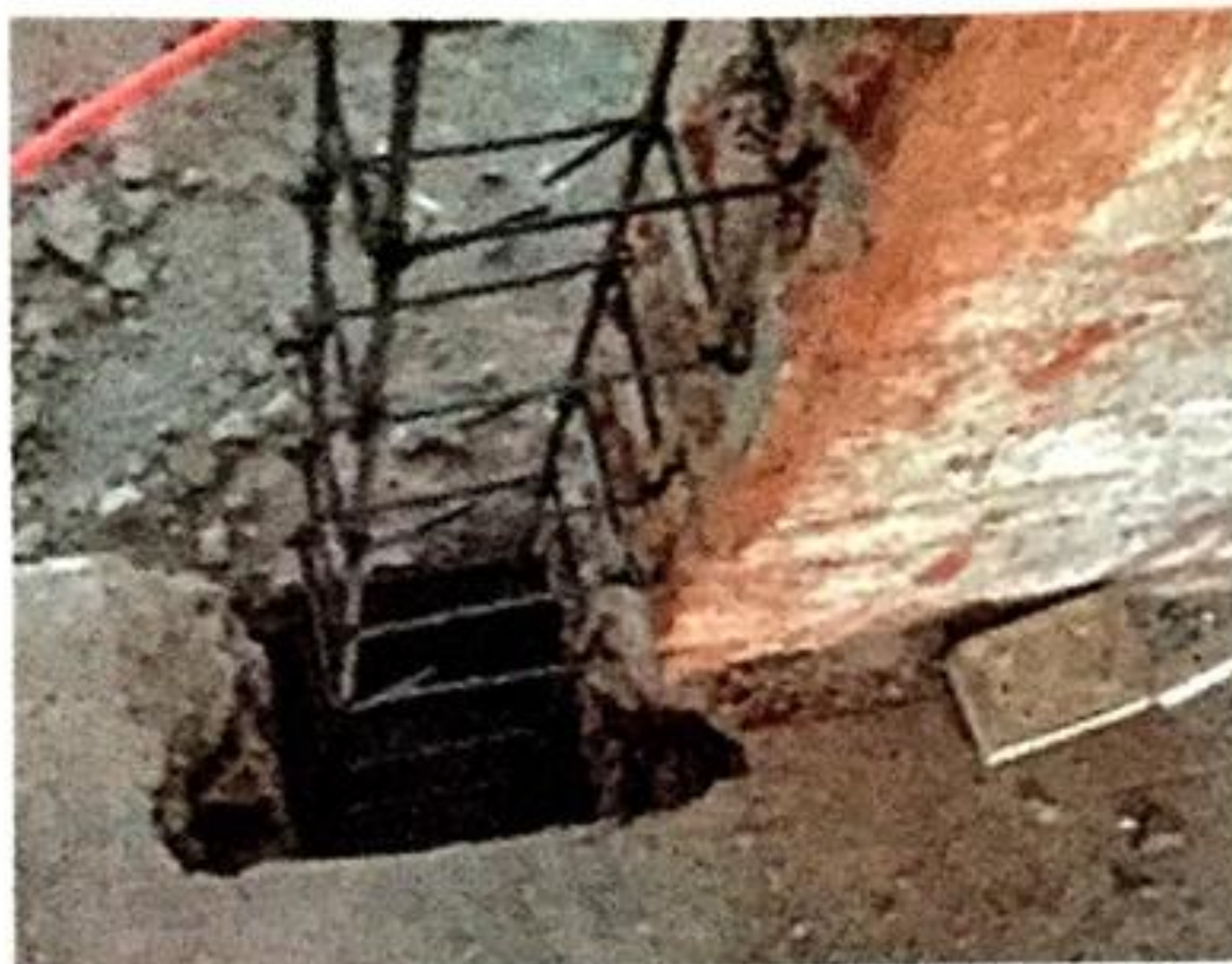
Figura 10.47 Ejemplo 1. Anclaje de castillo en la cimentación.
