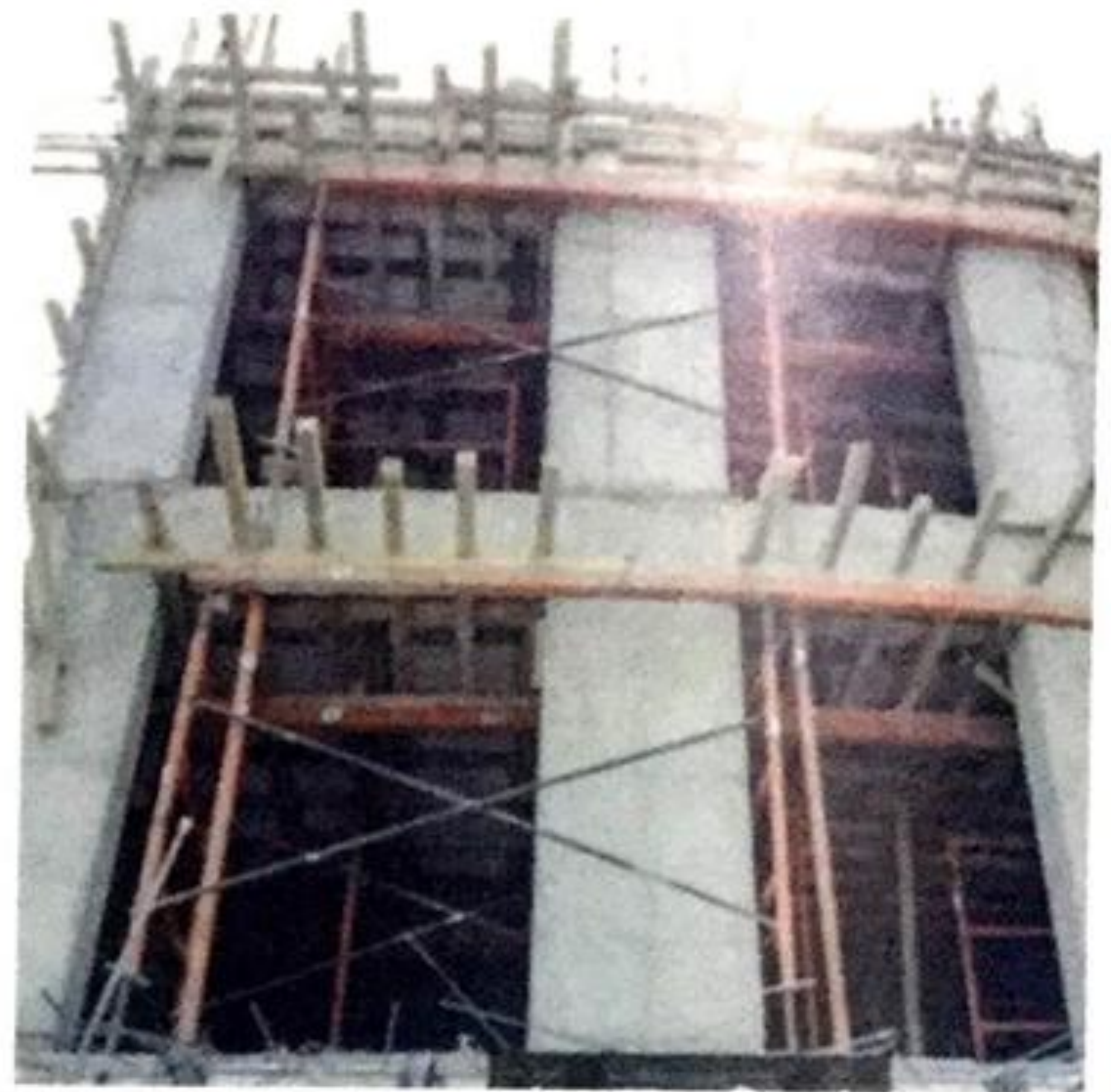
Figura 9.40 Cimbrado de una losa con puntales en la inmediata inferior.
