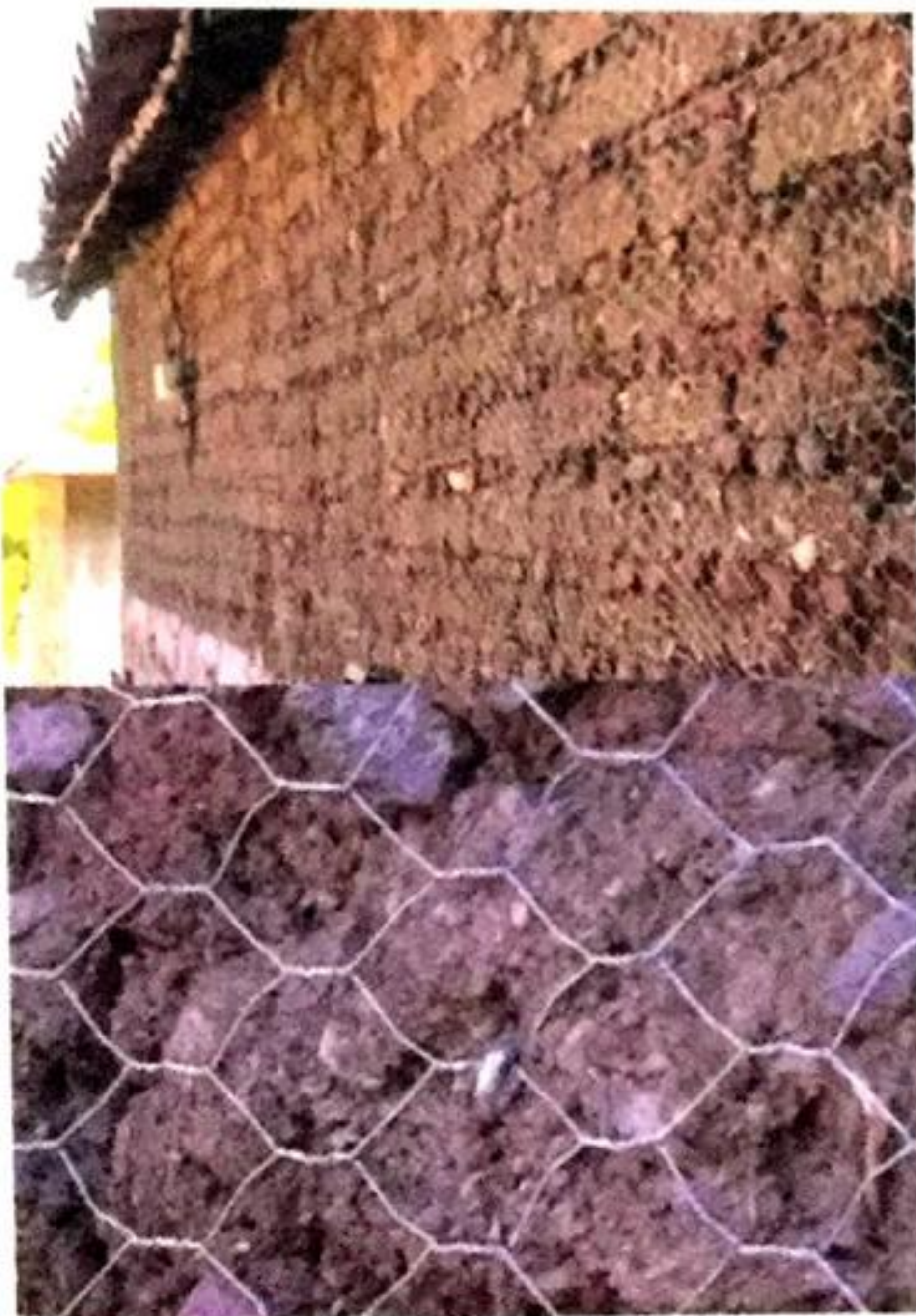
Figura 10.54 Ejemplo 2. Colocación de malla de gallinero directamente sobre el muro, fijada mediante grapas metálicas.
