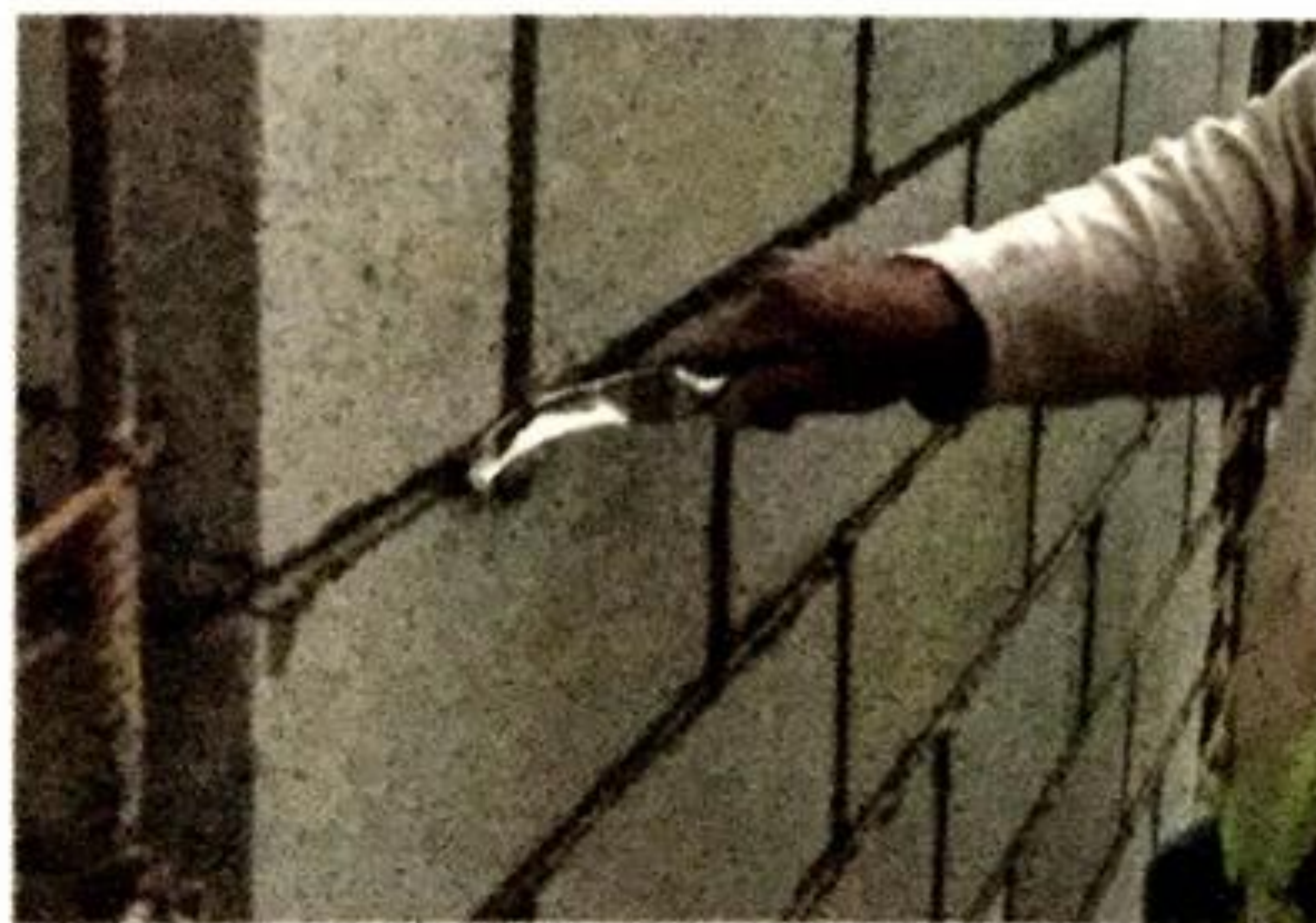
Figura 2.23 Técnica de rejunteo.
