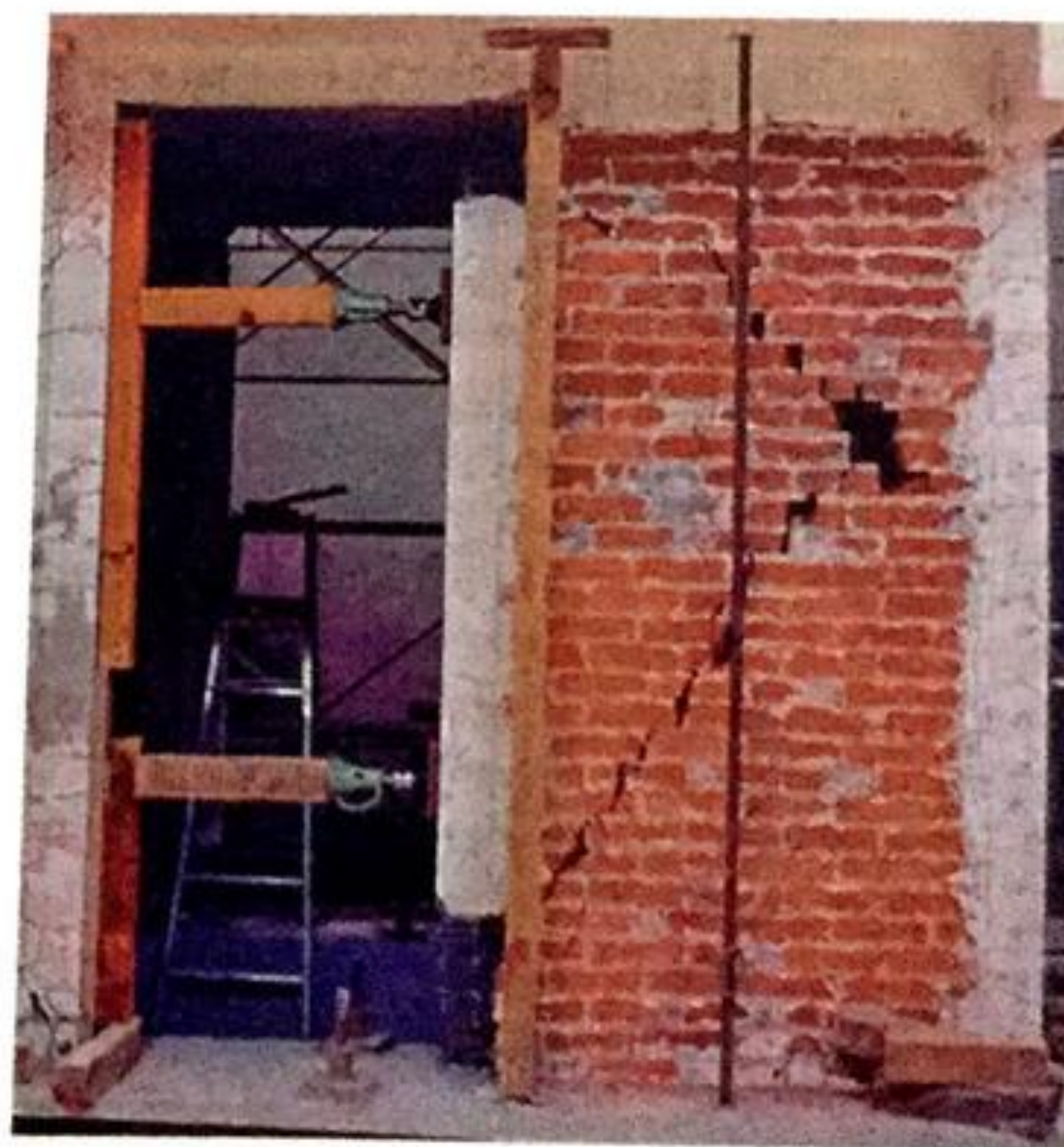
Figura 10.15 Muro dañado reparado mediante la sustitución de piezas aplastadas, rajuelas y reemplazo de concreto de castillos.
