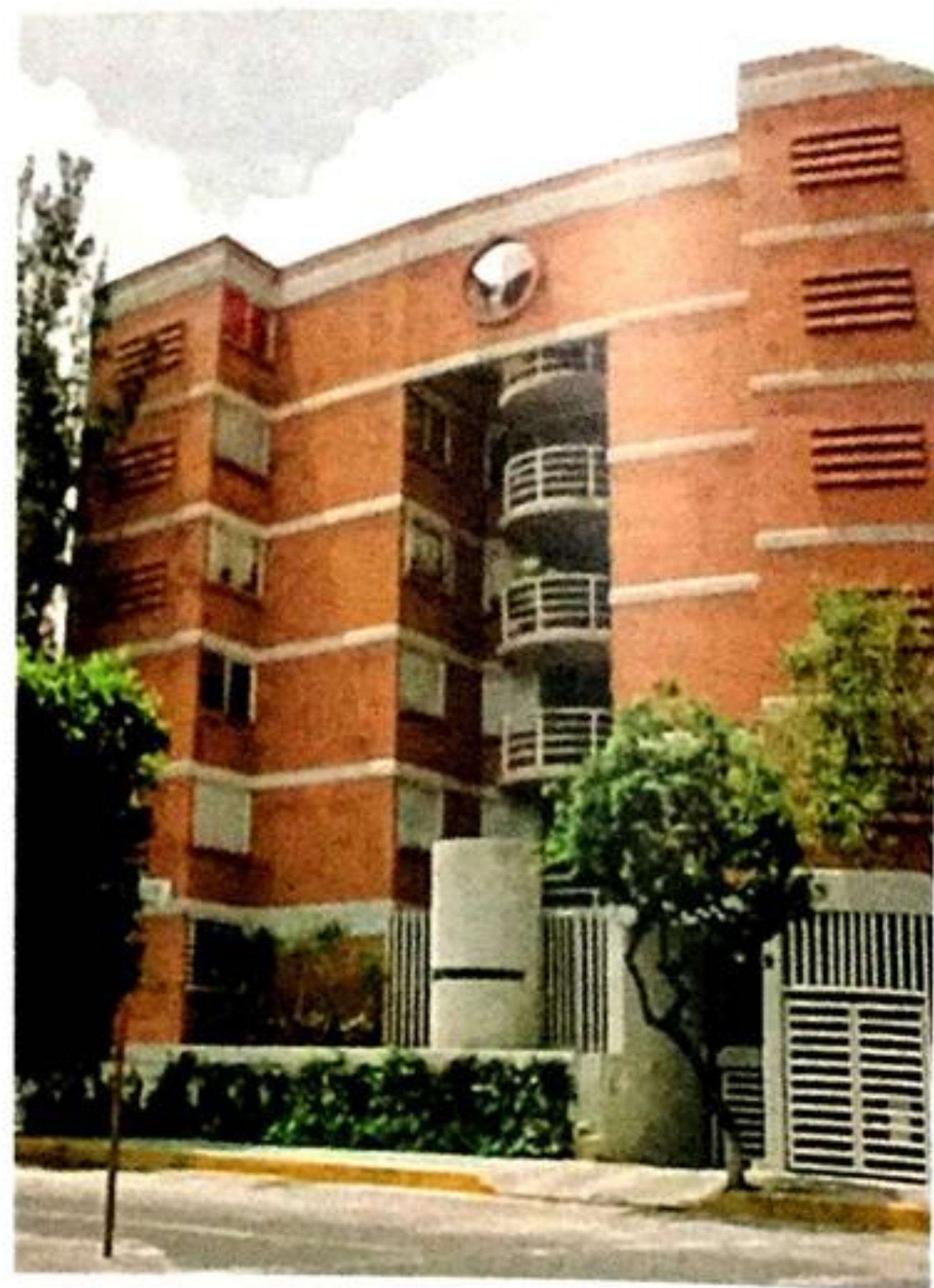
Figura 1.9 Edificio de vivienda multifamiliar en la Ciudad de México. (Fuente: M.I. Raúl Jean Perrilliat.)
