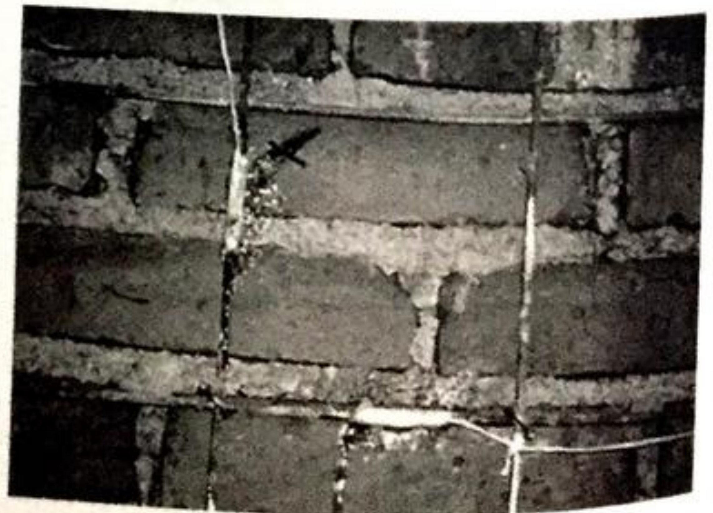
Figura 10.24 Malla metálica anclada a un muro de mampostería con clavos.
