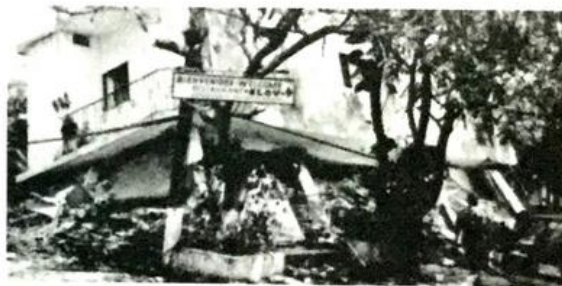
Figura 3.22 Colapso debido a la escasez de muros en planta baja (López Bátiz & Teshigawara, 1997).
