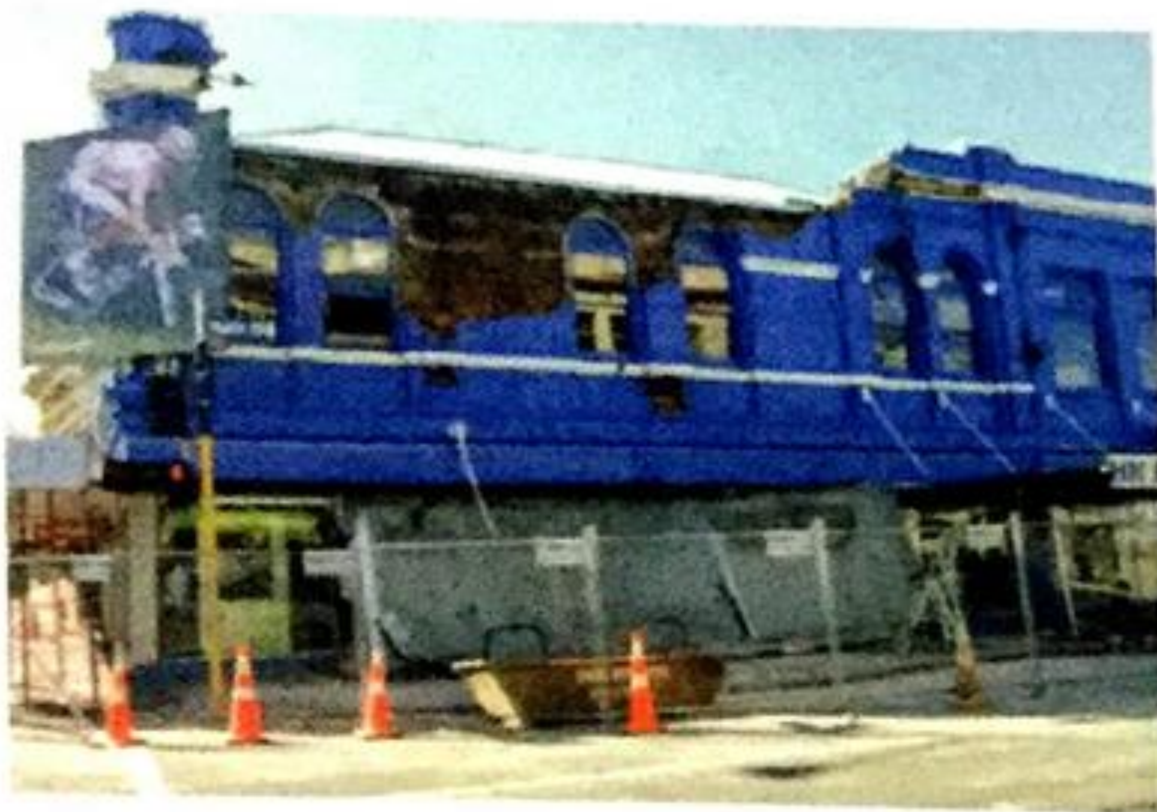
Figura 3.18 Falla de parapeto (Griffith e Ingham, 2011).
