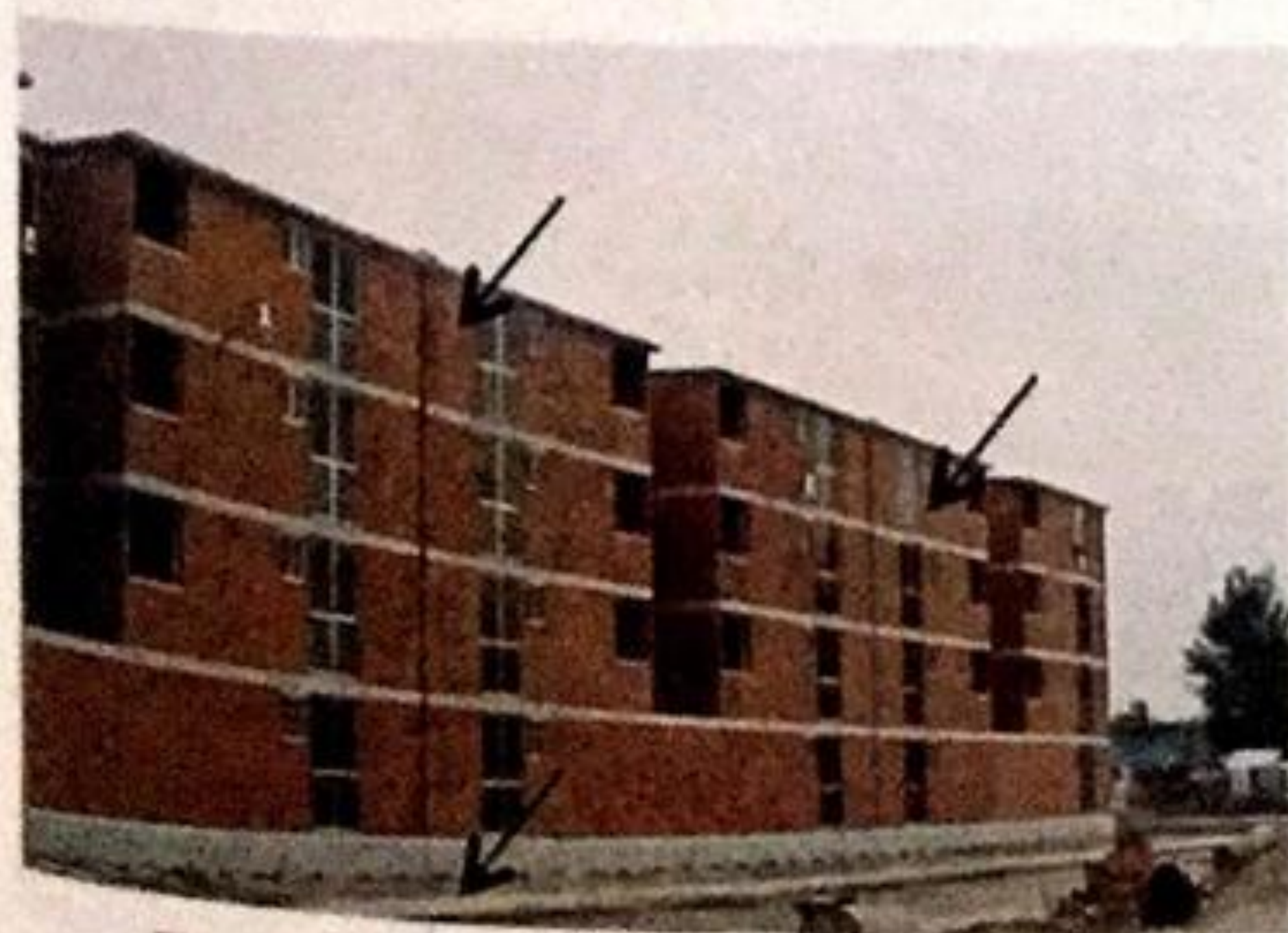
Figura 9.24 Juntas constructivas en edificio y en cimentación.
