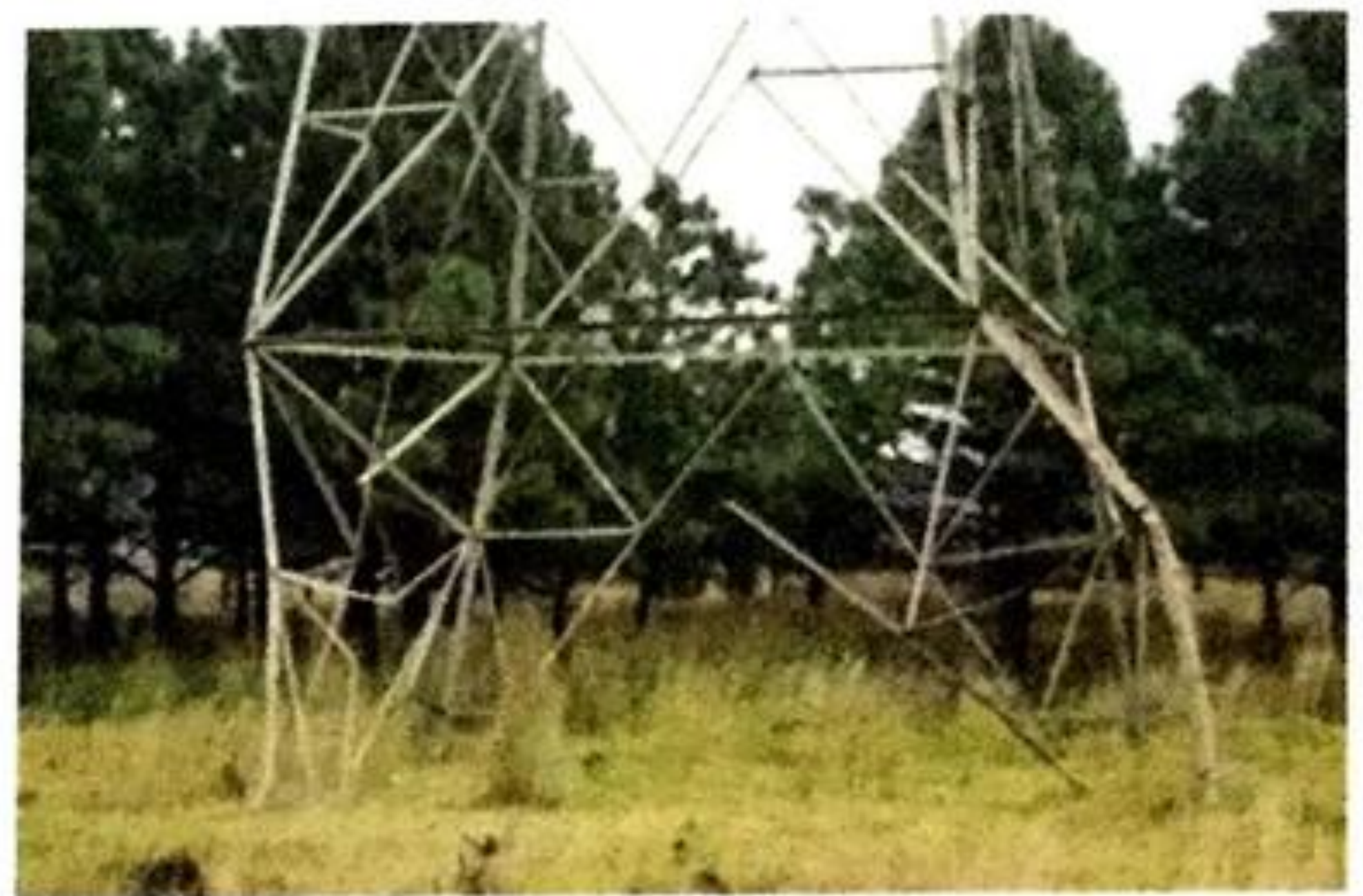
Figura 4.6 Comportamiento altamente indeseable para estructuras sismo-resistentes: a) daño en conexiones, b) pérdida de geometría original.
