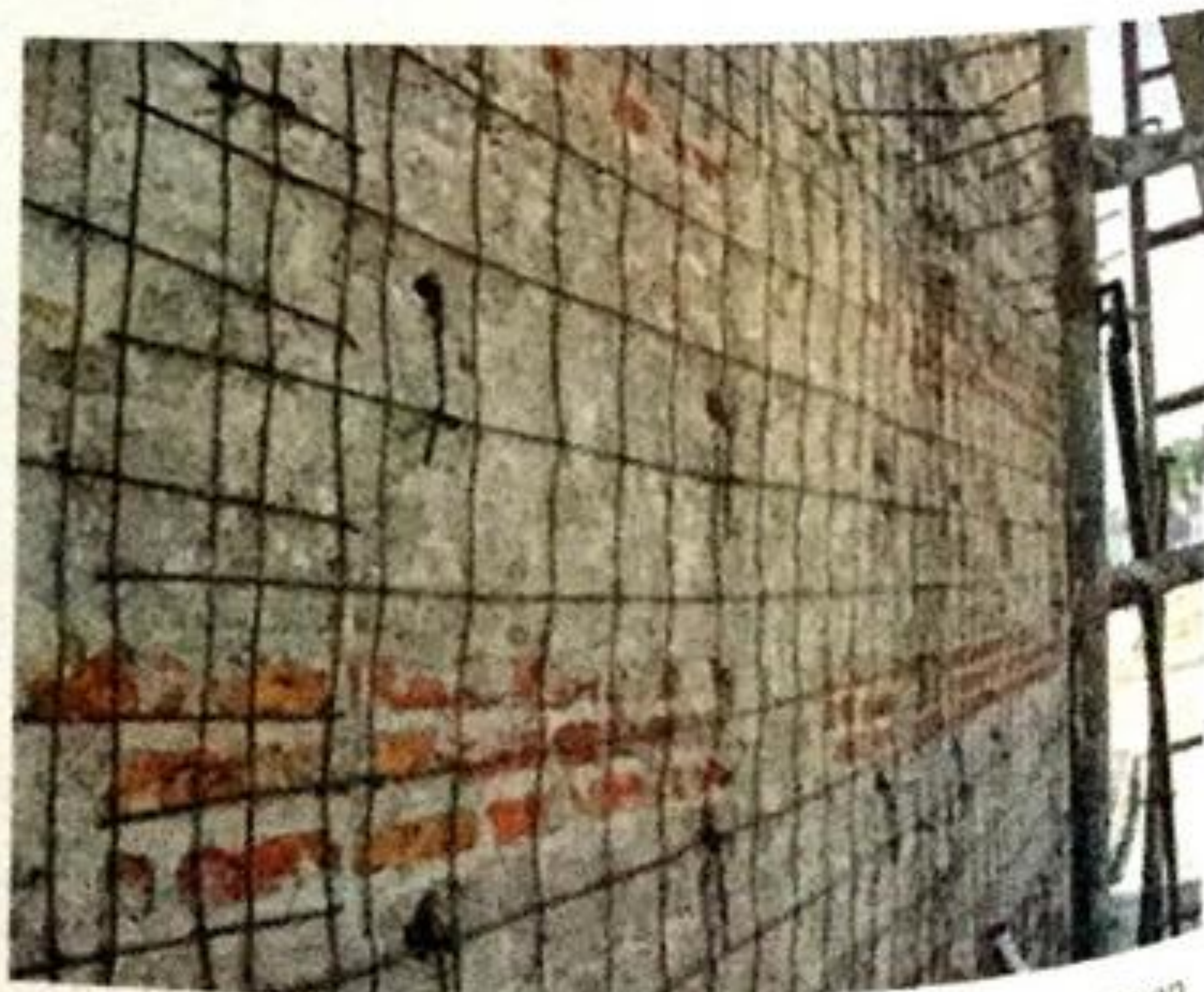
Figura 10.29 Muro rehabilitado con mallas continuas en toda su longitud.
