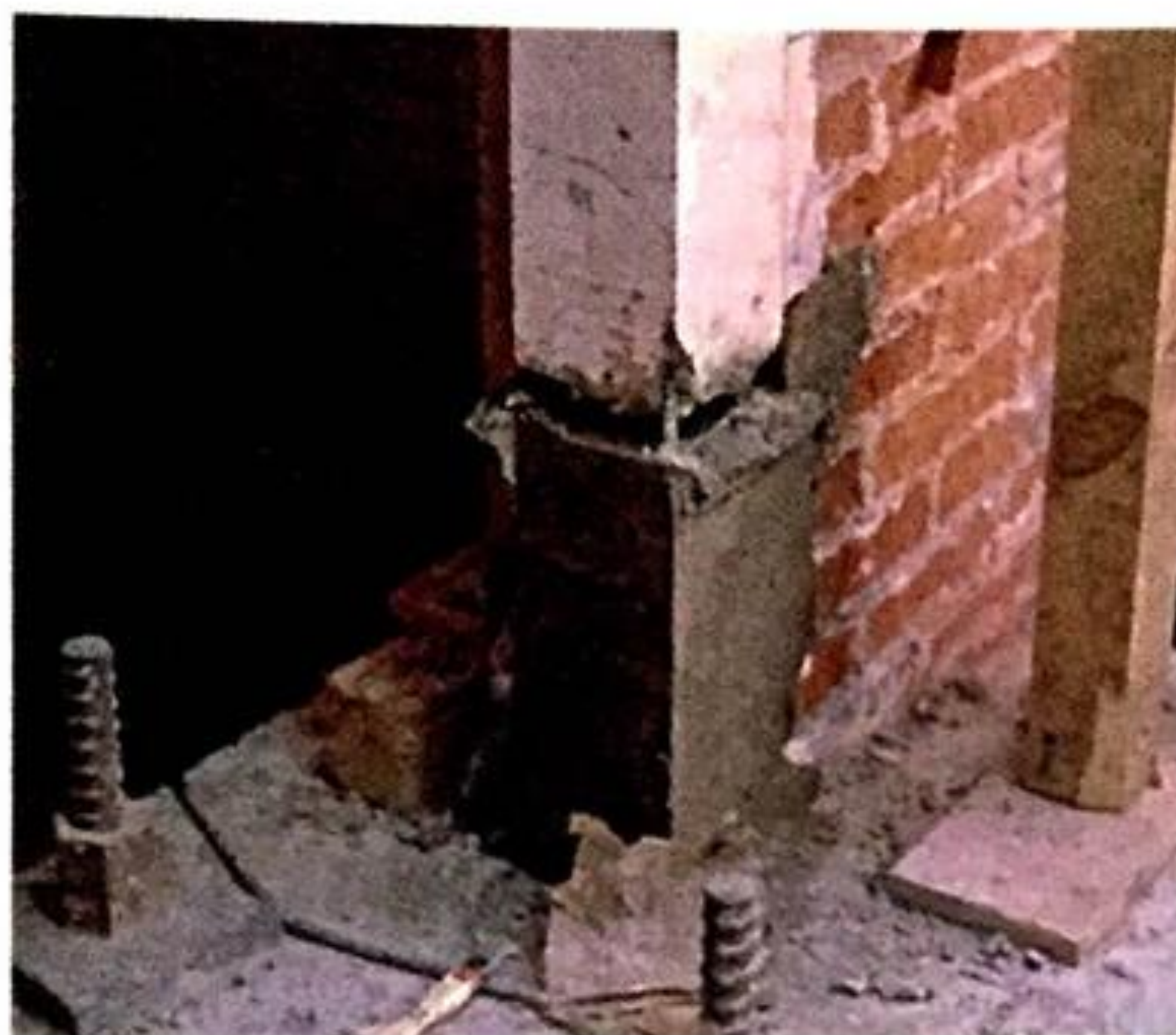
Figura 10.16 Ejemplo de reemplazo de concreto dañado en el extremo inferior de un castillo; la estructura fue previamente apuntalada.
