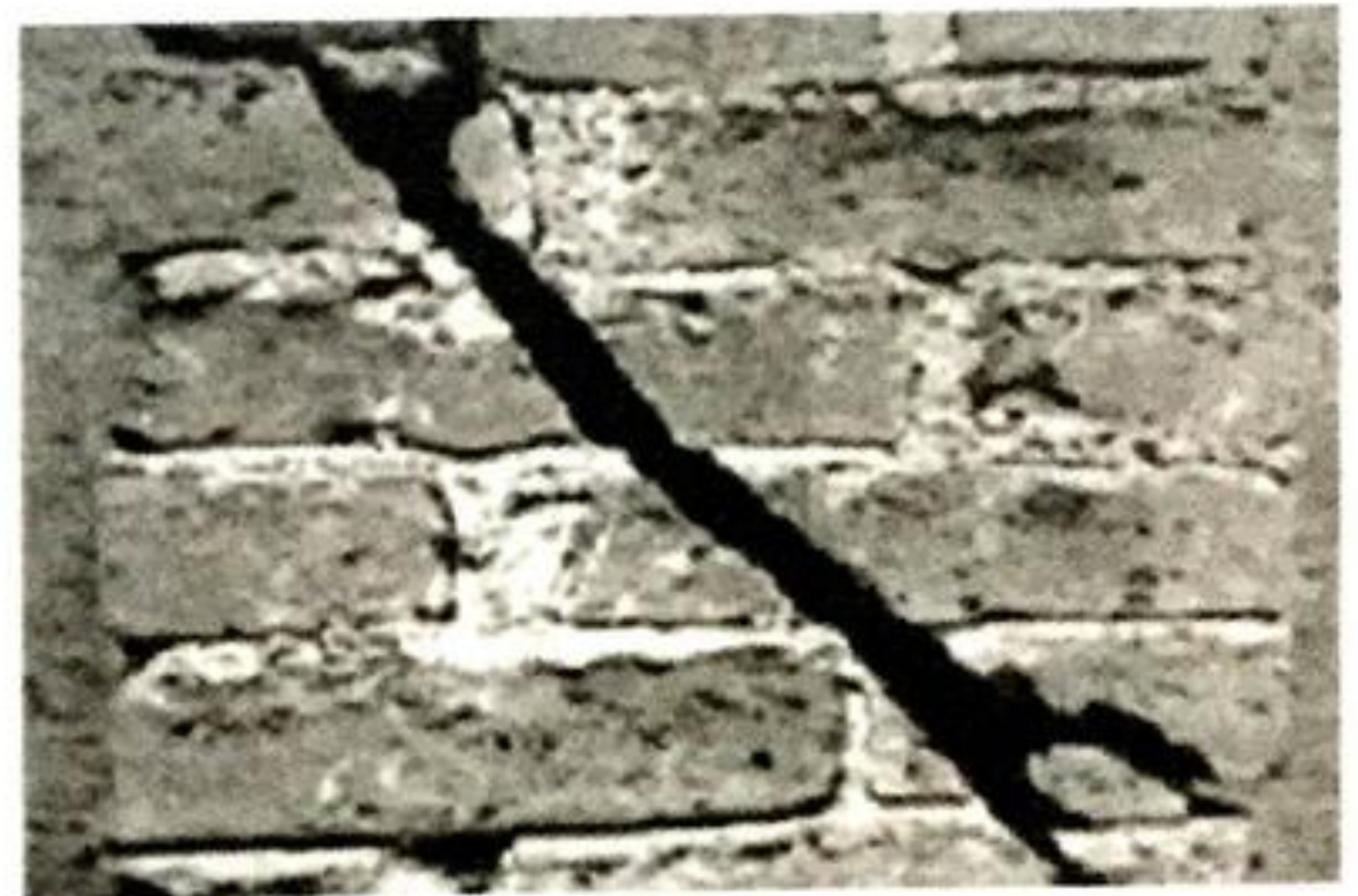
Figura 2.37 Mecanismo de falla por tensión diagonal.
