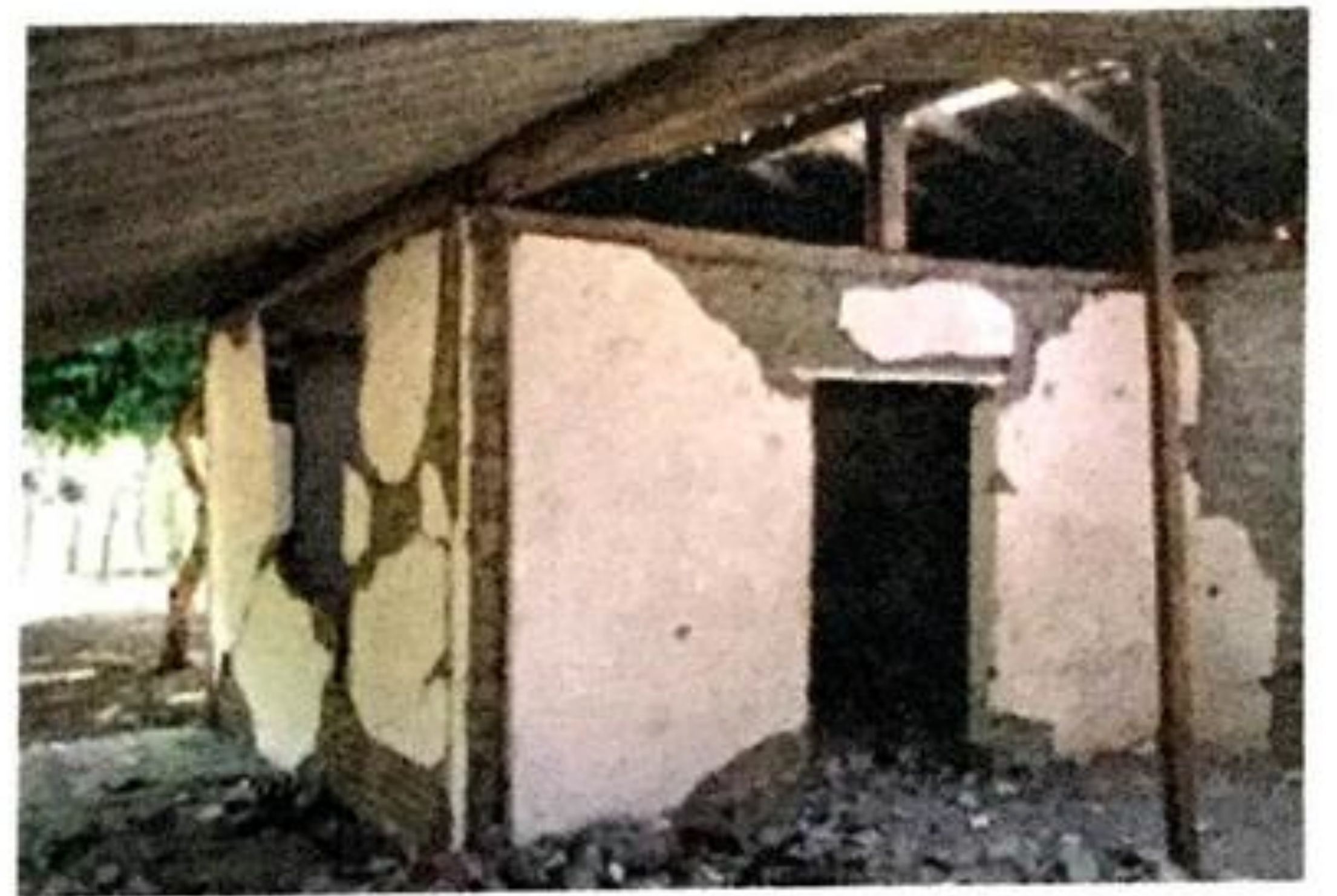
Figura 3.11 Muros de mampostería reforzada con polines de madera (SMIS y EERI, 2006).
