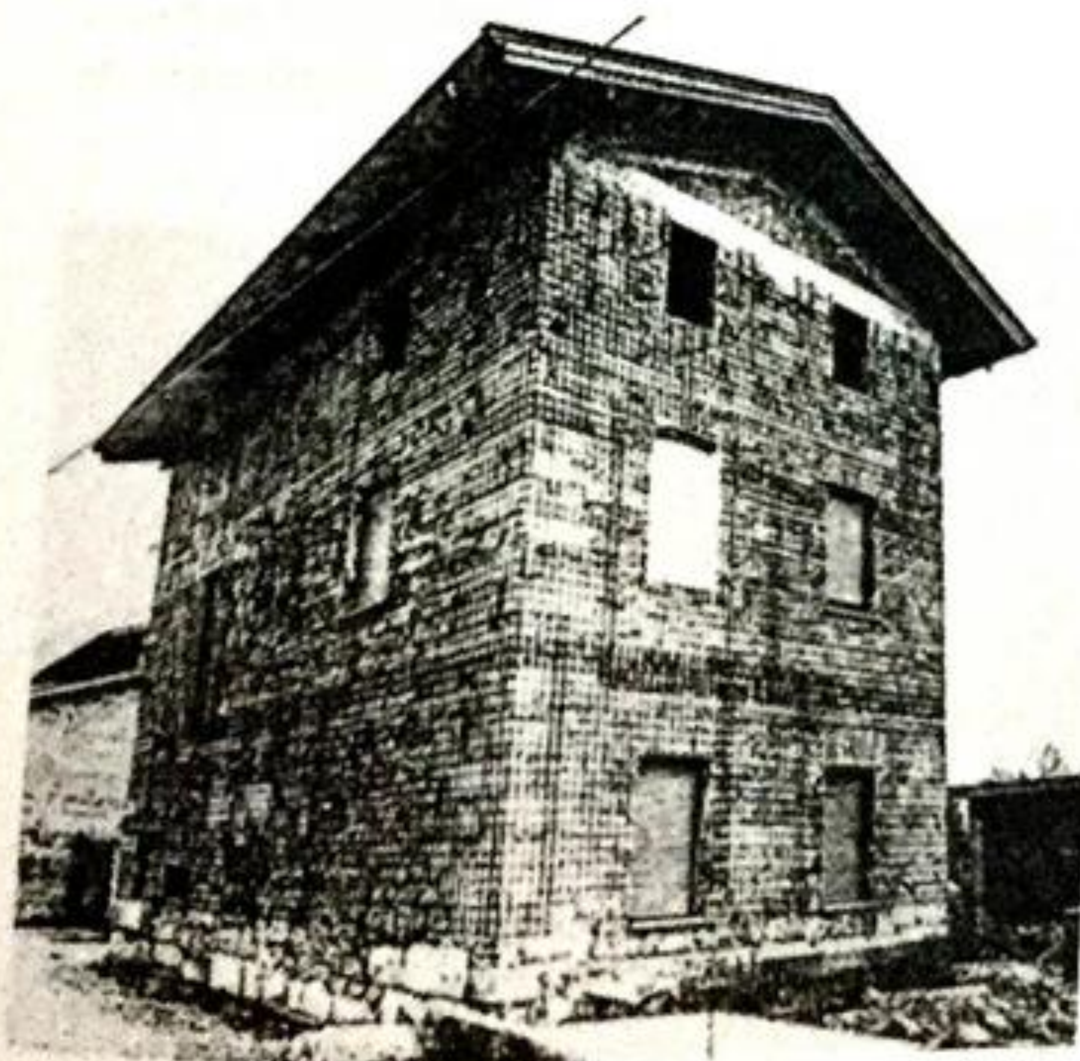
Figura 10.22 Encamisado con mallas metálicas después del sismo de Friuli, Italia, en 1976.
