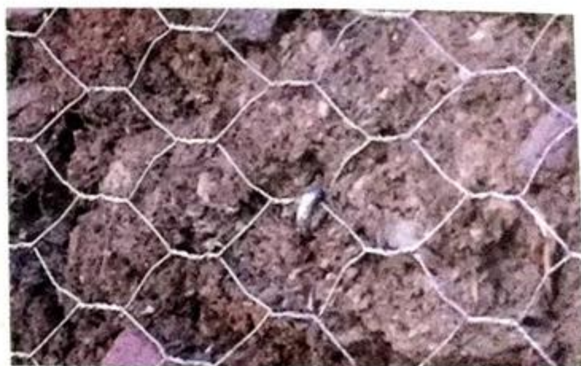
b) Rehabilitación de estructuras de adobe con malla de gallinero, anclada con grapas metálicas.
