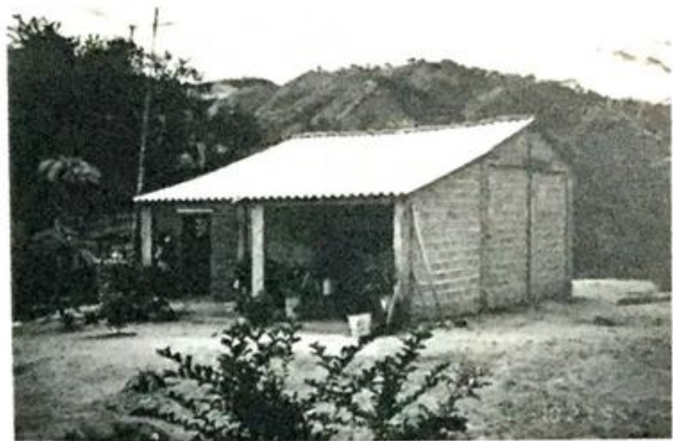
Figura 10.41 Vivienda de mampostería con techo ligero.
