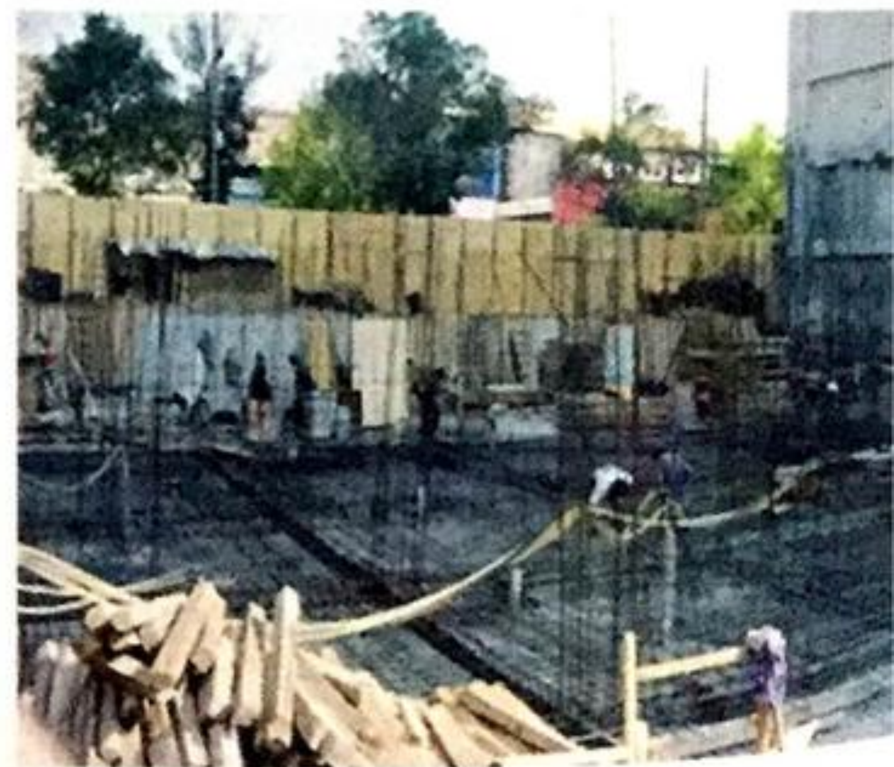
Figura 9.21 Armado para losa de cimentación.
