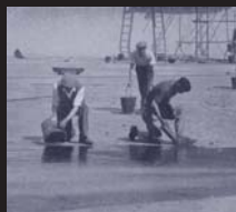
Operarios vertiendo asfalto en una azotea [Techniques et Architecture, 5-6 1948 Biblioteca COAC]
