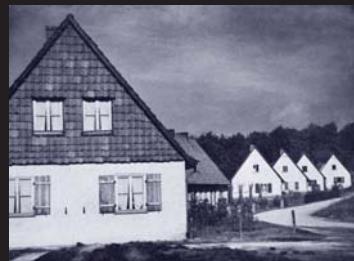
Una colonia con cubiertas "arias" del periodo nazi después de la práctica prohibición de la cubierta plana [Baumeister, 5 1950 – Biblioteca ETSAB/UPC]
