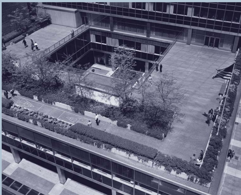
Empleados jugando en el cuerpo bajo de los Lever Brothers Company Headquarters. Lever House, New York, Gordon Bunshaft de SOM (1952) [Foto Tom Murtaugh – Skidmore, Owings & Merrill]
