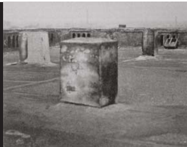
François Coignet construyó la azotea de su casa en Saint-Denis (1853) sin más impermeabilización que la confianza en la compacidad de su hormigón [Techniques et Architecture, 5-6 1948 – Biblioteca COAC]
