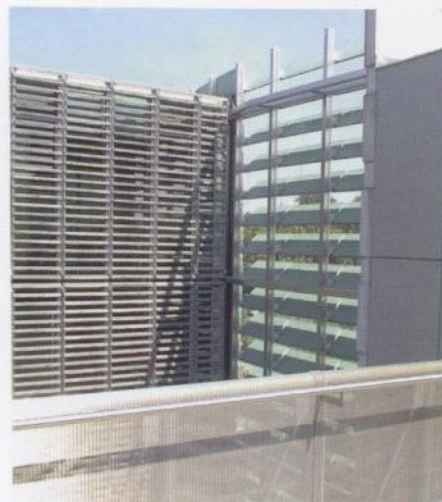
Visibilidad desde el espacio central del con- junto de las Embajadas y a través del cerra- miento de lamas de cobre. Embajadas de los Países Nórdicos, Berlín, Alemania (Berger & Parkkinen Arquitectos).
