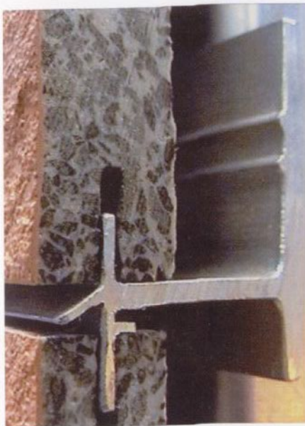
Perfil guía de aluminio extrusionado soportando una hoja exterior de hormigón polímero. Ulma.
