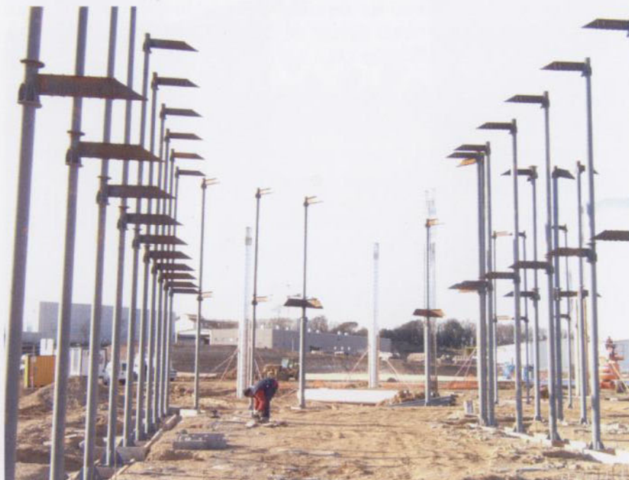
Estructura portante del edificio de oficinas de Riudellots, pautada al ritmo que establece el cerramiento de fachada (LI. Clotet, I. Paricio).
