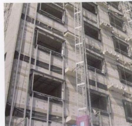
Fachada del Hotel AC en construcción. Fachadista Biosca & Botey, industrial Sistema Masa (MAP Arquitectos).
