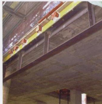
Subestructura de acero colocada para soportar la pared de fábrica de ladrillo de la parte superior del hueco.
