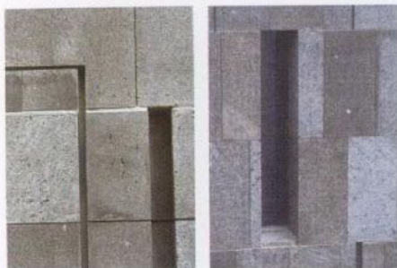
Revestimiento de piedra de basalto del Museo de Arte Moderno de Viena, Austria, 2001 (Ortner & Ortner).
