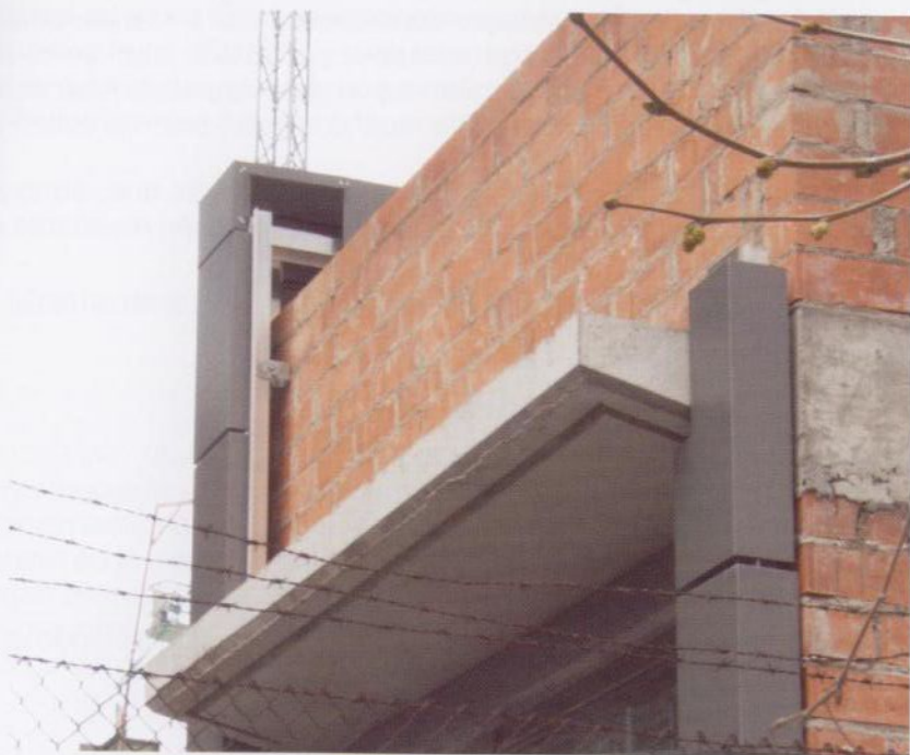
Ejecución de pruebas de fachada sobre una pared de fábrica.
