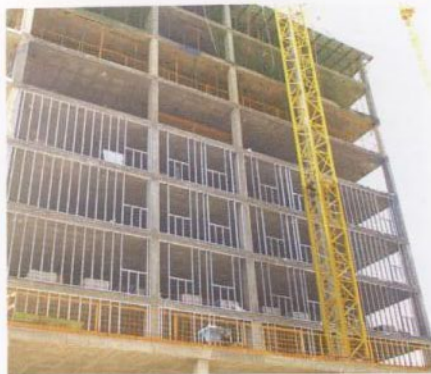
Diferentes momentos en el proceso de montaje de las fachadas de las tres torres de viviendas de protección oficial, en Terrassa, Barcelona (RGA Arquitectos).
