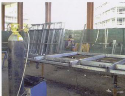
Diferentes momentos de la elaboración y del montaje de los premarcos para el edificio de viviendas "Illa de la Llum" de Diagonal Mar, en Barcelona (Ll. Clotet, I. Paricio).
