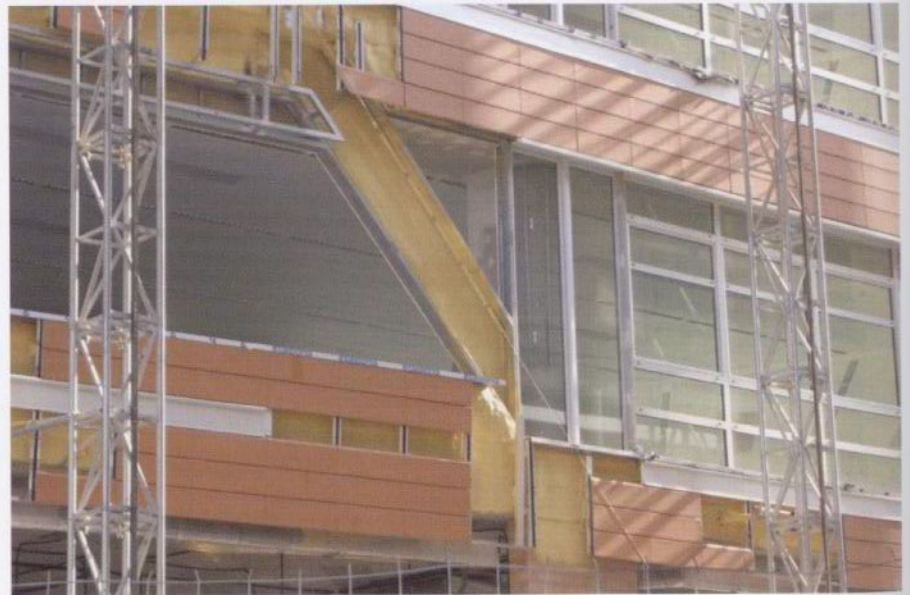
Edificio de oficinas en Barcelona (William Mc Donough).
