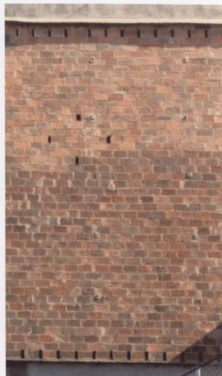
Tabique pluvial tradicional donde se puede apreciar la frecuencia y el tamaño de los huecos de ventilación.
