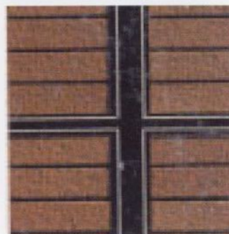
Revestimiento cerámico de la fachada del Ircam de París, Francia (R. Piano).
