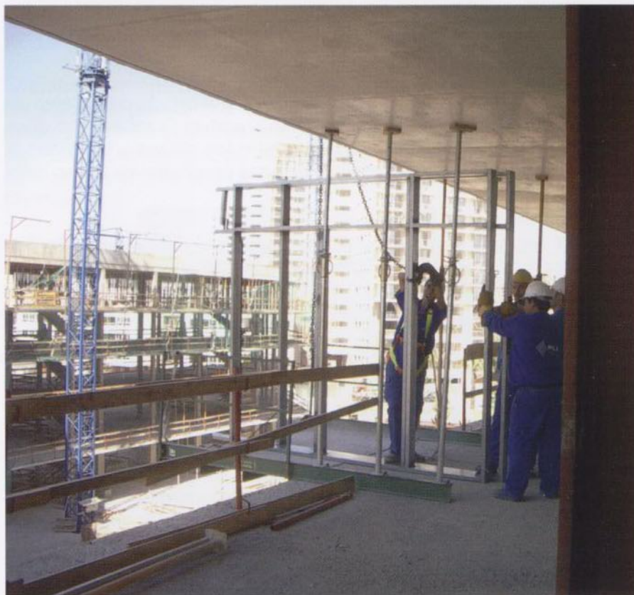
Diferentes momentos de la elaboración y del montaje de los premarcos para el edificio de viviendas "Illa de la Llum" de Diagonal Mar, en Barcelona (Ll. Clotet, I. Paricio).
