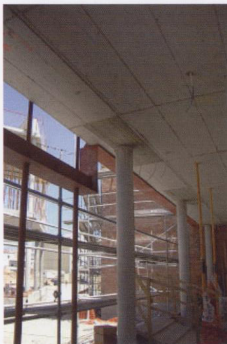
Premarco telar con maineles portantes en las Dependencias Municipales de Sant Pere de Ribes (Ll. Clotet, I. Paricio).
