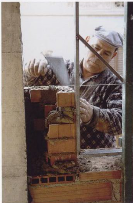
Colocación tradicional de un premarco.
