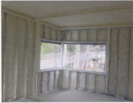
Interior de la ampliación antes de colocar las placas de yeso laminado, que conformarán la última hoja de la envolvente (Ll. Clotet, I. Paricio).
