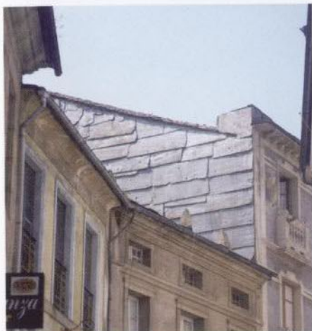
Tabique pluvial a base de placas de pizarra propio de la tradición gallega
