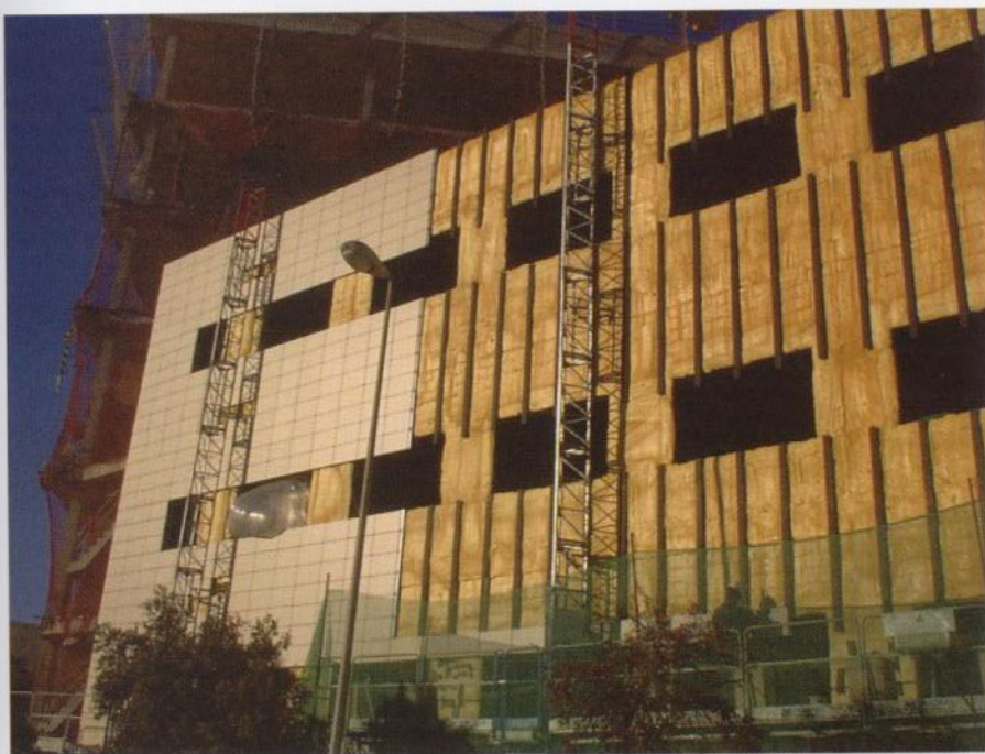
Fijación de la placa de gres porcelánico que conforma la hoja exterior en la fachada del Hospital del Espíritu Santo en Santa Coloma de Gramenet, Barcelona (F. Pernas, J. Soler).
