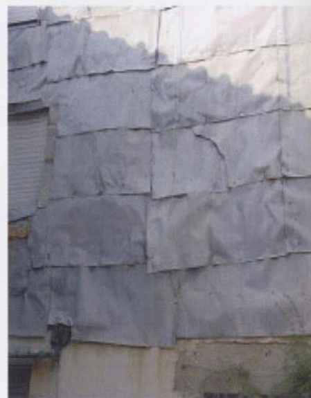
Construcción tradicional en Sequeiras, Salamanca.
