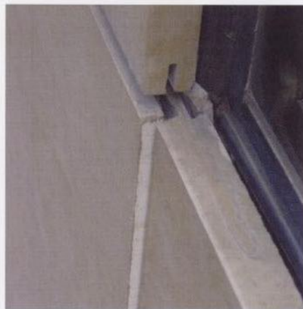
Dos ejemplos de rotura de la hoja exterior a nivel de planta baja, causados por acciones mecánicas localizadas.
