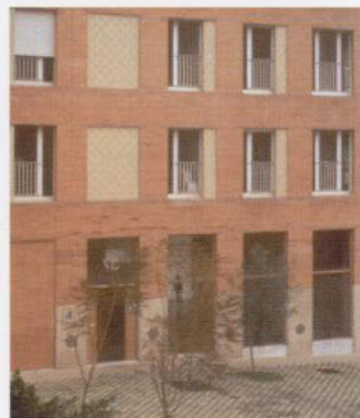
Bloque de viviendas en la Vila Olímpica, Barcelona (Ll. Clotet, I. Paricio).
