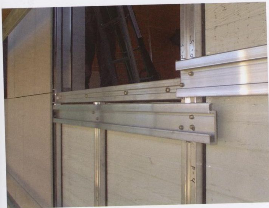
Fijación por medio de rastrel horizontal de aluminio extruido de las placas de gres porcelánico que forman la hoja exterior en el edificio de viviendas de Piera, Barcelona, resuelto con un sistema de fachada de Mekanotubo (J. Barba).
