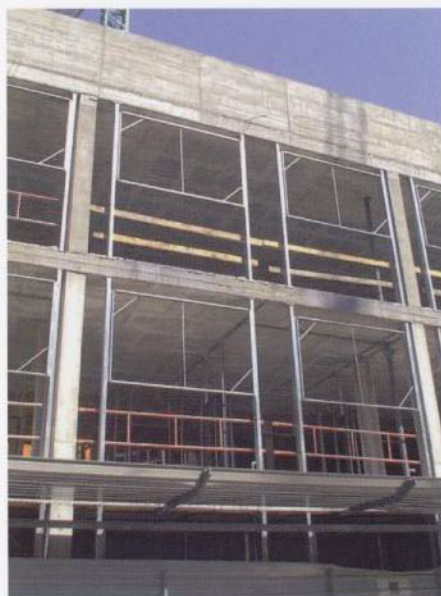
Premarcos anclados directamente a los forjados.
