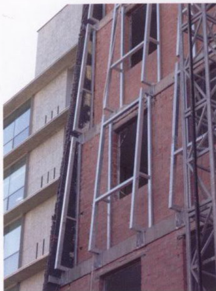
Fachada del Colegio Mayor Sant Jordi, Barcelona, en construcción (MAP Arquitectos).
