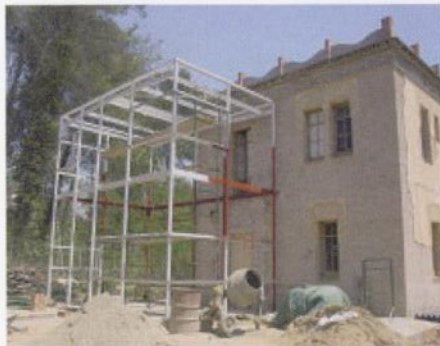
Estructura portante de la ampliación de la vivienda, donde se aprecian los perfiles que van a definir los huecos de las ventanas (Ll. Clotet, I. Paricio).
