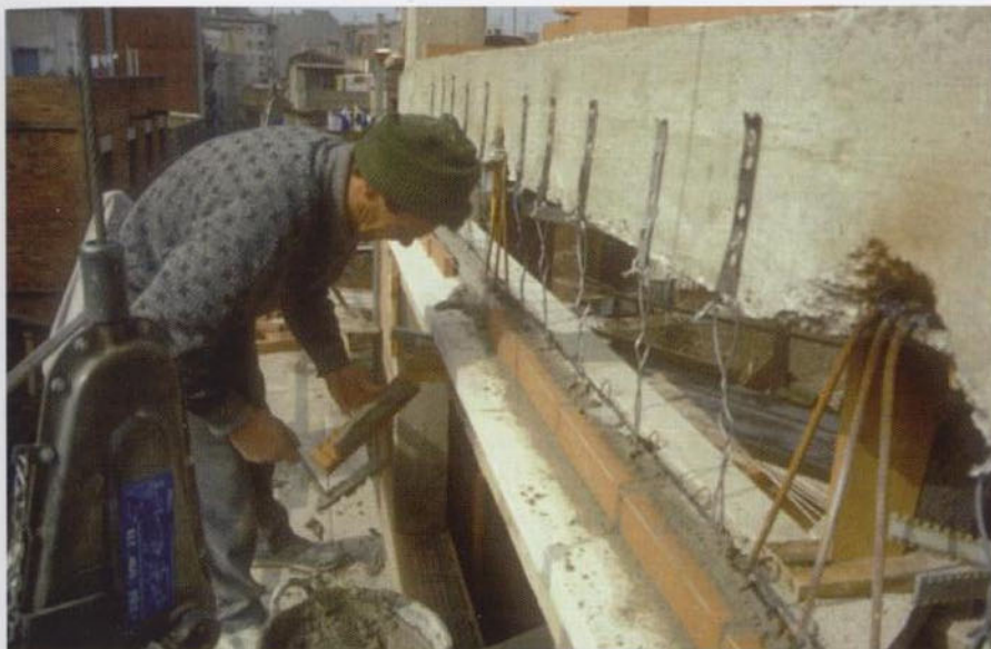
Subestructura de acero colocada para soportar la pared de fábrica de ladrillo de la parte superior del hueco.
