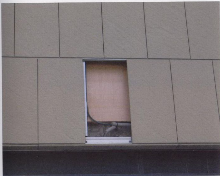
Desmontaje de una placa de la hoja exterior de una fachada ventilada, para resolver el paso de la instalación eléctrica de la marquesina que cubre el acceso al edificio.
