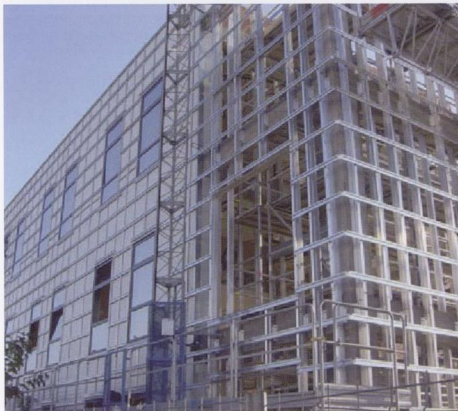
Proceso de construcción de una fachada con uno de los sistemas diseñados por Mecanotubo, a modo de muro cortina ciego.
