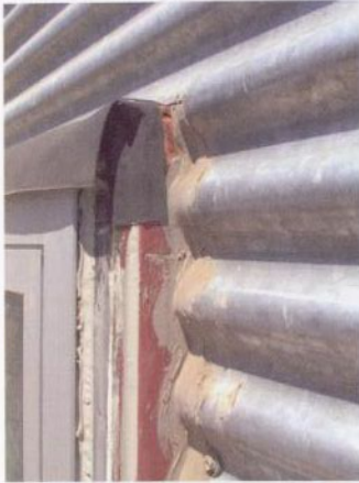
Sellado entre la hoja intermedia de una fachada ventilada y el premarco.
