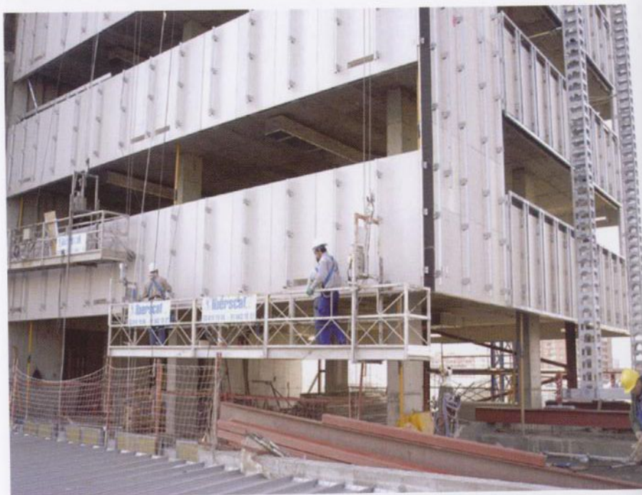
Hoja intermedia y rastreles de soporte de la hoja exterior en la fachada de las Oficinas CZF. Fachadista Biosca & Botey, industrial Sistema Masa (MAP Arquitectos).
