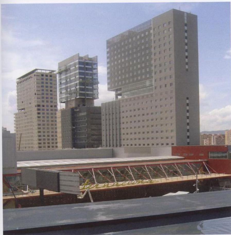
Conjunto del Hotel AC y las Oficinas CZF. (MAP Arquitectos).
