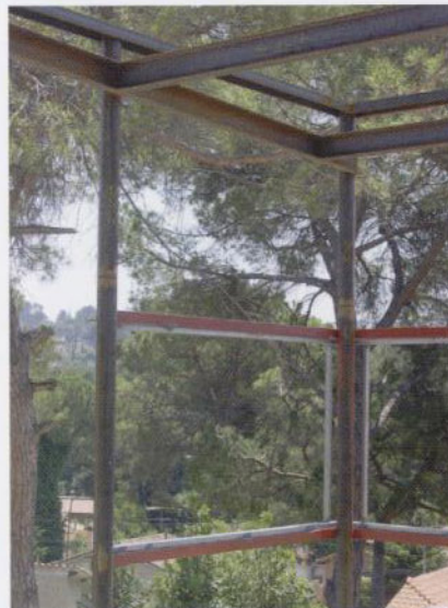
Estructura portante de la ampliación de la vivienda, donde se aprecian los perfiles que van a definir los huecos de las ventanas (Ll. Clotet, I. Paricio).
