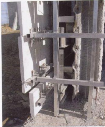
Complejidad de la cámara de la fachada ventilada en la Ciudad de la Cultura de Santiago de Compostela. Sistema de fachada de Proesga (P. Eisenmann).
