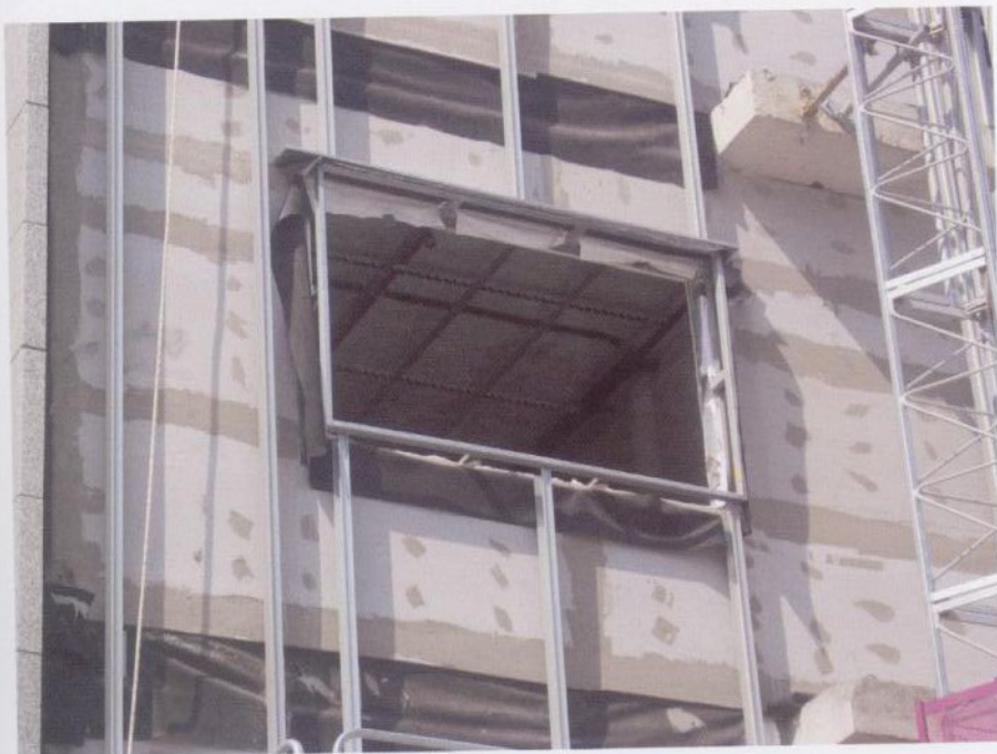
Sección vertical por la parte superior de un hueco de fachada, mostrando el encuentro entre el premarco telar, el babero y la carpintería situada en el plano exterior. Detalle de Sistema Masa.
