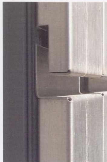
Junta horizontal entre dos bandejas metálicas de la fachada de la Embajada de Dinamarca en Berlín, Alemania (Nielsen, Nielsen & Nielsen).
