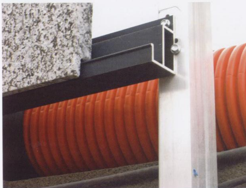
Perfil guía de aluminio extrusionado lacado en negro, anclado a un rastrel vertical también de aluminio. La hoja exterior que soportan es de placas de granito. Solución Sistema Masa.
