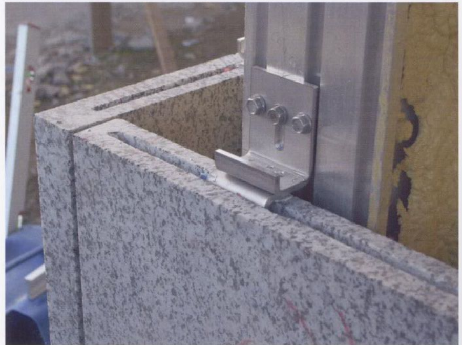
Anclaje puntual regulable montado sobre rastrel de Sistema Masa.
