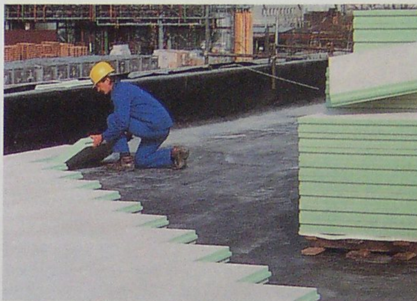
Aislamiento de una cubierta invertida. Las dimensiones y el peso de las placas permiten una rápida y fácil colocación.
