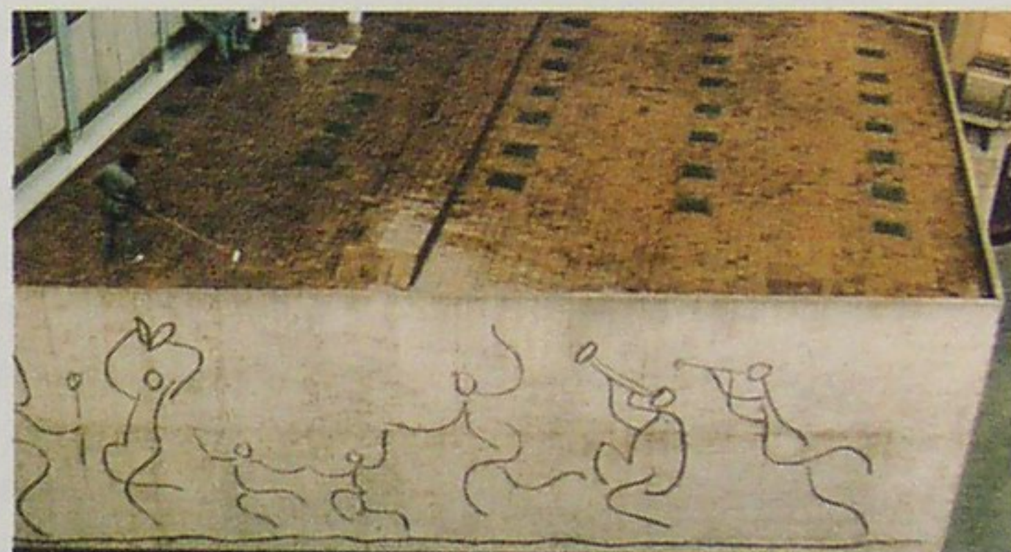
Impermeabilización de la cubierta del Colegio de Arquitectos de Cataluña, con Walter-Dec transparente.
