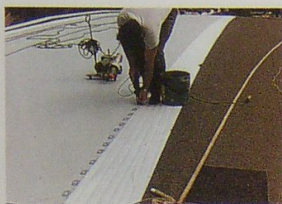
Detalle de colocación de la lámina Alkorplan. Es necesario incorporar una capa separadora entre el impermeabilizante y el aislamiento si éste es de tipo poliuretano o poliestireno.
