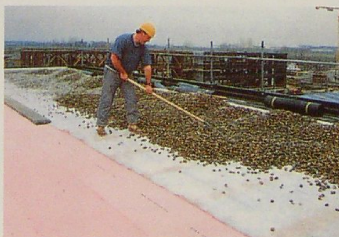
Colocación de planchas Polyfoam a media madera (tipo L J) en cubierta invertida.
