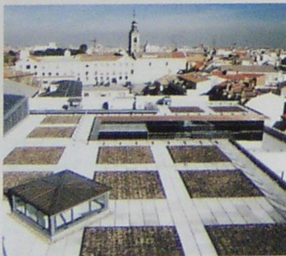
Azotea aljibe del ayuntamiento de Getafe (Madrid). Arquitecto: Francisco Rodríguez Partearroyo.
