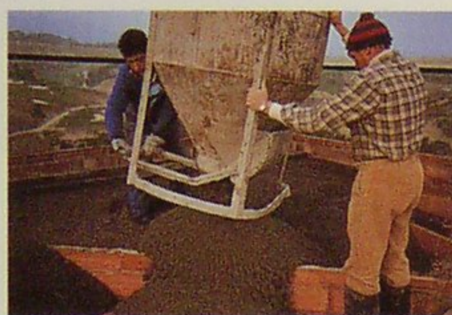
Utilización de Arlita en el aislamiento de una cubierta plana:
