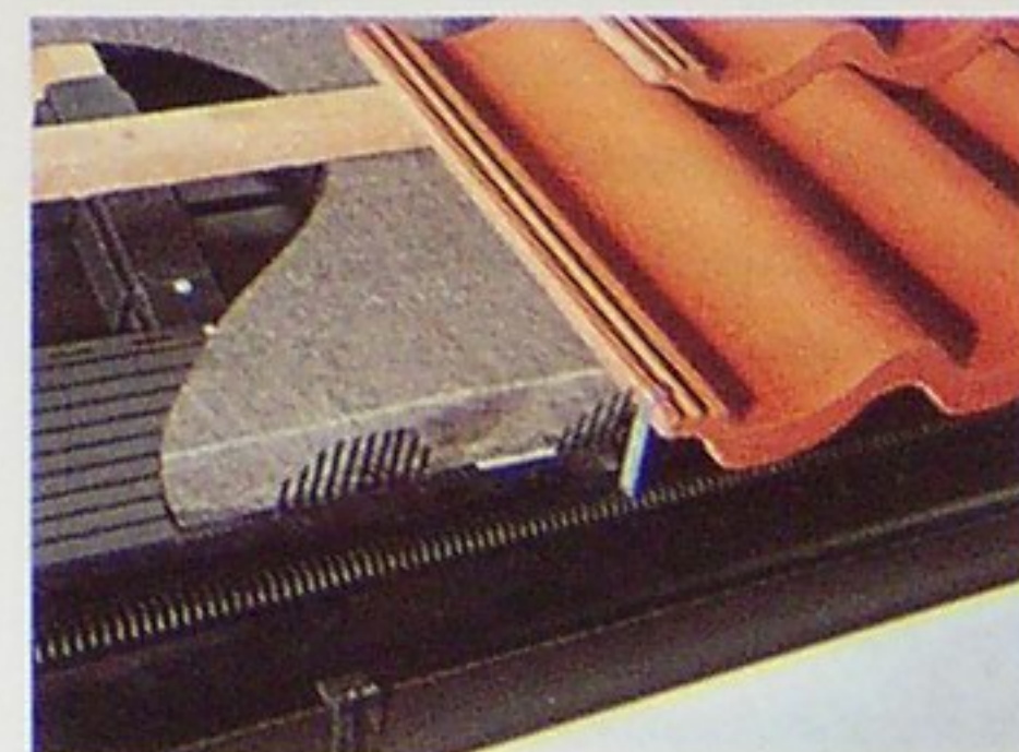
Detalle de pieza para la entrada de aire en una cubierta de faldón ventilado (fuente: Marley Roof Tiles).
