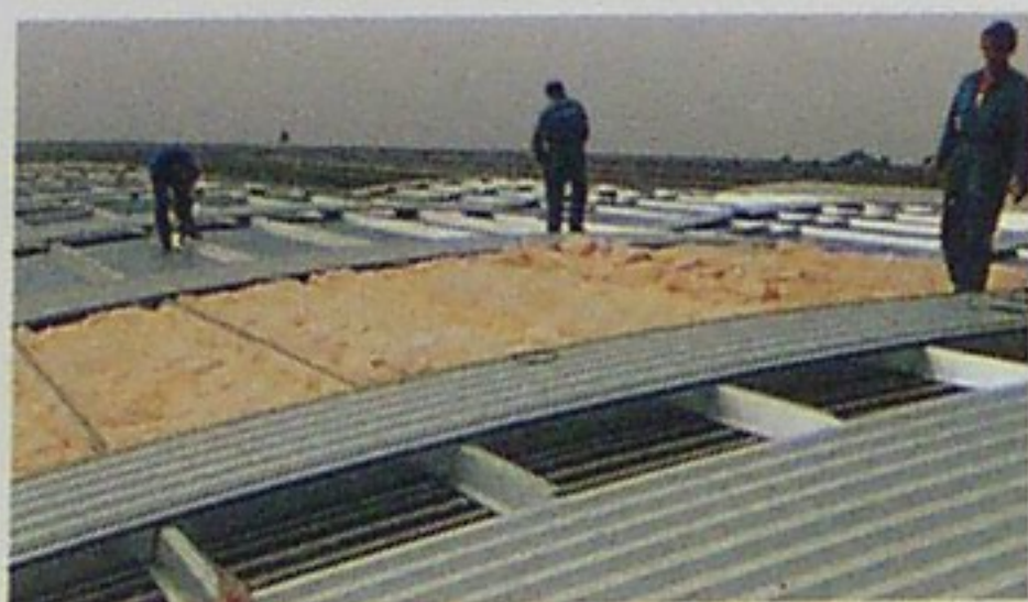
Colocación de aislamiento de lana mineral en una cubierta doble. En la parte inferior de la imagen, espacio entre los perfiles para el aislante; en el centro, aislante colocado; en la parte superior, fijación de los perfiles.
