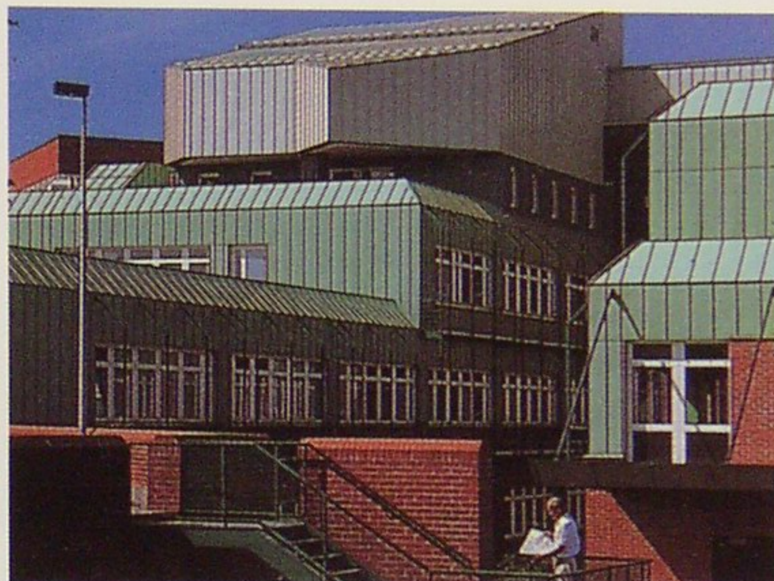
Clínicas municipales en Osnabrück. El aluminio prelacado Alcan es de aplicación tanto en fachadas como en cubiertas.
