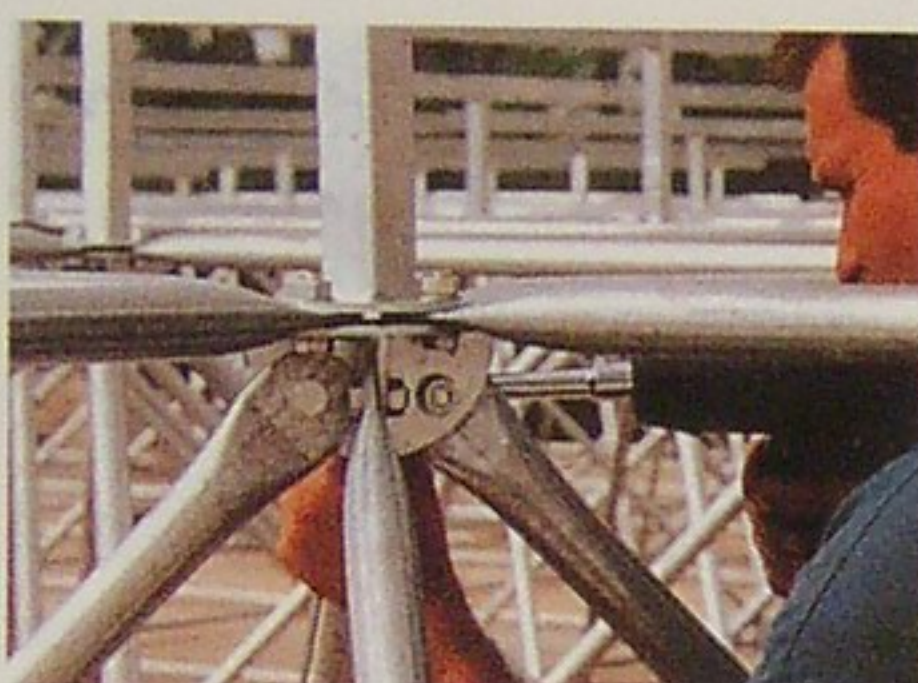
Nudo dividido en cuatro cuartos, preparado para recibir ocho barras, con el que configuran estructuras en pirámide de base cuadrada o rectangular.
