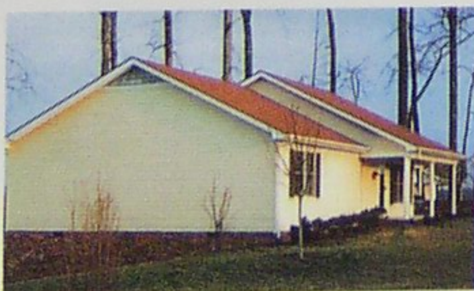
Aplicaciones en cubierta.
