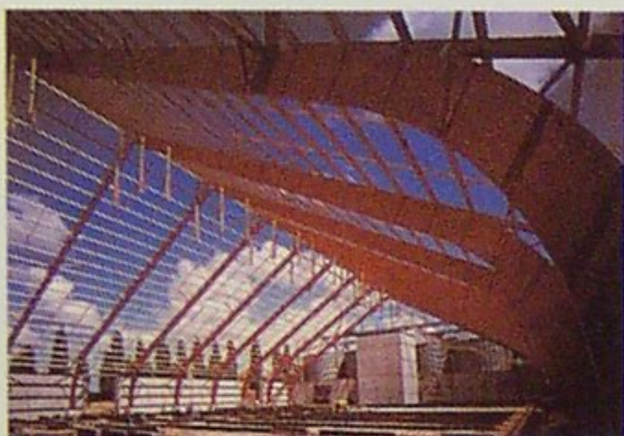
Los medios de fabricación y puesta en obra bajo control de calidad permiten cubrir luces cercanas a los 100 m con estructuras de arco.
