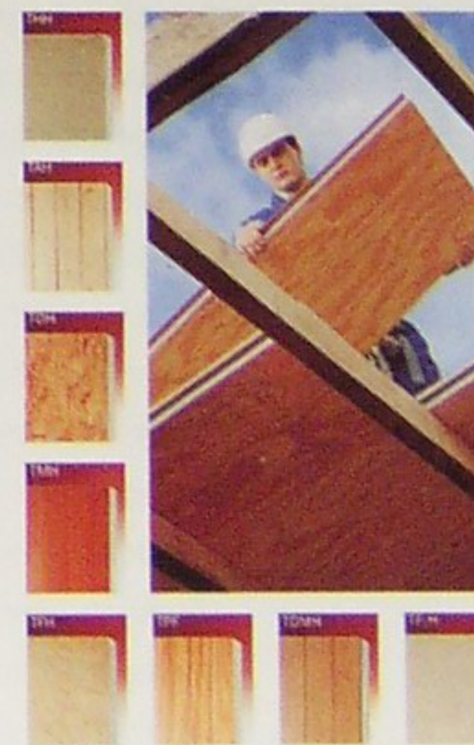
Colocación de los paneles sobre estructura de madera y gama de acabados interiores Thermohip.
