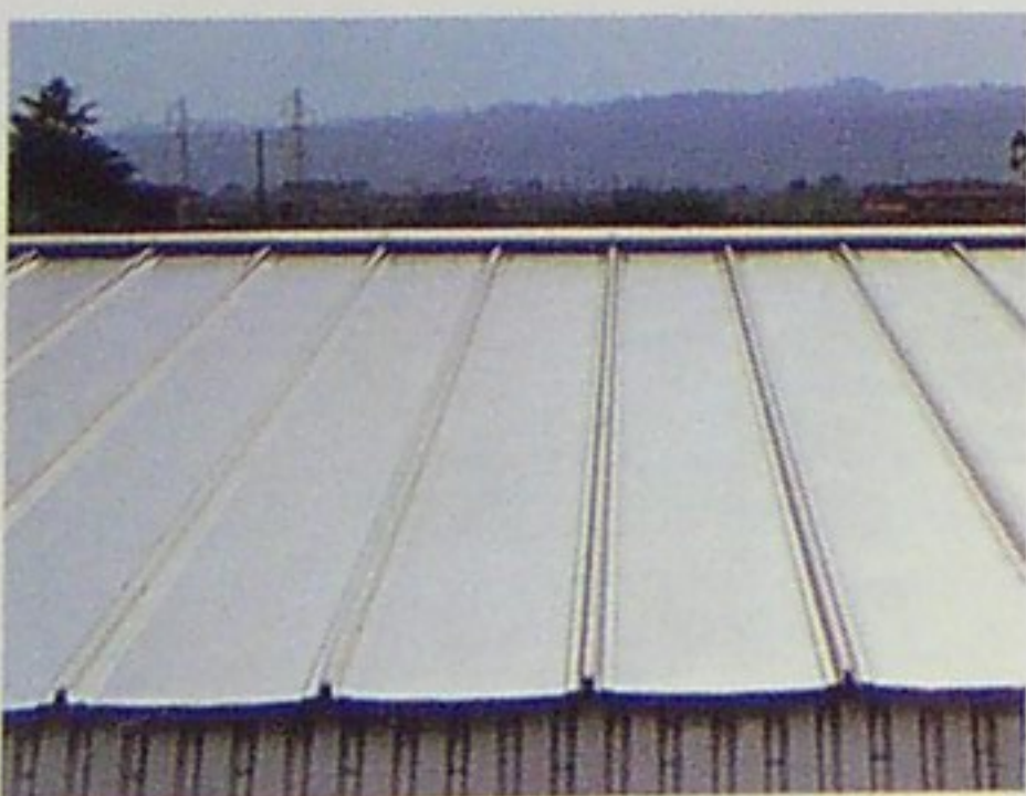
Cubierta en aluminio prelacado; longitud de bandeja 14,60 m; pendiente 3%.
