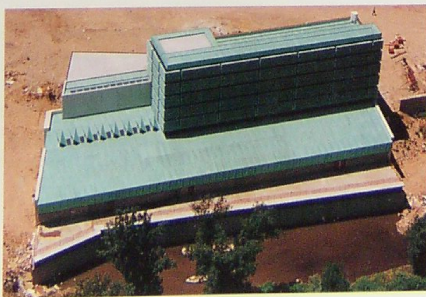
Utilización de Tecu® Patina en la cubierta del Museo de Valladolid. Arquitecto: Rafael Moneo (Instalación: Meta Zinco).
