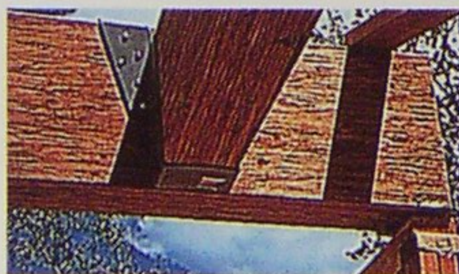
Sus características mecánicas la hacen adecuada para cubrir grandes luces: flexión, 19 N/mm²; tracción axial, 15 N/mm²; compresión axial, 18 N/mm².
