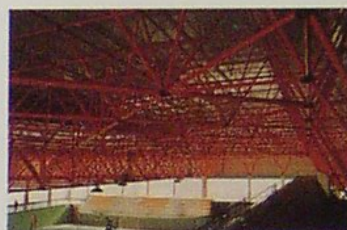
Polideportivo de Jaca. Arquitecto: José Luis Borau.
