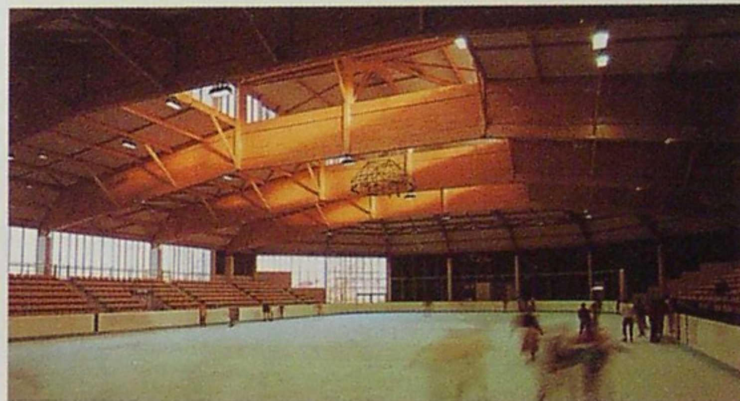
Dado su carácter prefabricado, el montaje de las estructuras de madera laminada encolada es sencillo, y el plazo de entrega muy reducido.
