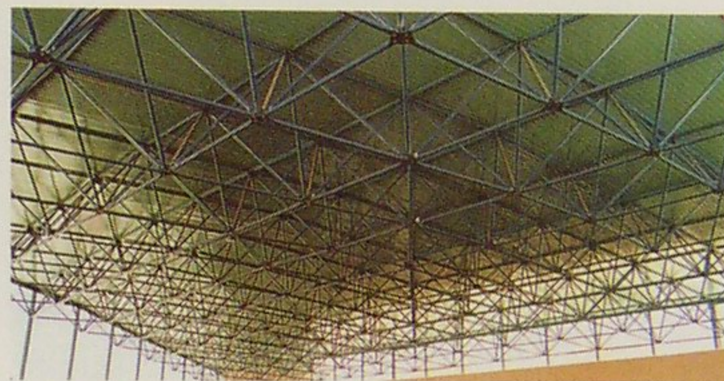
Disco plano para atornillado de barras principales, y disco para diagonales. Todo el montaje se realiza en el suelo, para después izar la estructura hasta los puntos de apoyo.
