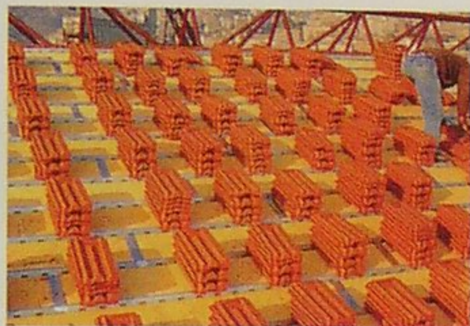
La estructura del panel facilita la correcta puesta en obra de la teja.
