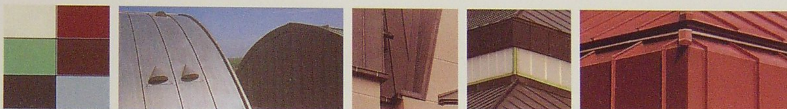
Gama de acabados y su aplicación en obra: de izquierda a derecha: natural, prepatinado Quartz Zinc, prepatinado Anthra Zinc y bilacado marrón teja.
