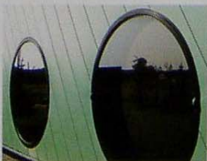
Integración de ventanas en los paneles.
