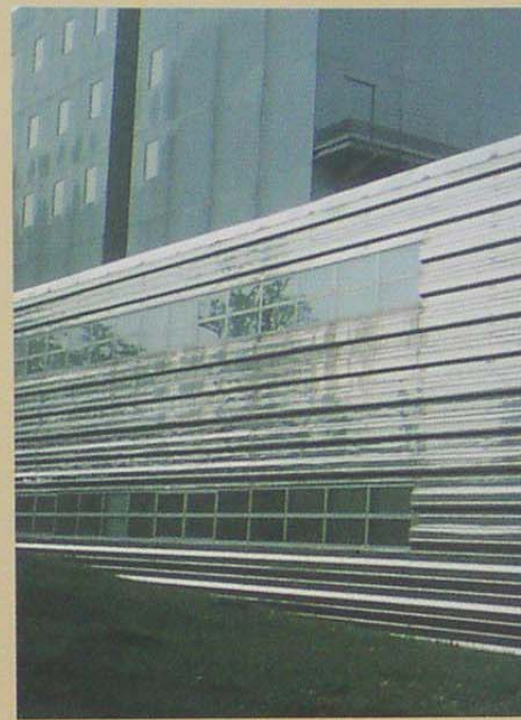
Chapa grecada de acero inoxidable para fachadas tipo Tolartois. La resolución se busca en la geometría de la pieza.
