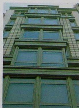
Edificio de oficinas, Higgs & Hill. Arquitecto: Rafael Vila. Cerramiento en aluminio con rotura de puente térmico sistema Termopart y fachada translúcida de piedra ónix sobre estructura ligera de aluminio.
