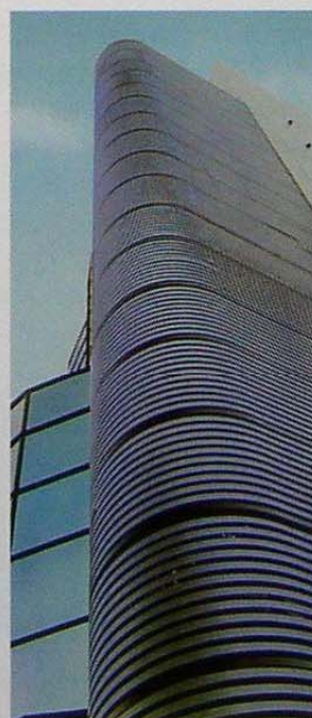
Sistemas de colocación de lamina. Las fachadas con lamina 84R se pueden curvar con un radio mínimo de 50 cm.
