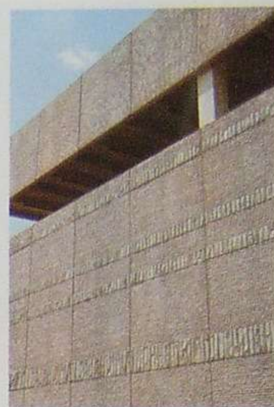
Detalle de panel rayado combinado con bandas moldeadas con elastómeros,
