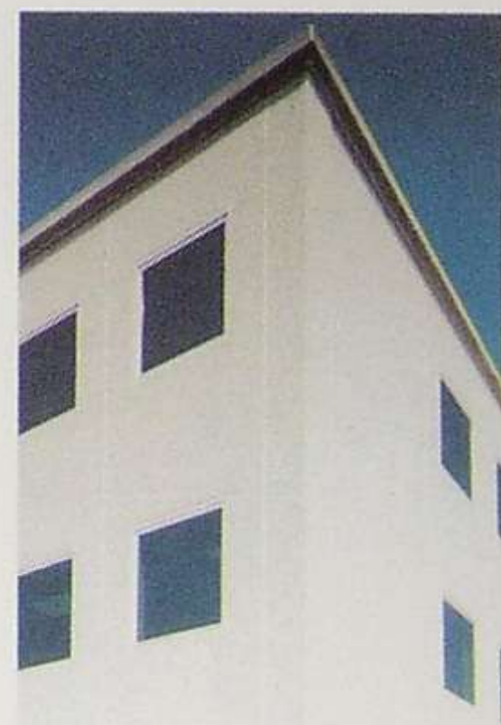
Detalle de esquina con cantonera.
