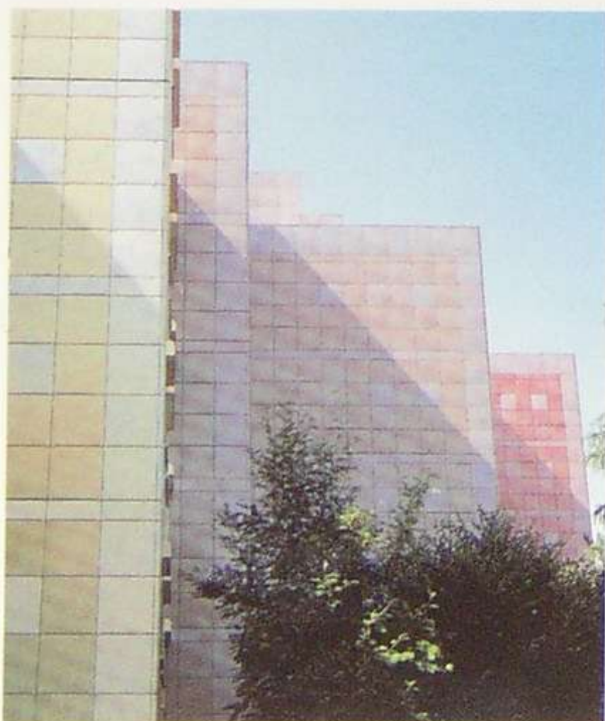
Edificio residencial en Urdorf (Suiza).
