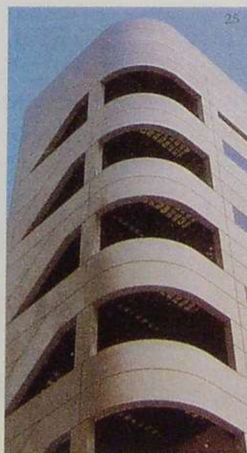
En las imágenes, pueden verse diversas soluciones de petos en esquina: rectas, curvas y achaflanadas.
