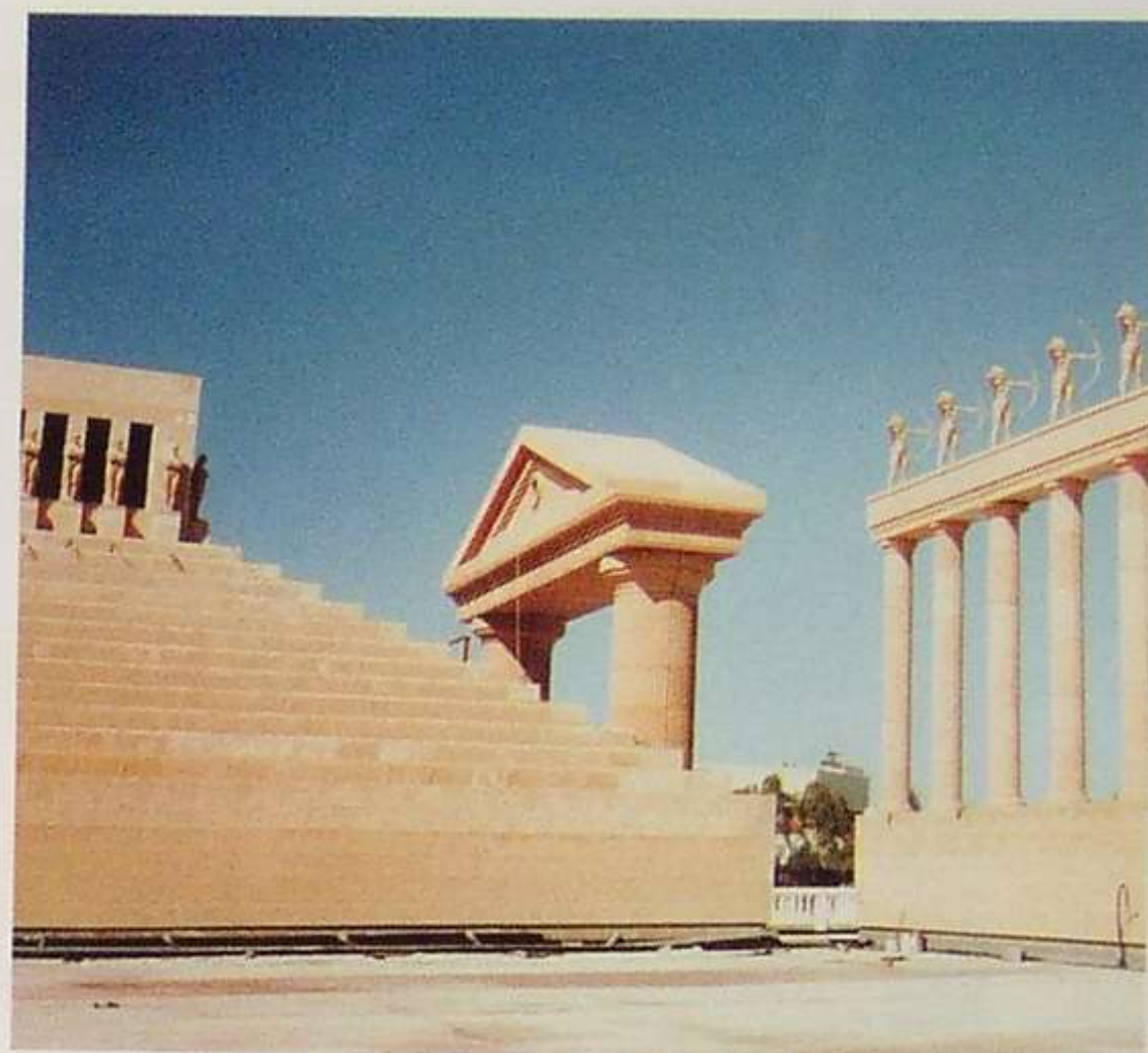
Detalle y vista general del Complejo Mare Nostrum Resort. Fachadas de G.R.C. –en "Lámina Sencilla" coloreada en masa– fabricado mediante proyección manual.
