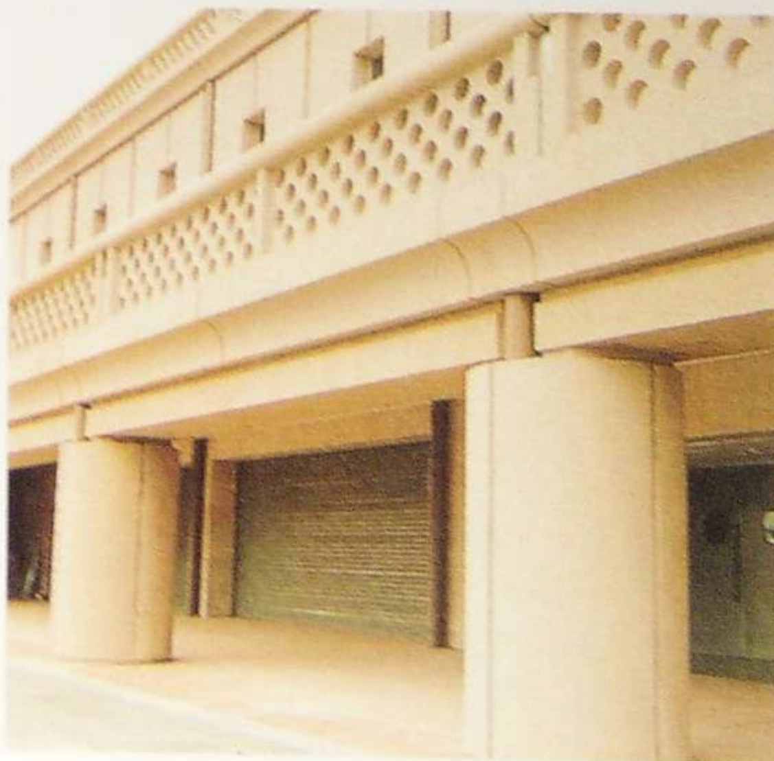
Detalle del Palau Sant Jordi en Barcelona. Arquitectos: Arata Isozaki & Asociados.
