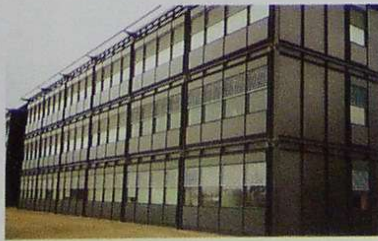
A la izquierda, fachada formada por tableros de Viroclin, solapados y pintados, en una vivienda unifamiliar y edificio de oficinas en Londres. A la derecha tipos de juntas.
