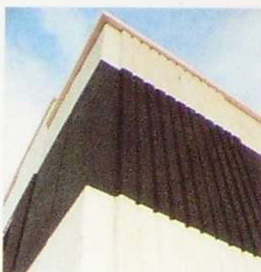
Arriba, detalle de esquina con placa tipo D en posición vertical.
