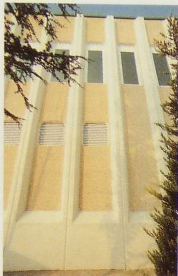
Detalle de panel nervado "Zócalo" instalado.
