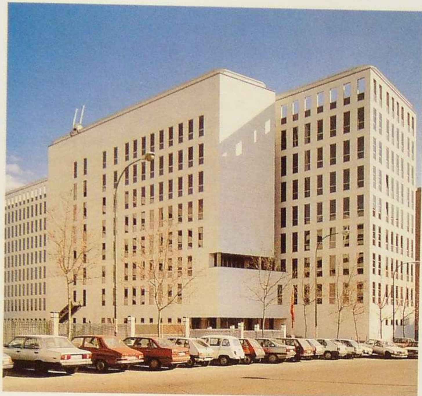
Edificio de Juzgados en Madrid. Restimiento de piedra caliza sobre perfilera de aluminio y acero Alustone.
