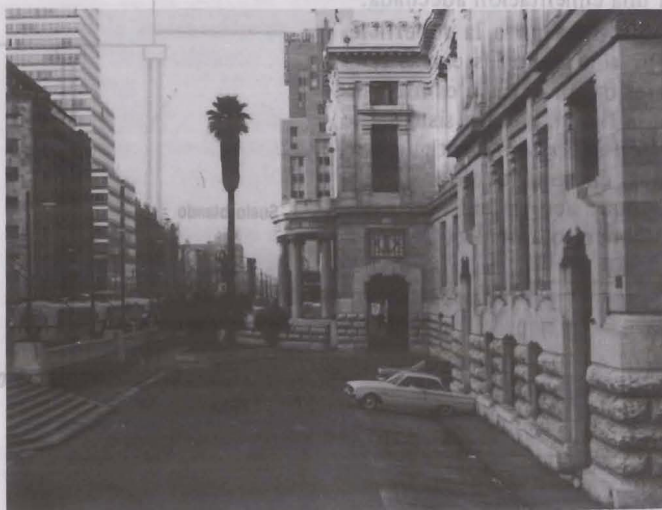
Fig. 1.3. Palacio de las Bellas Artes, ciudad de México. El asentamiento diferencial de 2 m entre la calle y el edificio de la derecha hizo preciso construir una escalinata a la que se iban añadiendo peldaños según progresaban los asentamientos. El hundimiento general de esta parte de la ciudad es de 7 m (fotografía amablemente proporcionada por Raul Marsal)
