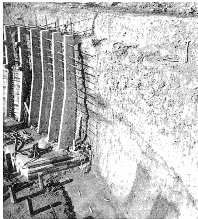
Figura 9.1. Frente vertical de morena glacial rígida en las excavaciones para un muelle seco en South Shields.
