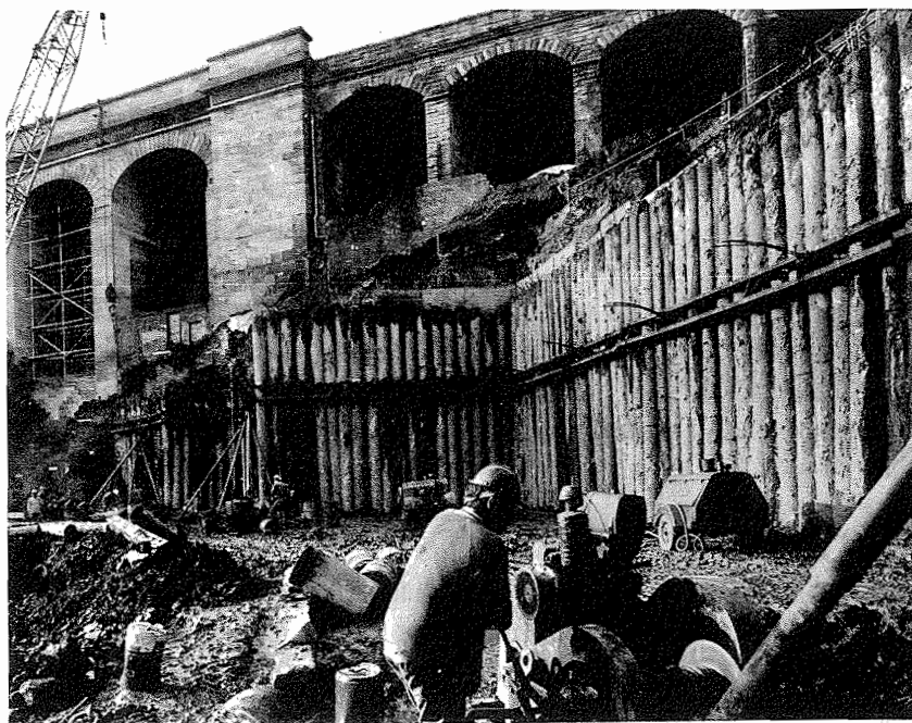
Figura 10.26. Pilotes contiguos perforados usados para soportar una excavación profunda. (Los pilotes se fijan por medio de un sistema de anclajes en tierra y con largueros de acero.)
