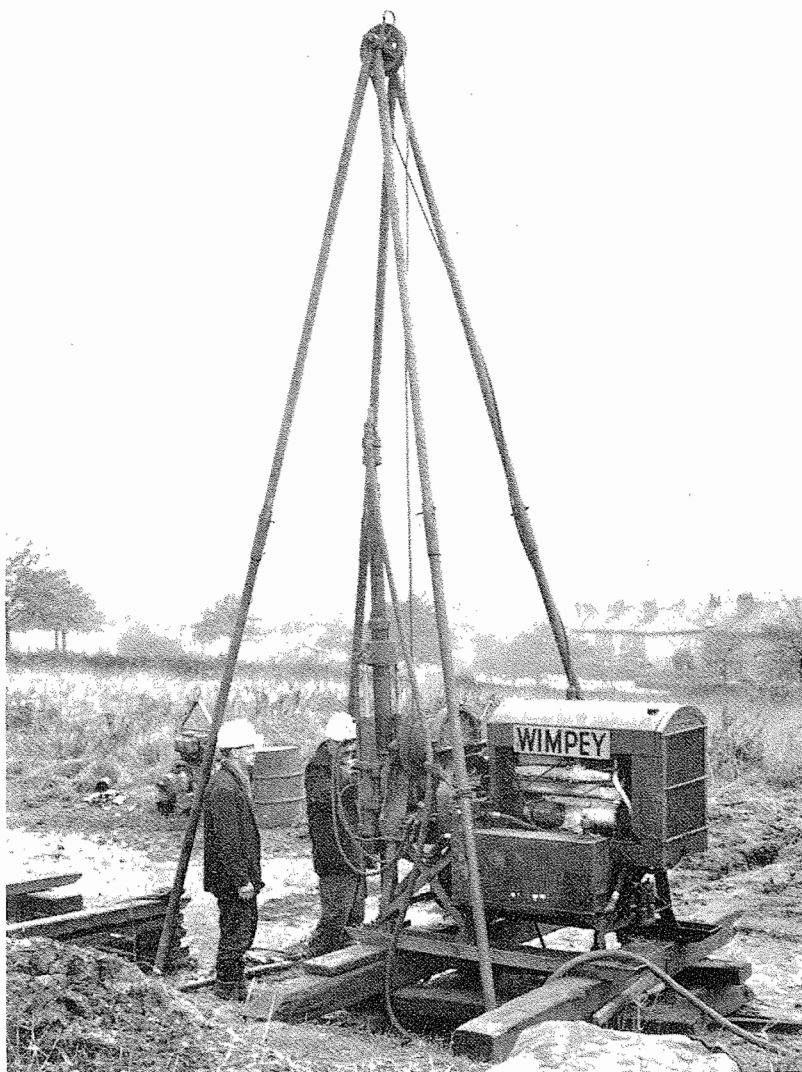
Figura 1.18. Equipo pesado de taladro rotatorio de núcleo de diamante.
