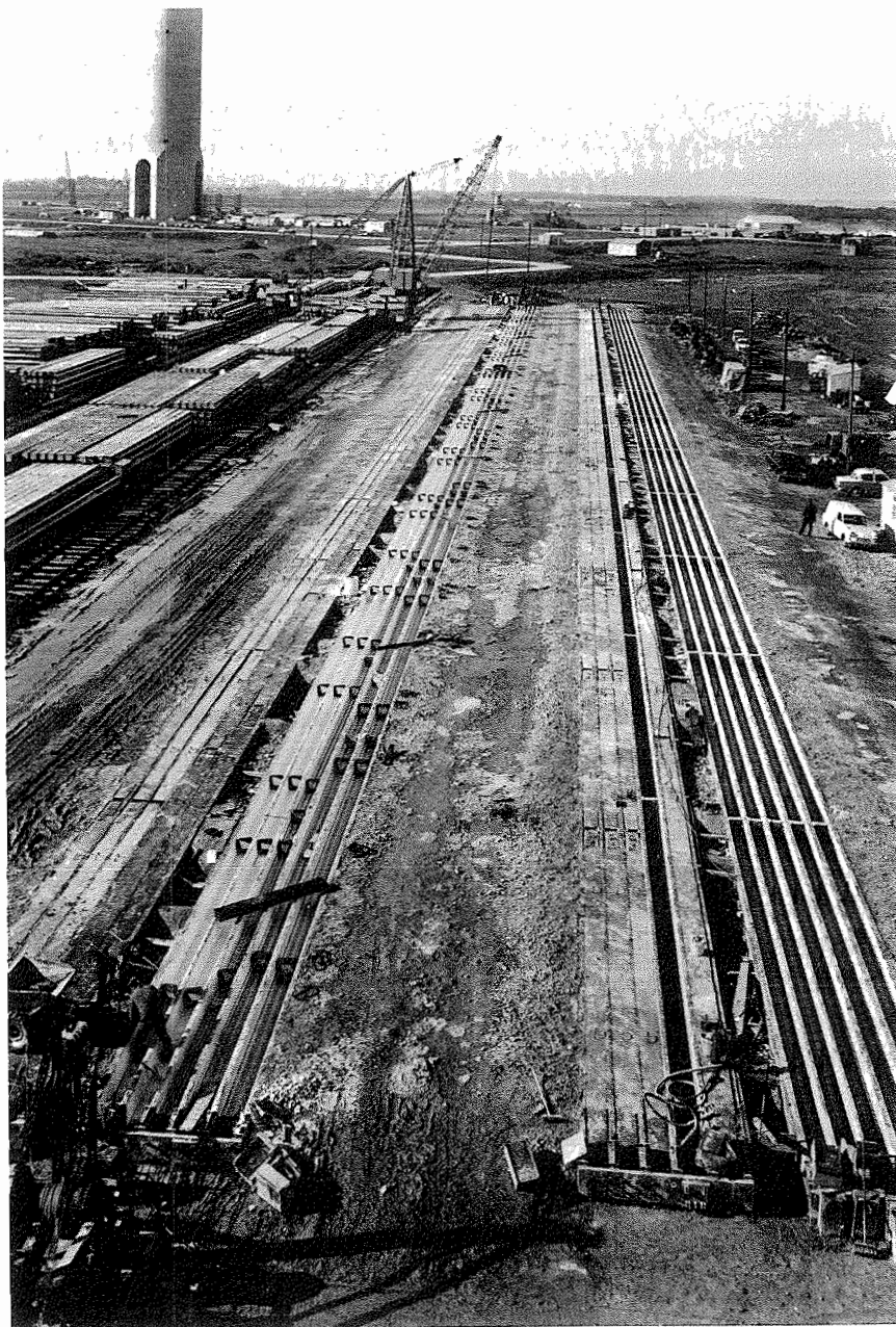
Figura 8.25. Patio de colado para pilotes de concreto precolado en Drax Power Station.
