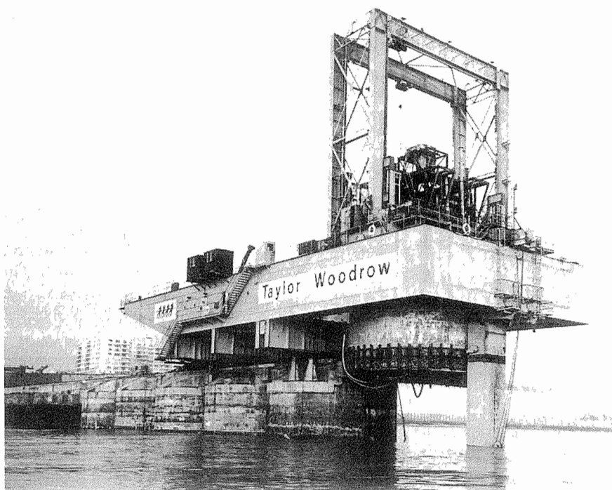
Figura 6.37. Grúa colocando un cajón de caja para el malecón en la Marina Brighton.
