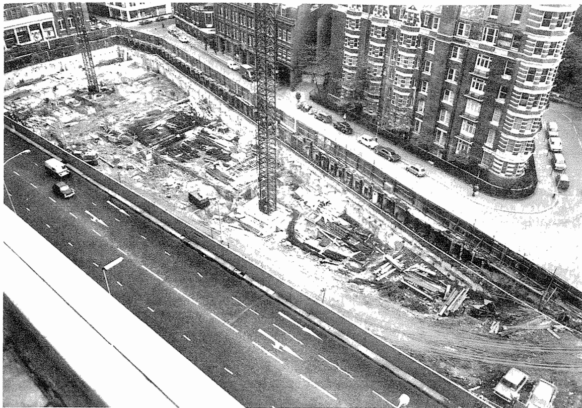
Figura 5.16. Excavación completada para el segundo sótano en la calle Victoria, en Londres. (Note el muro de diafragma rodeando el subsuelo, y la proximidad de los edificios en la plaza Howick.)
