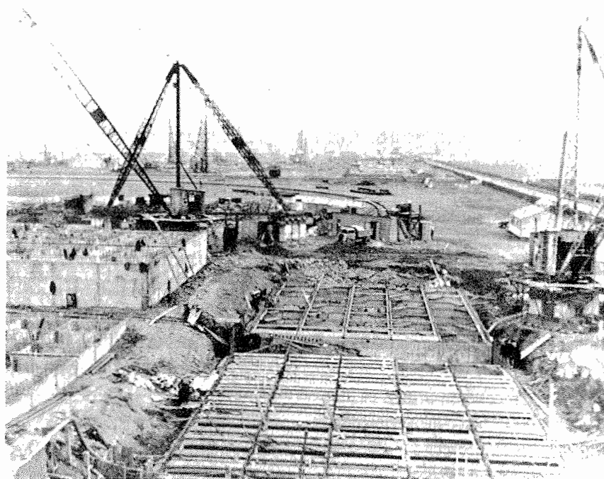
Figura 5.4. Losas celulares de flotación de concreto reforzado formando las cimentaciones para una estación de energía en Grangemouth, Escocia. Dos losas se han hundido en el nivel final, las otras dos están parcialmente hundidas.
