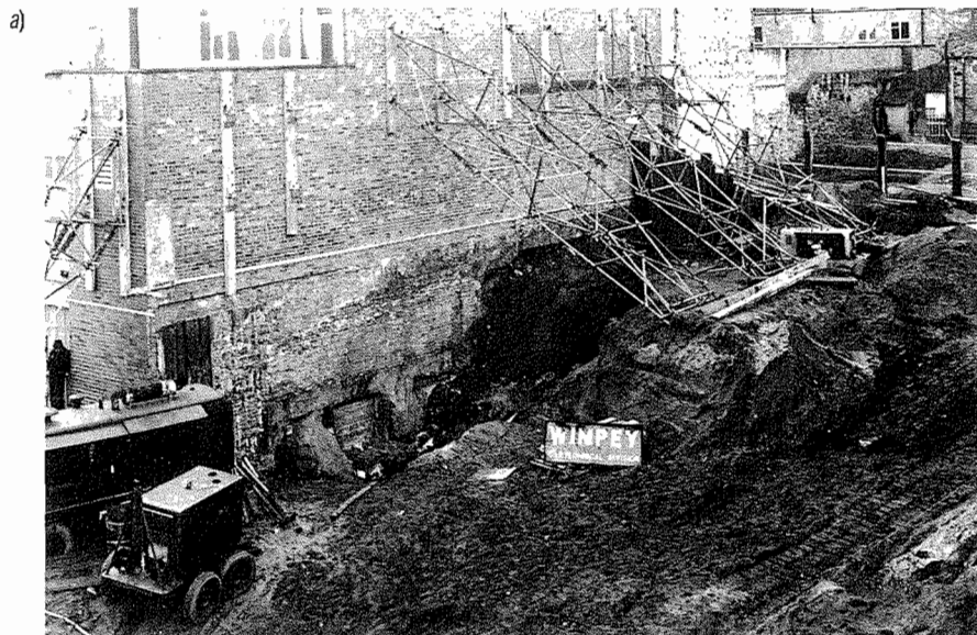
Figura 12.18. Uso de las inyecciones químicas para facilitar el recimentado de un edificio viejo en Kirkaldy, Fifeshire. a) Vista general de un trabajo de apuntalamiento mostrando un muro soportado por puntales tubulares enfilados de acero. b) Excavando en arena fina estabilizada por las inyecciones químicas.
