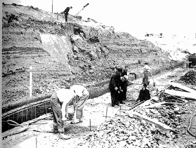
Figura 9.2. Deslizamiento menor desde una pendiente de 1 1/2 en arcilla London fisurada rígida, en Middlesex. Note la apariencia suave de los planos agrietados.
