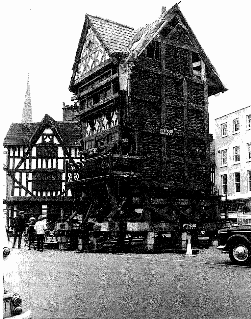
Figura 12.19. Movimiento de un edificio viejo en Hereford. a) El edificio soportado en un chasis de madera temporal antes de moverlo a una nueva ubicación. b) El edificio ya levantado en su posición final.
