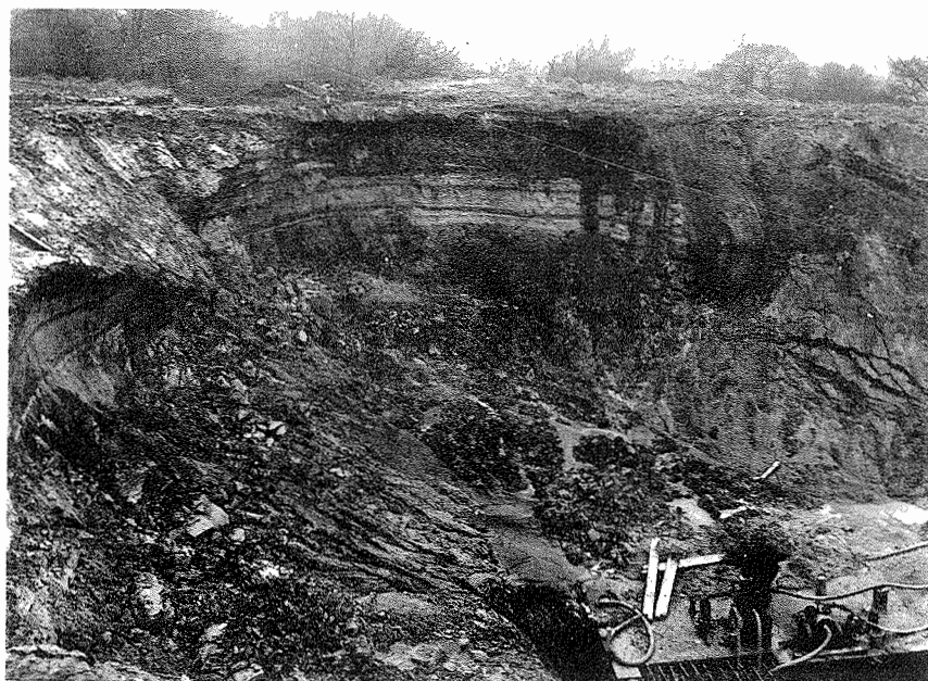
Figura 9.6. Colapso de las pendientes en arena fina de carga de agua entre una capa de arcilla y limo, Co. Durham.
