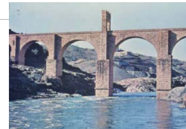
PUENTE-ACUEDUCTO DE ALCÁNTARA
