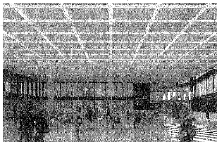
SISTEMA DE LOSA CASETONADA CUBRIENDO GRANDES LUCES
