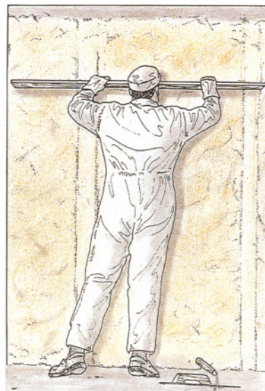
15. Enrasado del mortero del cajón.
