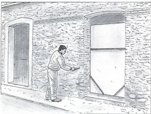
1. Después de picar el paramento, se cepilla y limpia con agua a presión.
