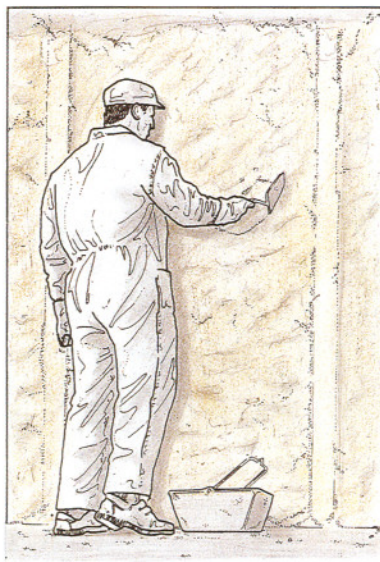
14. Paletado del cajón.
