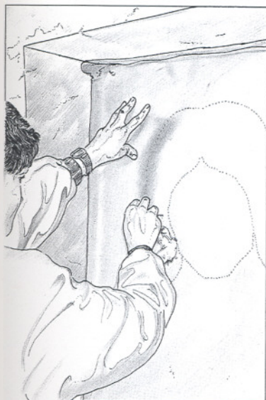
10. Estarcido del dibujo sobre el arriccio .
