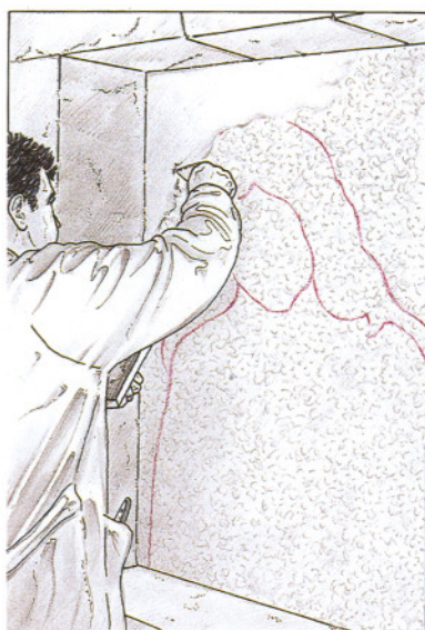
13. Aplicación en la jornada del fondo de la capa de masa grasa del intonaco .
