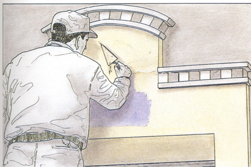
9. Aplicación de la segunda capa de masa magra del enlucido.
