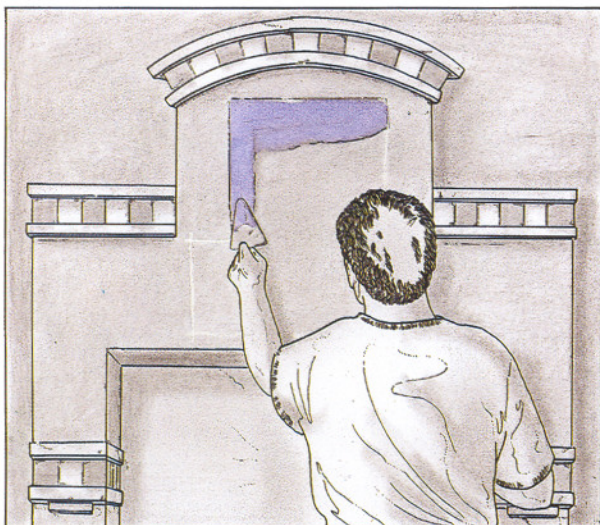
1. Aplicación de la primera capa de masa magra.
