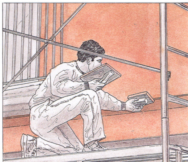
13. Perfilado de las aristas con fratás.
