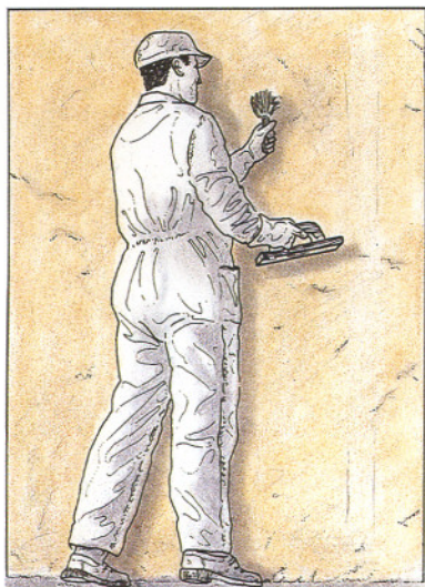
21. Humedecido del muro.
