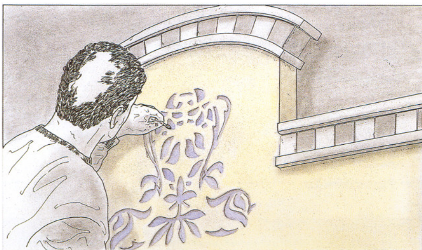
17. Limpieza de los fondos del esgrafiado.
