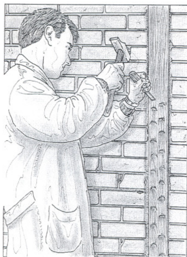
2. Picado de las vigas de madera con punzón.
