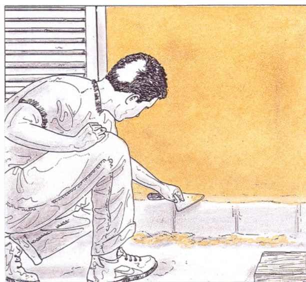
36. Remate del zócalo con el paletín.
