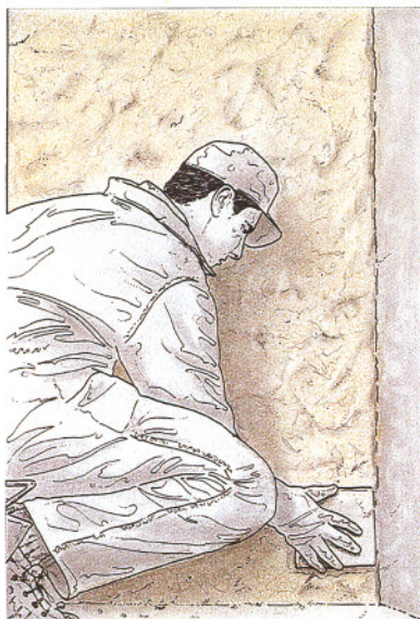
9 y 10. Colocación de los primeros tientos con piezas cerámicas.
