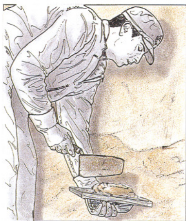
18. La masa de la penúltima capa se tiende con la talocha.
