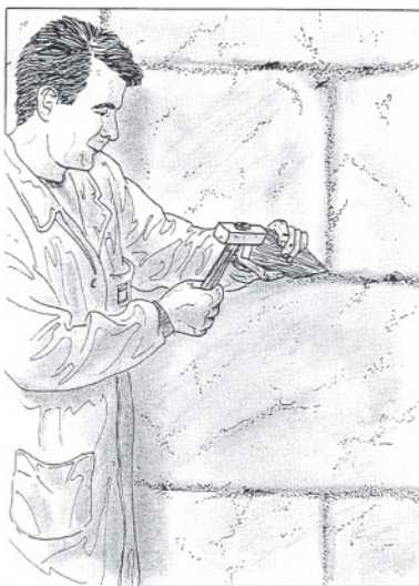
7 y 8. Disposición de cuñas sobre un muro de tapial.
