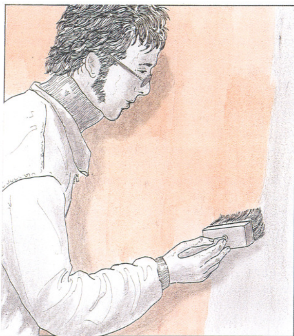
17 y 18. Para lograr cubrir de color un paramento con pintura aguada son necesarias varias manos (un máximo de ocho), aplicadas a plomo y a nivel.
