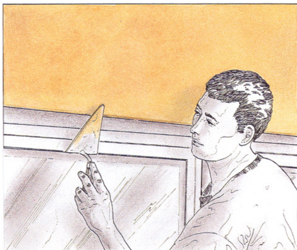
31. Acabado final con el paletín.
