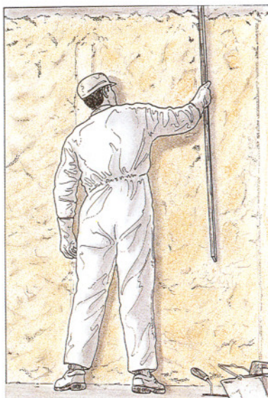
16 y 17. El paramento se recorre horizontal, vertical y oblicuamente para nivelar la masa del cajón.
