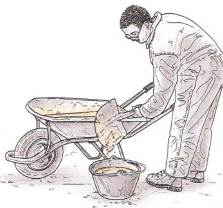
5. Traspaso del mortero de la carretilla a la gaveta.
