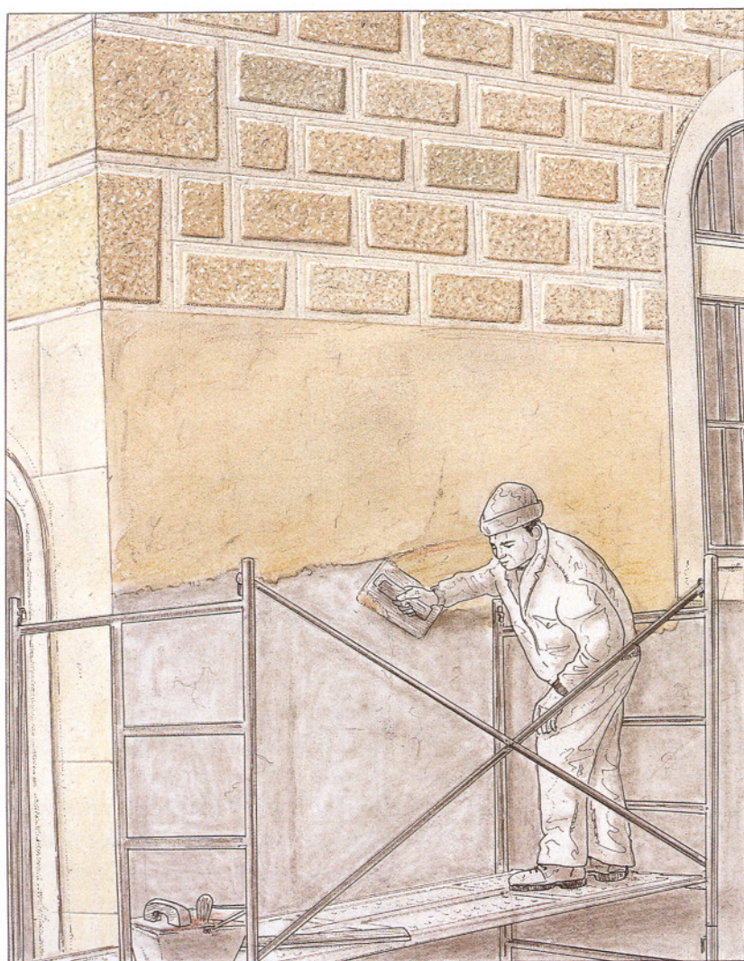
1. Repretado de la segunda capa del estuco labrado.
