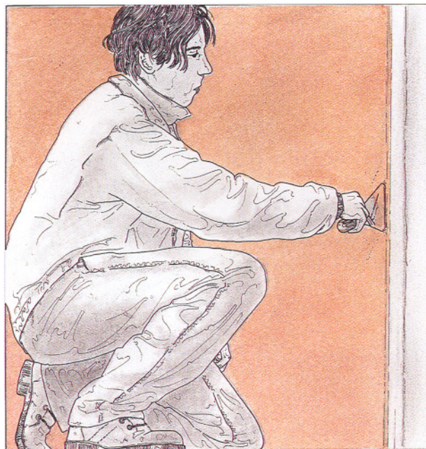
10. Perfilado de los rincones con paletín, en el tendido de la segunda capa.
