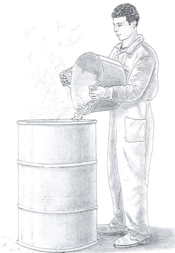
1. Vertido de los terrones de cal viva en un bidón limpio y con agua.
