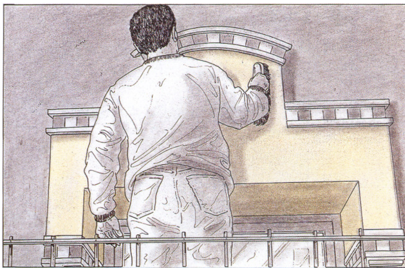
12. Cepillado del paramento.
