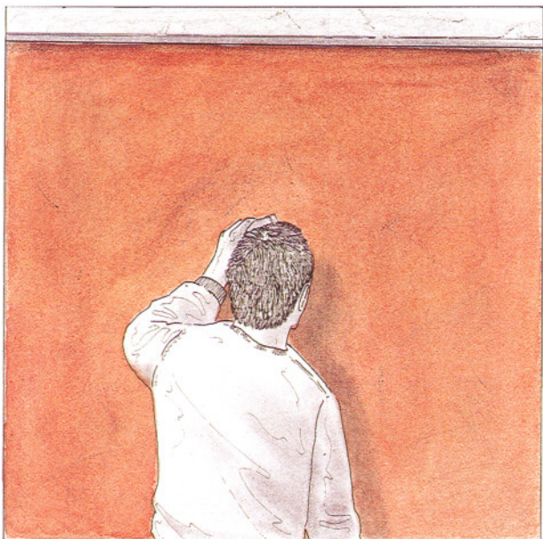
3. Fratasado de la segunda capa de masa magra.
