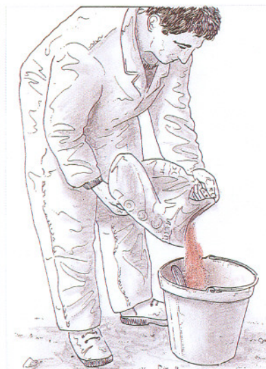
4. Vertido del color en medio cubo de agua.
