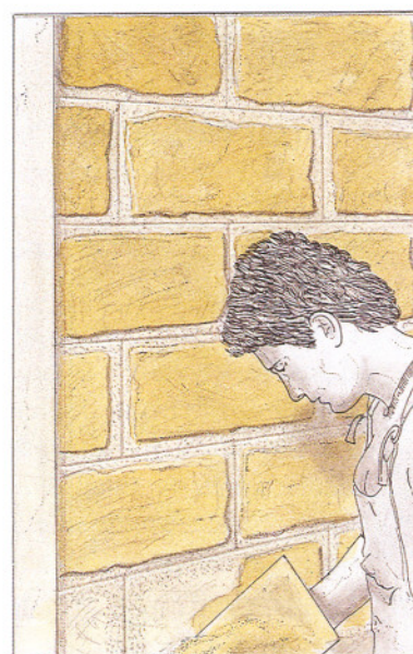
4. Aplicación de la primera masa de carga.
