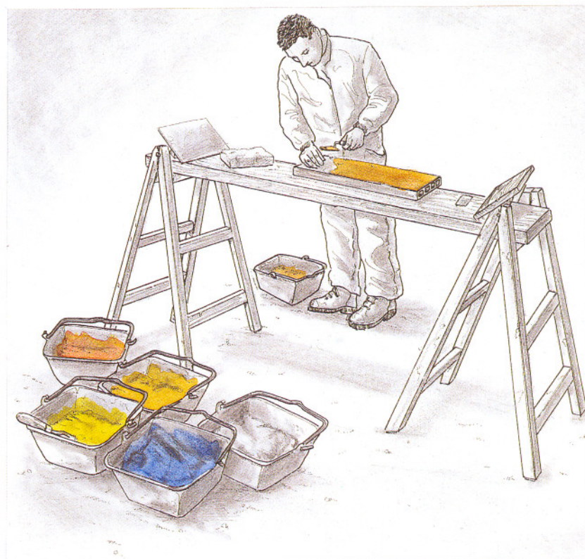
6. Ejecución sobre rasillas de muestras de estuco labrado, estuco enlucido y pintura de cal.
