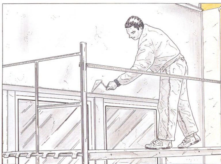
2. Con la paleta, se eliminan las partículas de mortero mixto no adheridas al muro.
