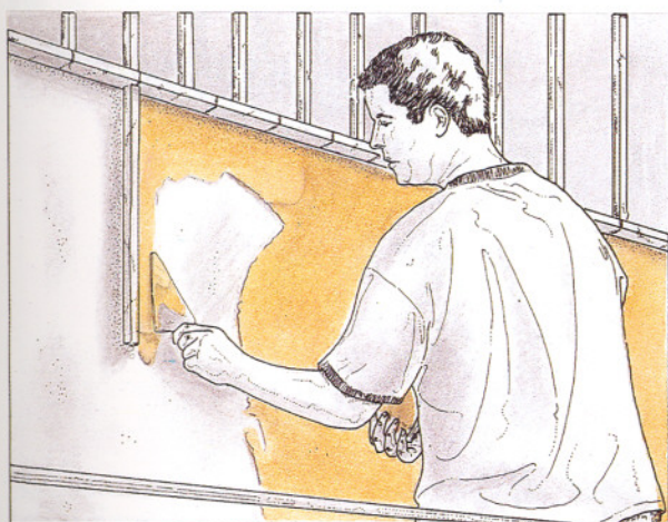
8. Manejo del paletín en el tendido de la primera capa.
