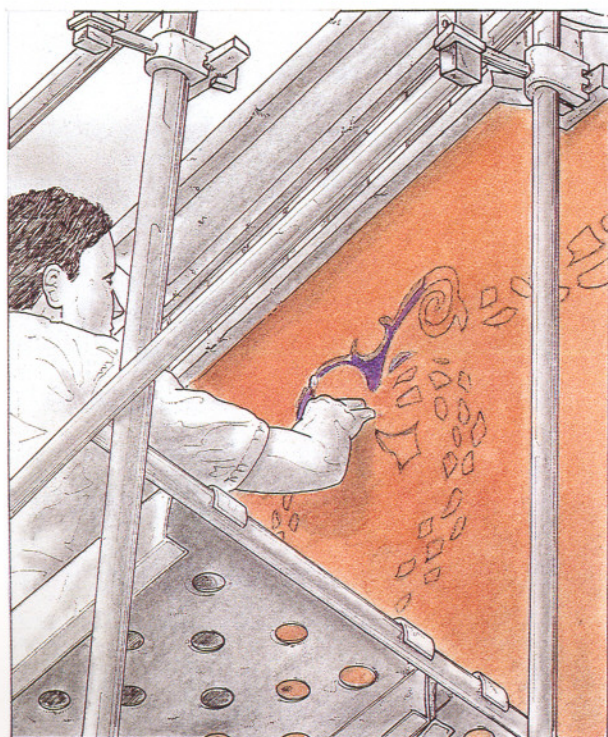
6. Vaciado de los fondos del esgrafiado.
