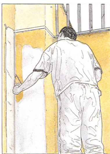
12, 13 y 14. Aplicando masa con el fratás y palustrillo en una esquina del paramento.
