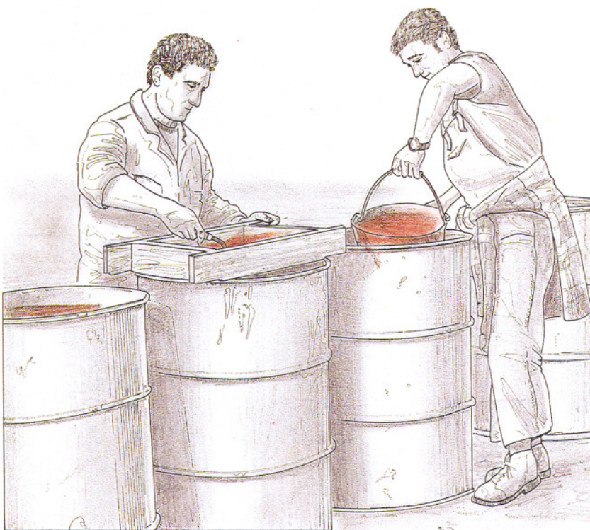
16. Tamizado y mezclado de la cal teñida de los 5 bidones.
