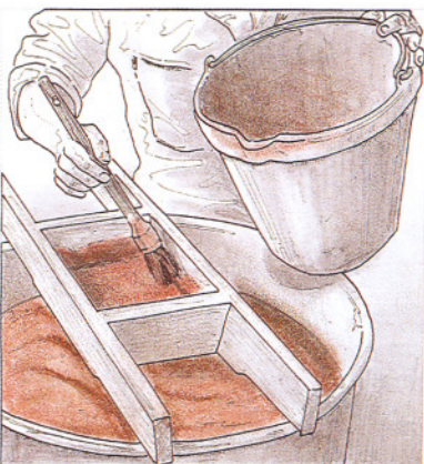
9. Los dos litros de agua se incorporan a la mezcla.
