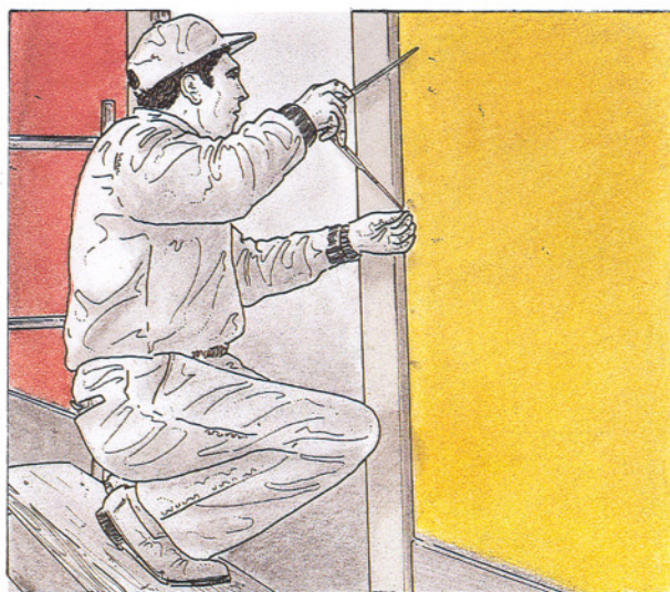
5. Con el compás se marcan las alturas de las hiladas.
