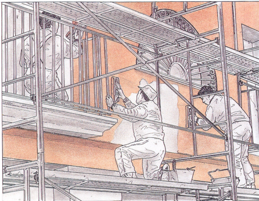
7. Aplicación de la primera capa de masa magra en la primera planta del edificio.
