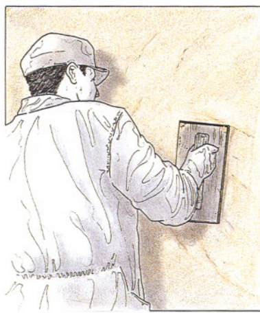
19. El paramento se trabaja después con el fratás.
