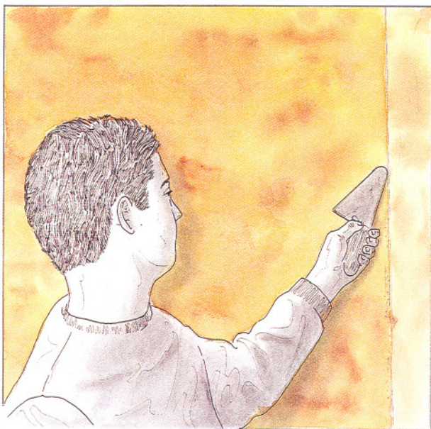
9. Perfilado de los rincones.
