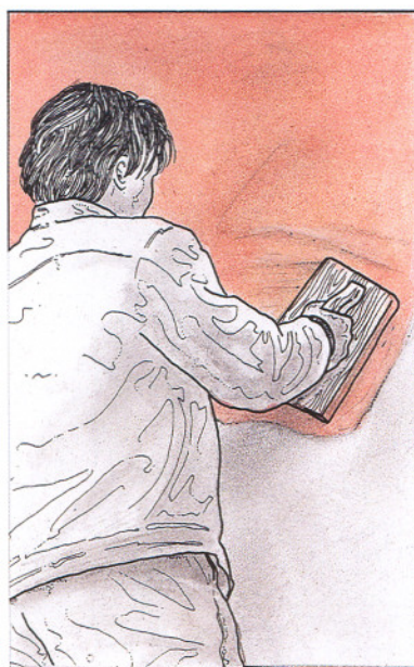
4. Aplicación de la primera capa con fratás.
