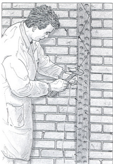
4. Martilleo de los clavos de sujeción.
