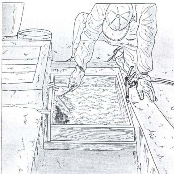
9. Tamizado de la cal apagada.
