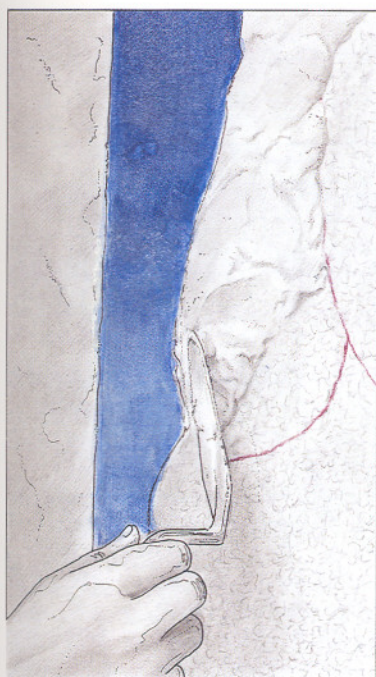
21. Aplicación de la capa de masa grasa del intonaco sobre la jornada del cabello.
