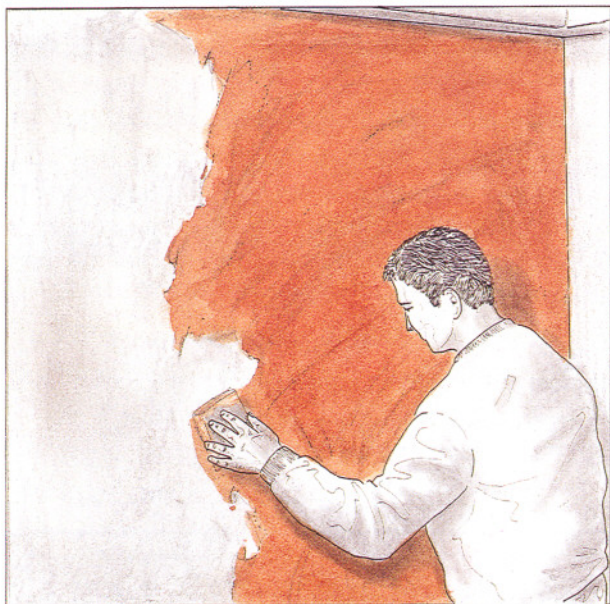
1. Aplicación de la primera capa de masa magra.
