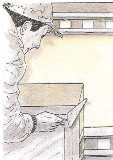
10. Perfilado de las aristas con el paletín.
