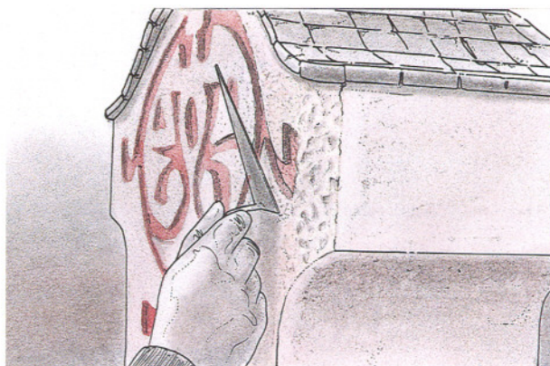
7. Ejecución de la textura escodada con el gavilán del paletín.
