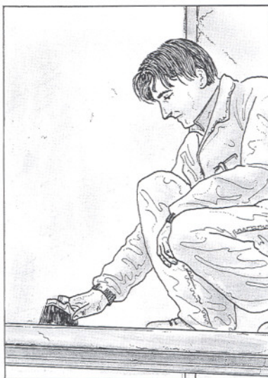
2. Barrido de la plataforma metálica.
