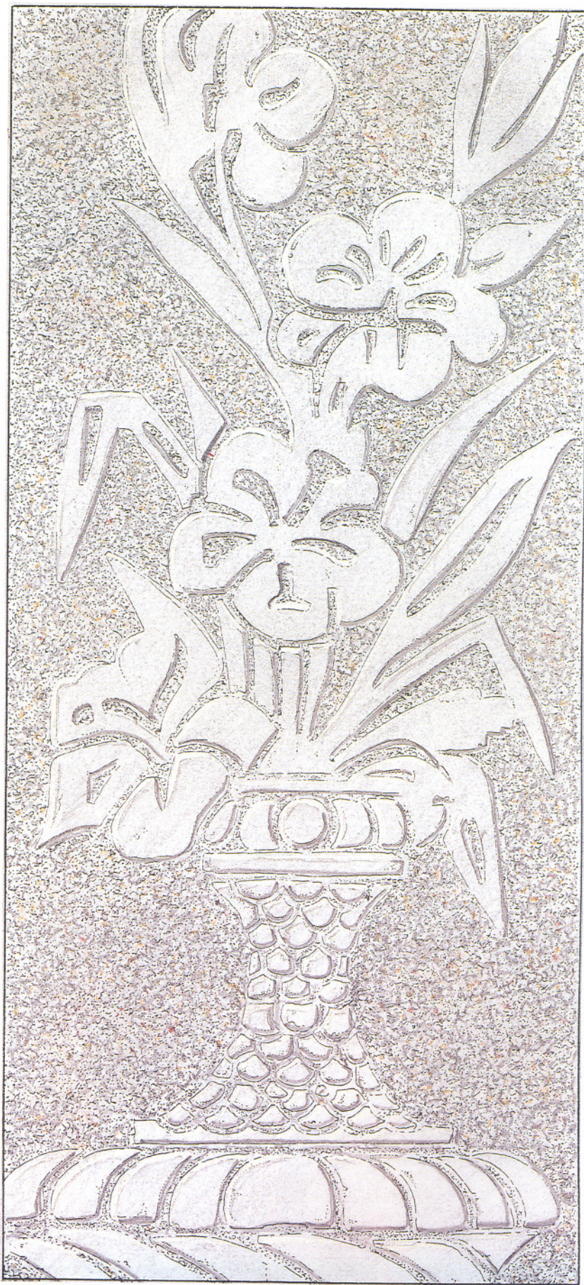
6. Esgrafiado ejecutado según la técnica antigua o barroca.
