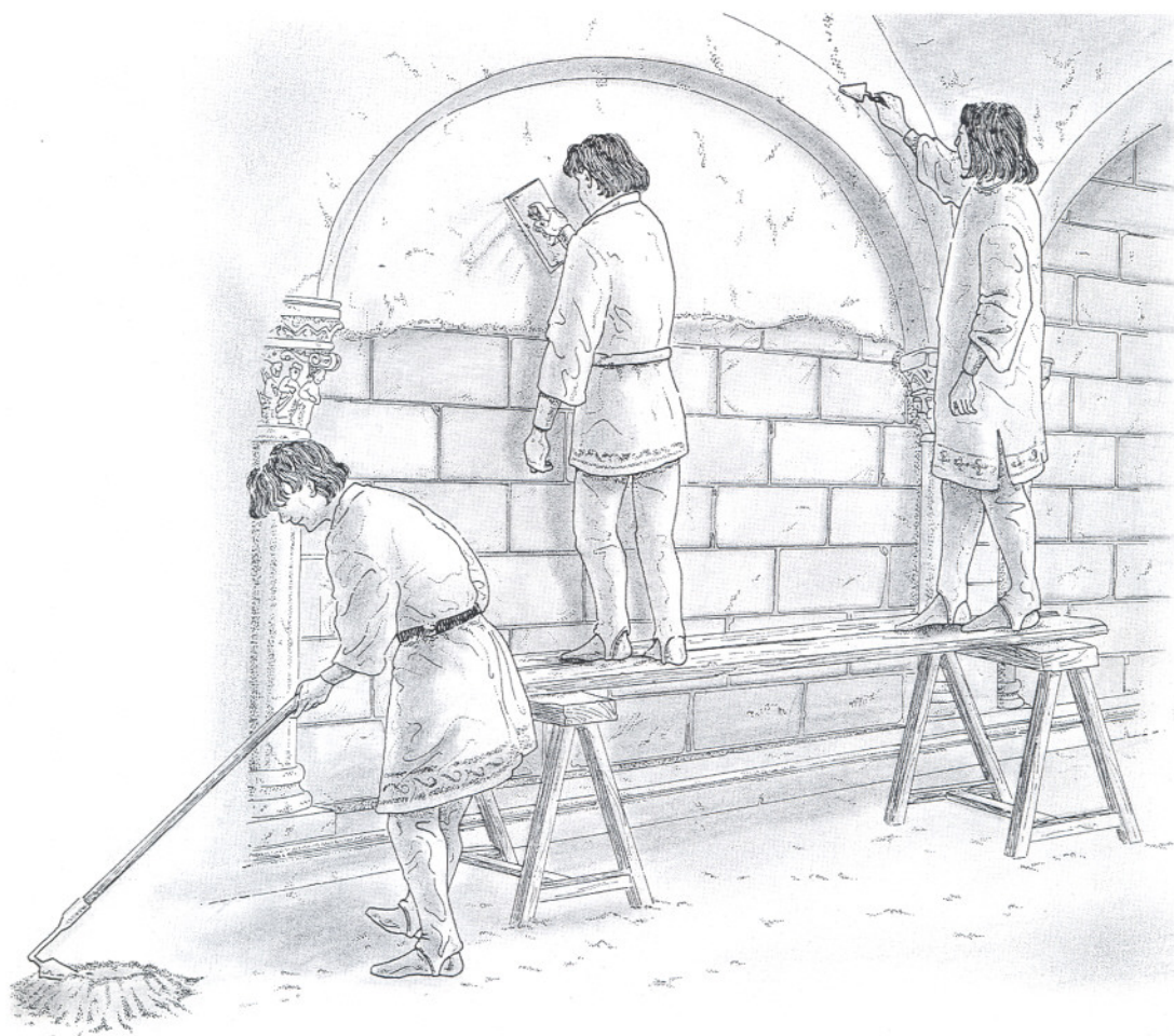
1. Reconstrucción ideal de la ejecución de un fresco románico en el Panteón de los Reyes (San Isidoro, León). La base de la pintura al fresco es un enlucido realizado con cal grasa, arena y polvo de mármol.
