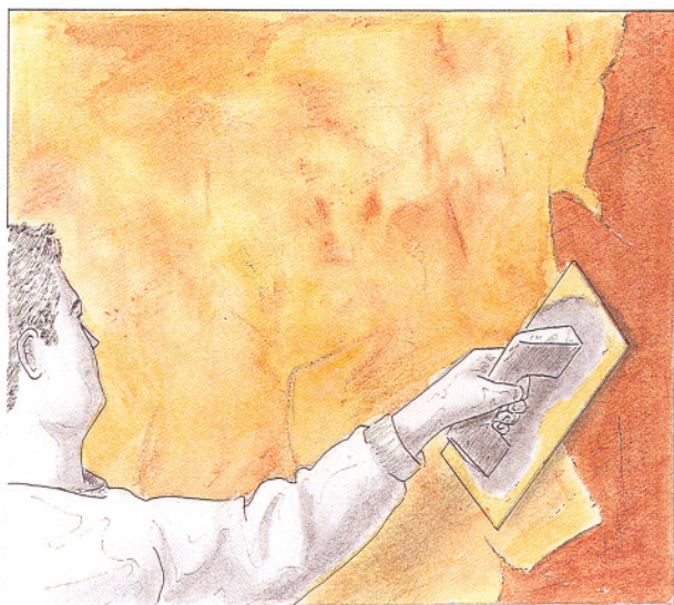
7. Aplicación con la llana de la tercera capa en el resto del paramento.
