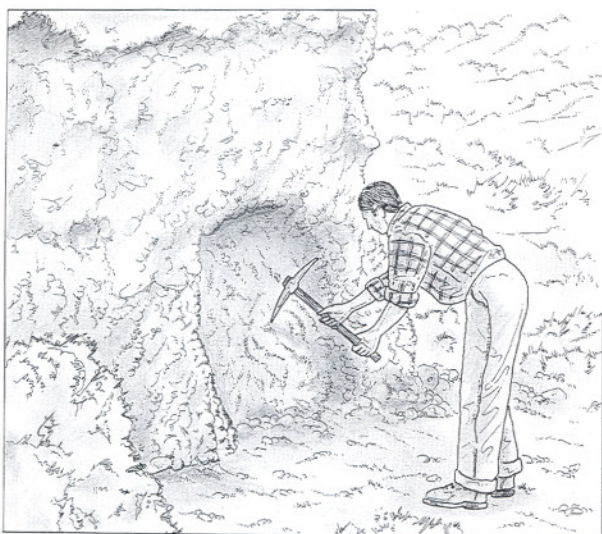
2. Desbroce de la ladera para un horno excavado.
