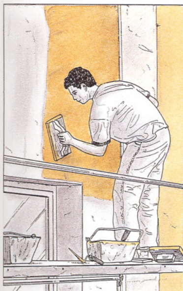
5 y 6. Tendido de la primera capa con el fratás de madera.
