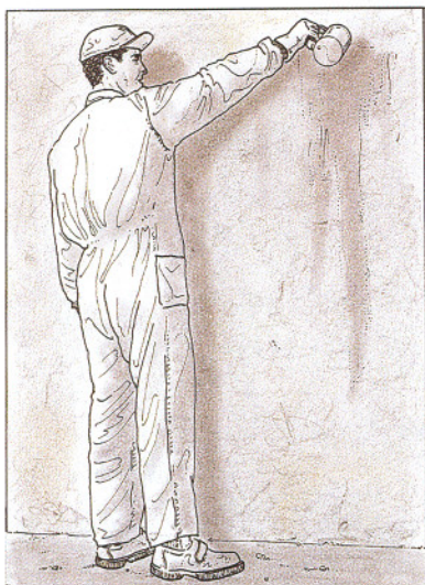
6. Humectación del muro.
