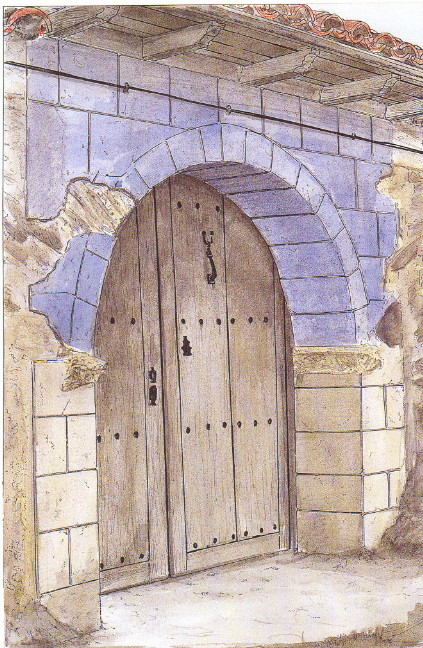
1. Portalón ornamentado con un falso despiece de sillares. Santiagomillas. León.
