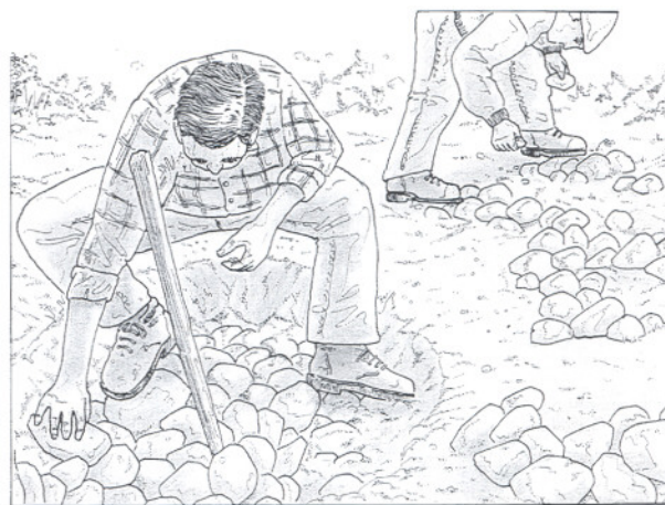
7. El horno se cierra a unos 20 ó 30 cm por encima del nivel del suelo.
