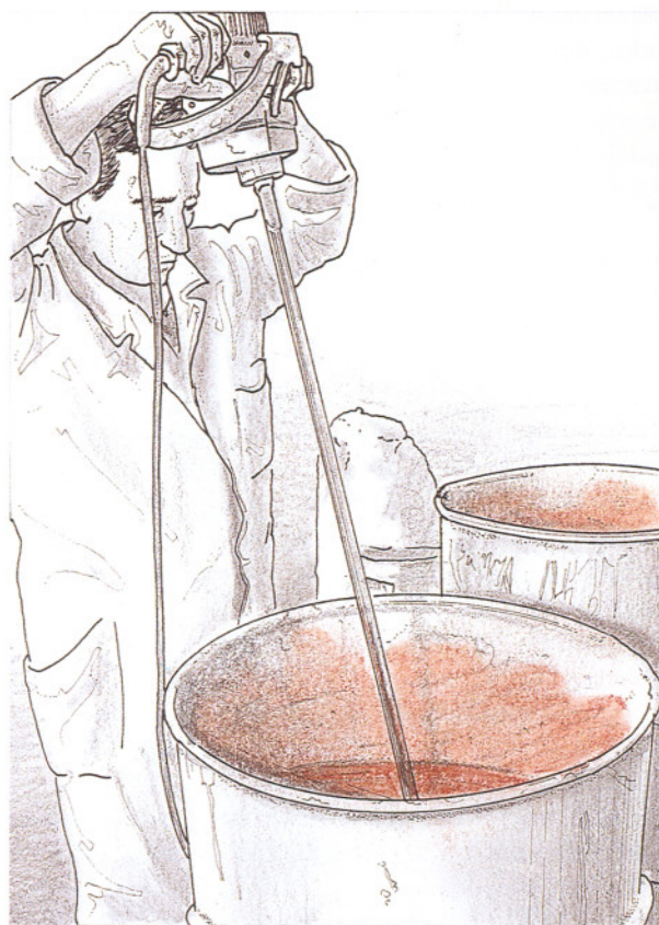
2. Batido de la mezcla de cal teñida y árido.
