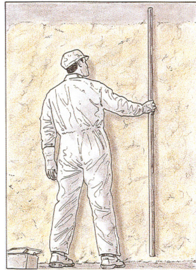
8. Con la regla o "jaharro" se elimina el exceso de mortero.
