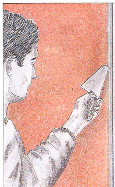
5. Perfilado de rincones con paletín.
