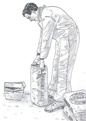
2. Apertura de los sacos de hidrato de cal.
