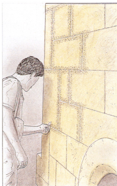
3. Labrado con la sierra a plomo.
