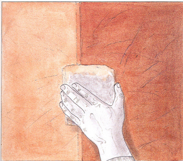
5. Trabajo de las aristas con el fratás de poliestireno.
