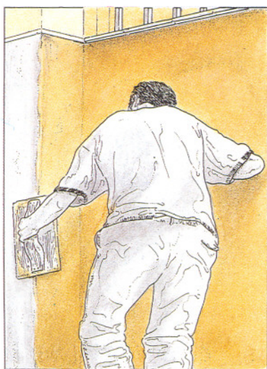
12, 13 y 14. Aplicando masa con el fratás y palustrillo en una esquina del paramento.
