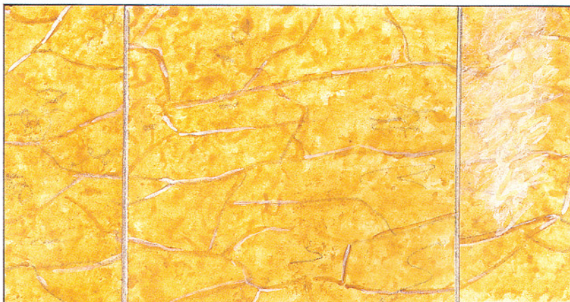
12. Zócalo de aspecto marmóreo realizado con la técnica del estuco planchado.
