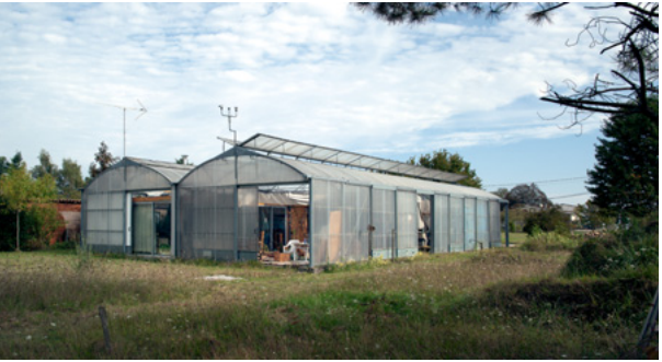
CASA EN COUTRAS HOUSE IN COUTRAS Gironde, France. 2000
