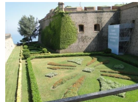
Límite construido. Muralla Castell de Montjuic. Barcelona. Foto: Mgtr. Arq. Diana Cohen
