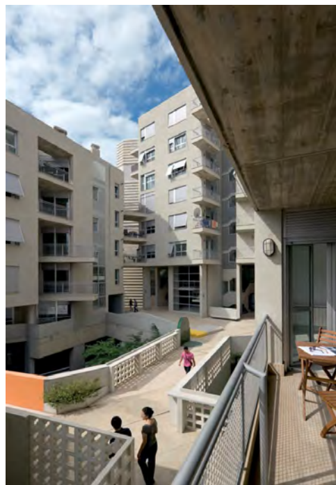
Edificio 111 / Arqs. R. Flores y Eva Prats / Barcelona
