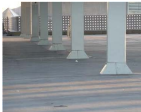
Fig. 16 – Izq.: articulacion. Der.: empotramiento
