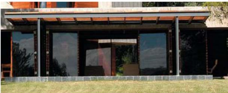
Fig. 11 – Pórtico metálico con extremo superior de columnas articuladas
