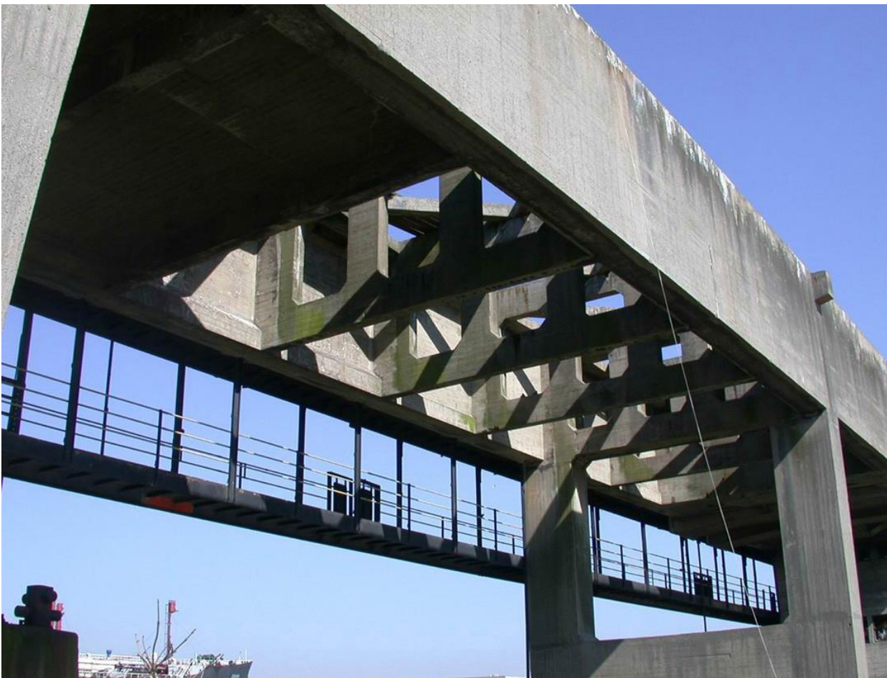
5 pórticos de 2 vanos separados por juntas de dilatación
