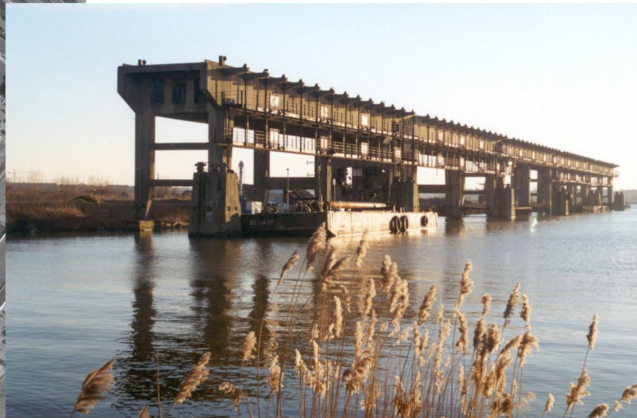
Monumento industrial, construido en 1952, en hormigón armado, con una longitud total de 270 metros, una altura de 13,5 metros y una ancho de 8,7 metros, en la costa de Amsterdam sobre el río IJ.
