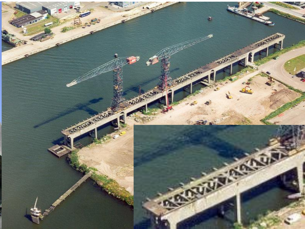
5 pórticos de 2 vanos separados por juntas de dilatación
